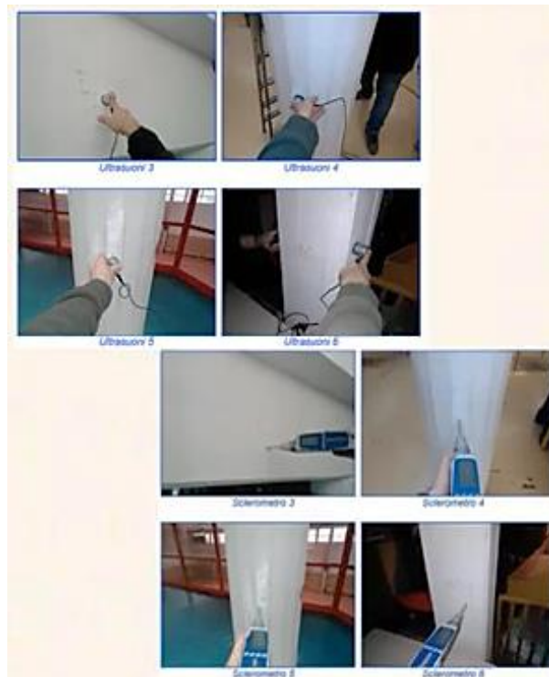
Fig. 9 Immagini dei punti di indagine con le prove Sonreb
