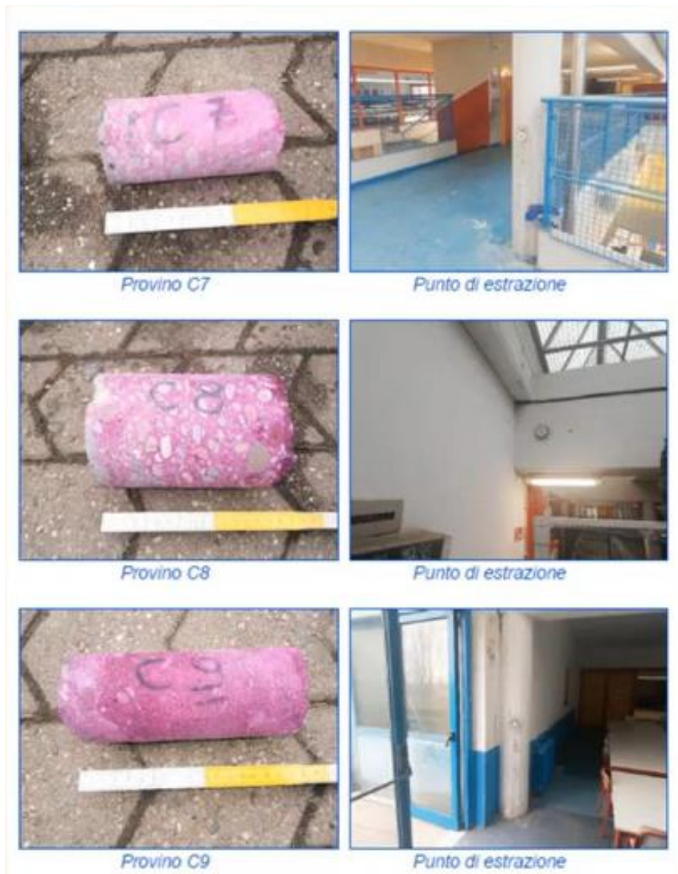
Fig. 8 Scheda 2: Immagini dei provini cilindrici in calcestruzzo prelevati dalle travi e dai pilastri e immagini dei relativi punti di estrazione dalla struttura
