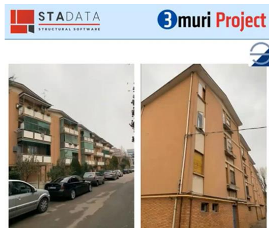
Fig. 1 Foto dei prospetti frontale e laterale del fabbricato analizzato
