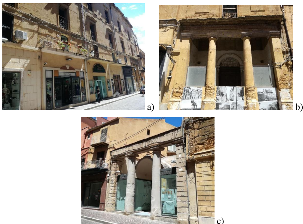
Figura 2. Foto del Corpo 1: a) prospetto su Via Atenea; b) portale monumentale di ingresso; c) portale monumentale del cortile Martorella.
