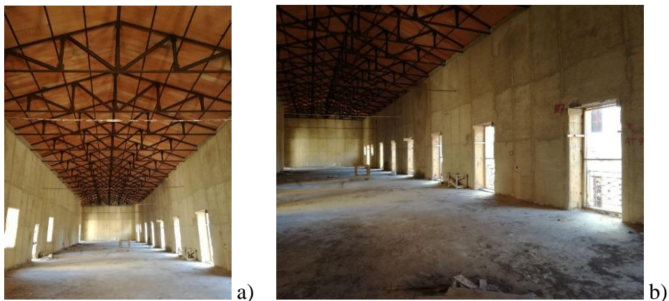
Figura 7. Copertura del Corpo 1 con capriate metalliche.
