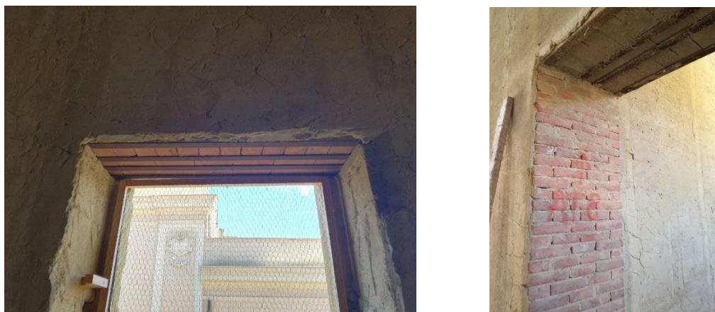
Figura 6. Tipologia di architrave con putrelle presenti nel Corpo 1: a) Architrave finestra; b) Architrave porta.
