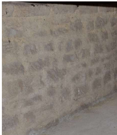
Fig.2.19 Particolare muratura nel piano sottotetto
