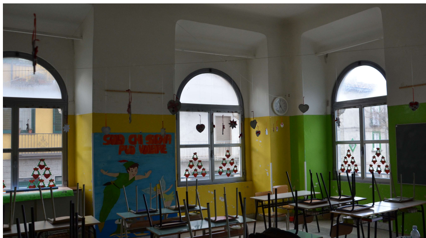
Fig. 7.1 Finestre in un aula d'angolo al piano rialzato.
