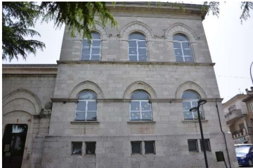
Fig. 2.11 Paramento esterno, mura perimetrali.
