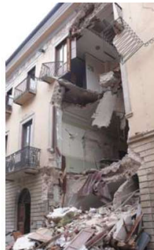
Fig.6.8b Flessione verticale di parete
