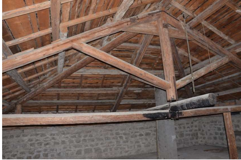
Fig. 2.15 Foto di un padiglione della copertura
