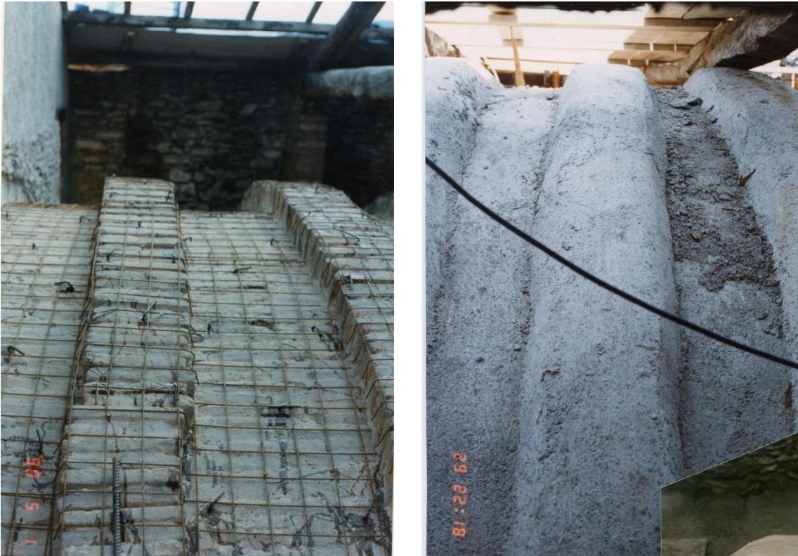
Fig.5 - Disposizione della rete elettrosaldata e risultato finale dopo il getto di calcestruzzo proiettato
