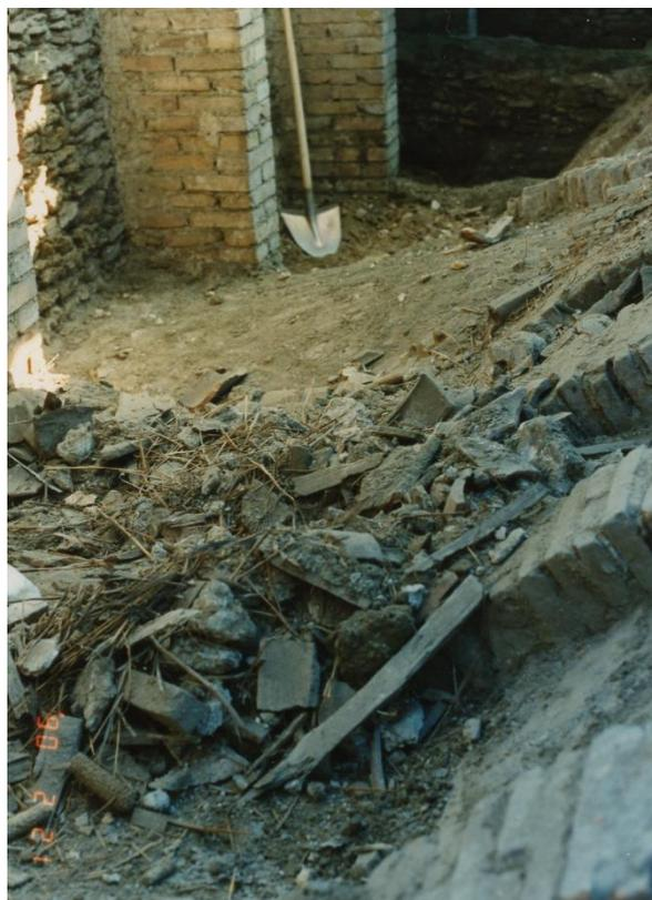
Fig.4 - Pulizia dell'estradosso della volta
