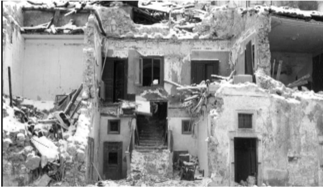
*Figura 6 Teora, terremoto 1980, danno di primo modo per edificio con solaio ligneo ordito parallelamente alla parete crollata.*
