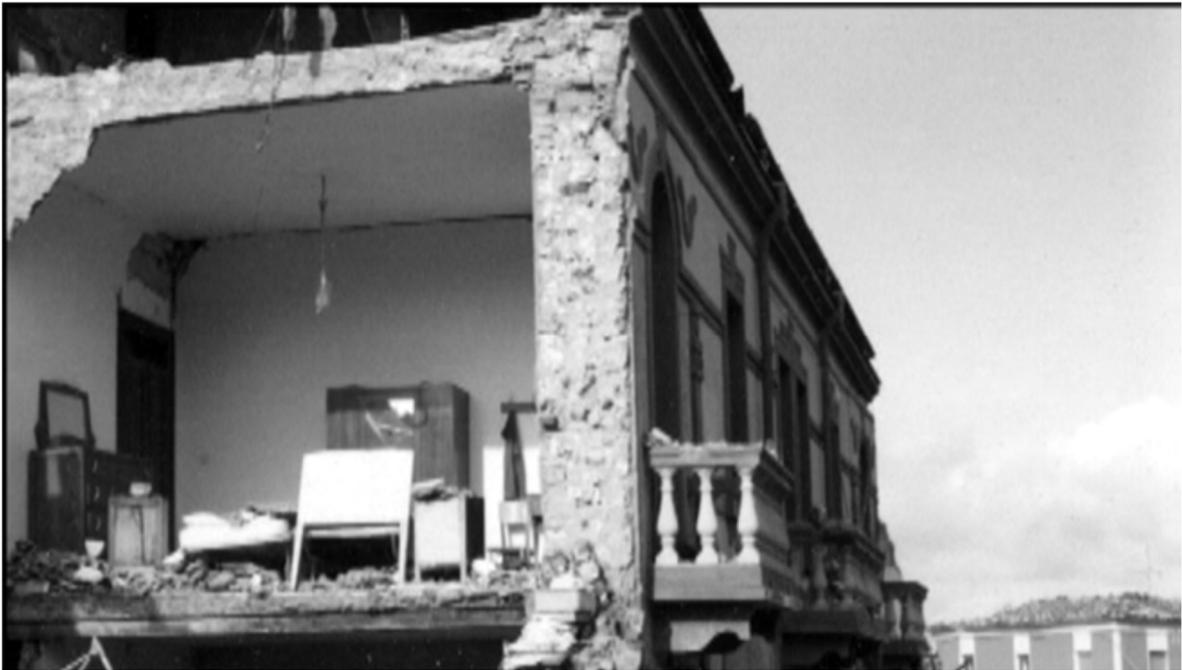
*Figura 5 Teoria, terremoto 1980, danno di primo modo per edificio con solaio costituito da putrelle ordite parallelamente alla parete crollata.*
