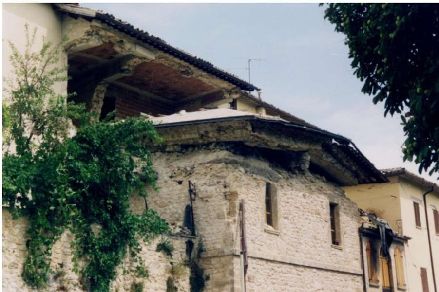
*Figura 13 Danni da sostituzione di copertura.*
