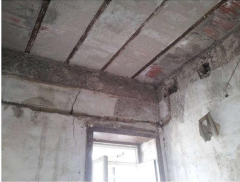
*Figura 12 Lesione nel paramento murario a seguito di intervento di rifacimento del solaio con cambiamento di orditura*
