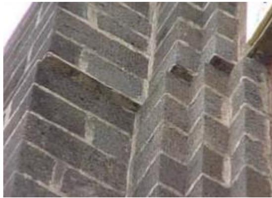
*Figura 28: rottura per taglio con scorrimento (www.reluis.it).*
