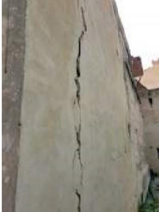
**Figure II. 8.** Exemple désordre à l'intérieur d'un mur se traduisent par un bombement partiel de ses parements (**Kamal Raftani, 2018**)
