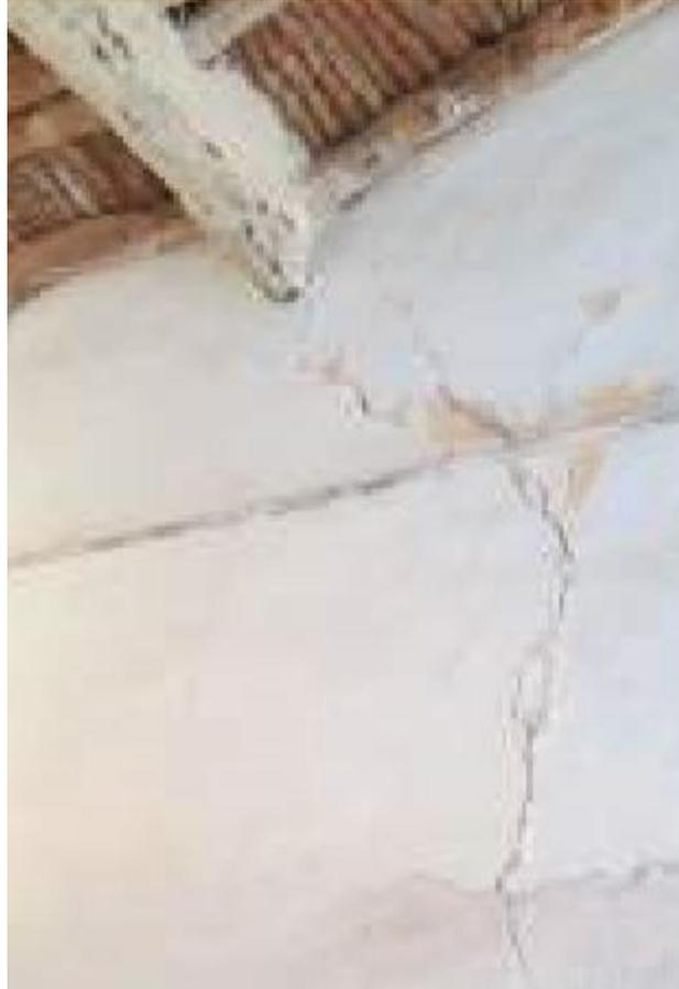
**Figure II. 5.** Exemple de désordres dus à des charges ponctuelles transmises par les poutres maîtresses aux murs d'appui (**Kamal Raftani, 2018**)
