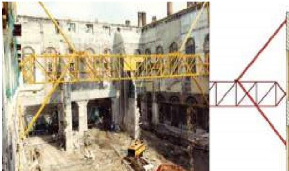
**Figure II.12.** Exemple d'un dispositif d'échafaudage utilisant des éléments métalliques préfabriqués (**Kamal Raftani, 2018**)
