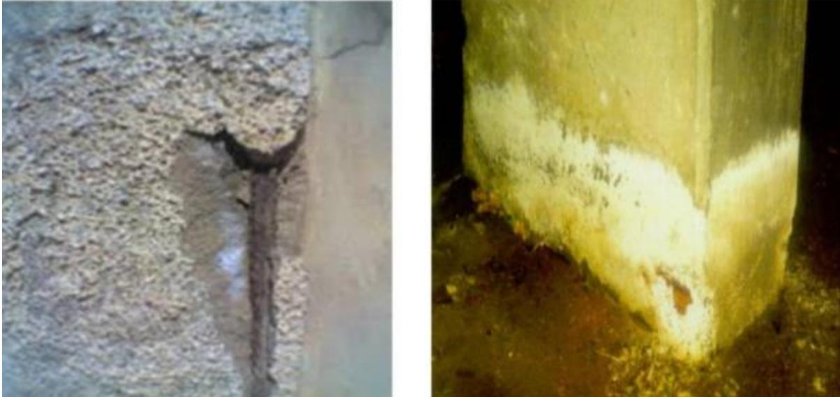
**Figure II. 2.** Attaques sulfatiques. (Houmeur Mouaadh, 2018)
