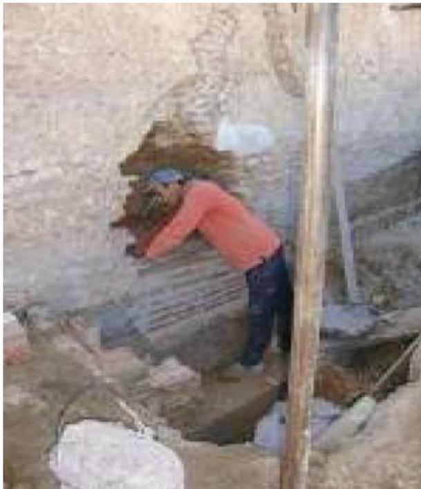
**Figure II.13.** Exemple de cicatrization de fissure sur façade d'édifice traditionnel (**Kamal Raftani, 2018**)
