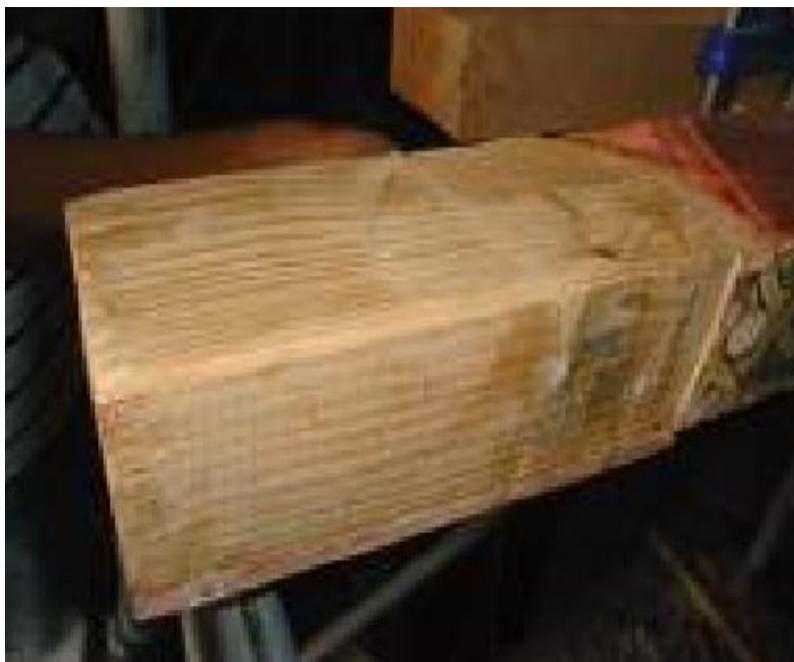
**Figure II. 19.** Remplacement du bout pourri d'une solive en bois malade avec un morceau de bois neuf (Kamal Raftani, 2018)
