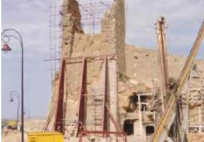
**Figure II.11.** Exemple d'un dispositif d'échafaudage utilisant des profilés métalliques (**Kamal Raftani, 2018**)
