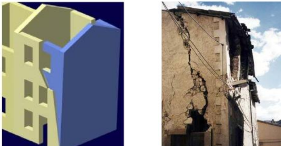
Fig. 1.4. Ribaltamento composto di parete.
