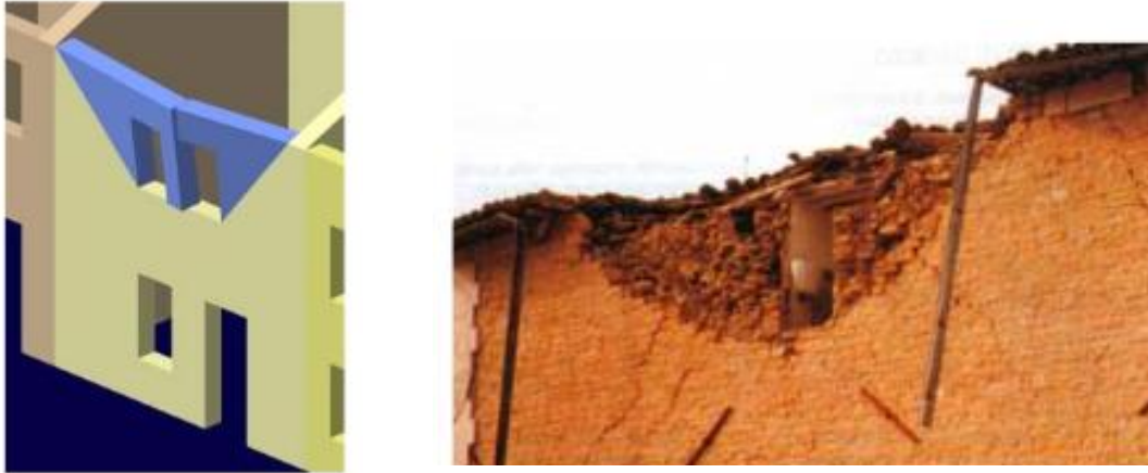
Fig. 1.4. Flessione orizzontale di parete.
