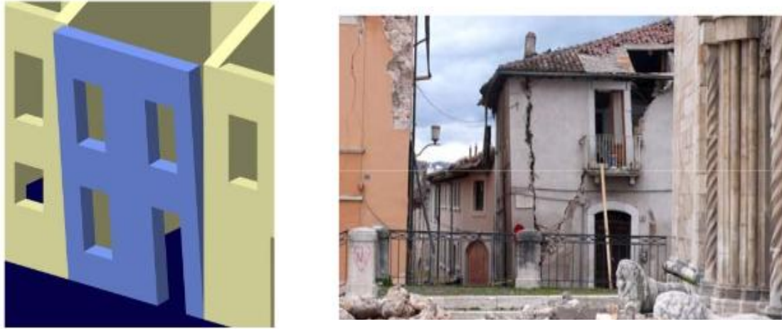
Fig. 1.2. Ribaltamento semplice di parete.
