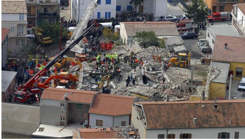
Fig. 1.9. Il tragico crollo della scuola “Francesco Jovine” in San Giuliano di Puglia dopo il terremoto del Molise nel 2002.
