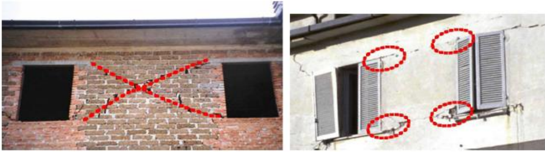
Fig. 3.1. Meccanismo di rottura per taglio e meccanismo di rottura per pressoflessione e schiacciamento negli spigoli.
