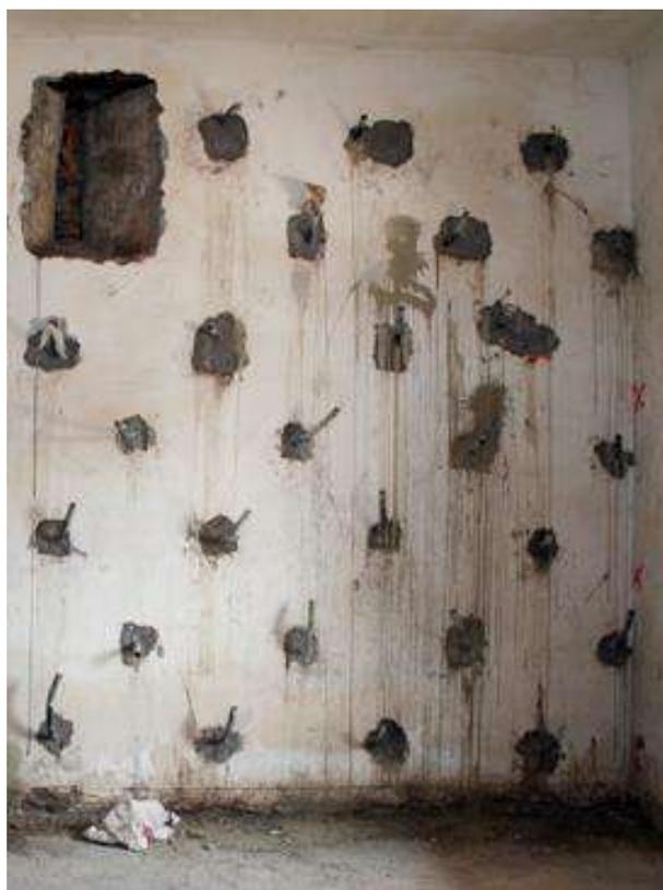
*Figura 5-1 - Esempio di intervento con iniezioni di malta*
