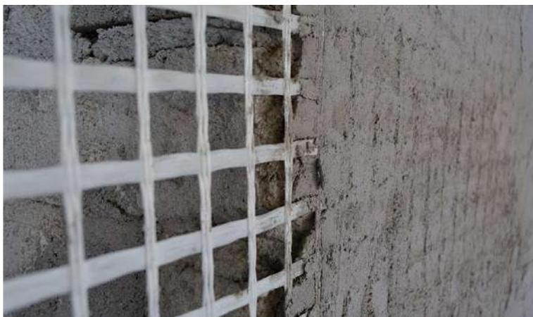
*Figura 5-2 - Esempio di intervento con intonaco armato sottile*
