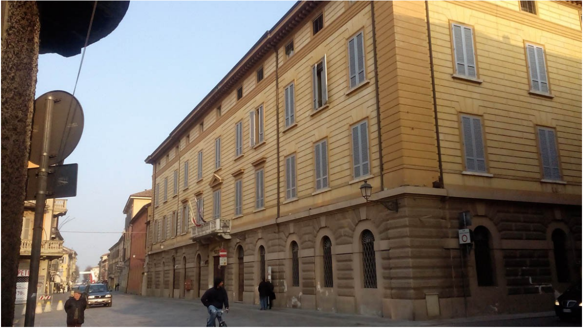
Fig. 2.2 Vista laterale della facciata su Via Emilia Santo Stefano
