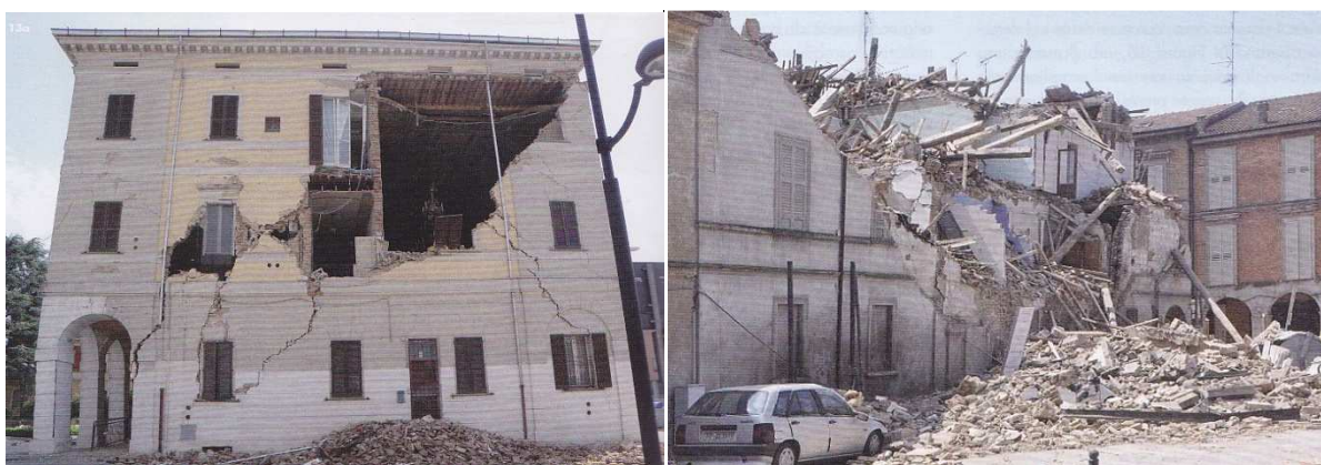
Fig.26 – Meccanismi di collasso per anomalie progettuali. Municipio di Sant’Agostino; Collasso di un edificio nel centro storico di Concordia per instabilità della parete perimetrale a doppio paramento (da Comportamento degli edifici in muratura nella sequenza sismica del 2012 in Emilia, Progettazione sismica n° 3/2012 Iuss Press Pavia).
