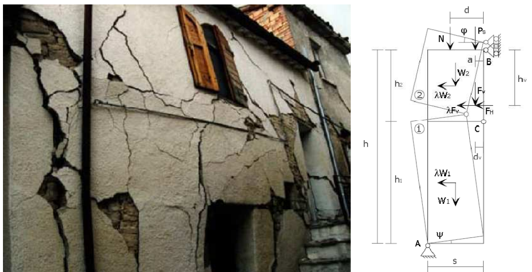
Fig. 9 – Esempio di cinematismo di flessione verticale di parete monolitica ad un piano ( meccanismo di 1°Modo fuori dal piano ). (Foto MEDEA, Zuccaro Papa 2003).
