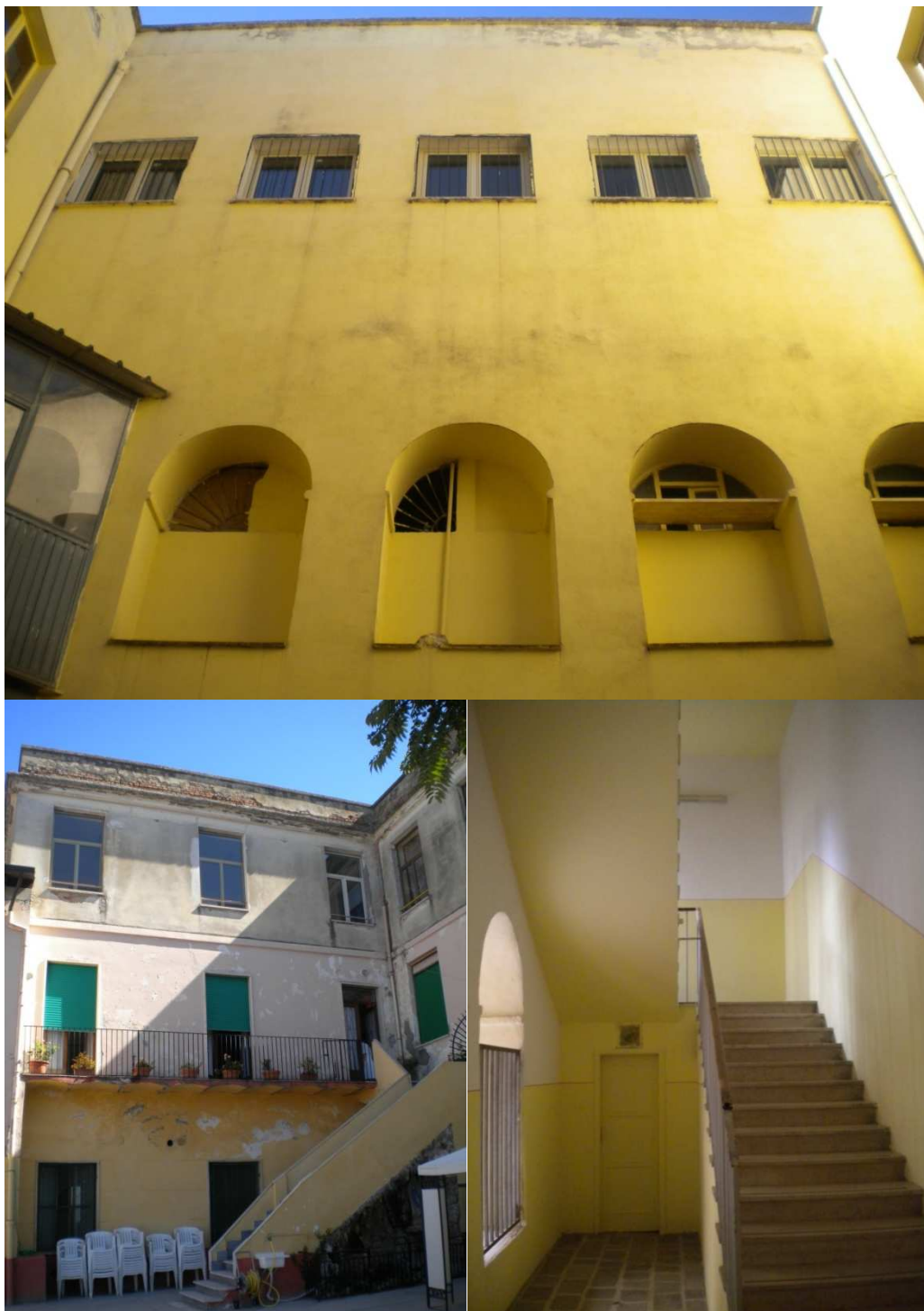
Fig. 61 - Istituto Scolastico Superiore di primo grado (Scuola Media) - Comune di Sant’Arcangelo. Facciata SO prospiciente il cortile del Convento. Vano scala interno con rampe a soletta rampante in c.a. (SCALA A – SCUOLA).
