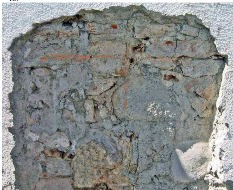
SAGGIO 1 (S1): - parete esterna perimetrale NO piano terra.
