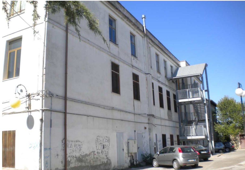
Fig. 60 - Istituto Scolastico Superiore di primo grado (Scuola Media) - Comune di Sant'Arcangelo. Prospetti NE-SE; struttura della Chiesa di San Rocco posta in adiacenza (effetti di interazione).
