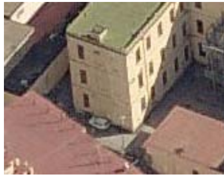
Figura 51: Vista satellitare Facciata 3 scuola G.Mazza
