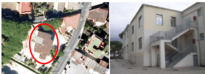
Figura 121: Scuola Chiazzolelle vista satellitare e facciata laterale.
