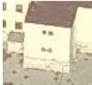
Figura 139: Vista satellitare Facciata 6 scuola Chiazzolelle
