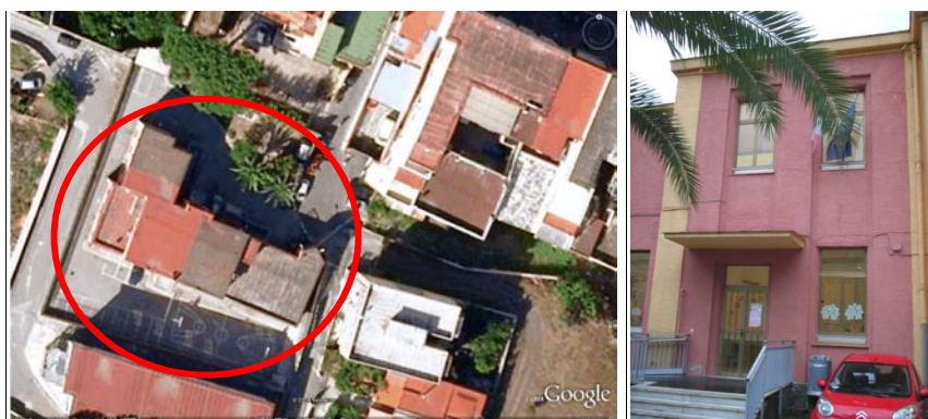
Figura 100: Scuola Leopardi-Campanariello vista satellitare e facciata principale.
