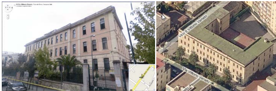
Figura 38:Foto e Vista satellitare Facciata 1 scuola G.Mazza
