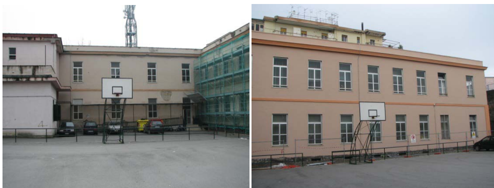
Figura 70: Particolari esterni scuola N.Sauro.
