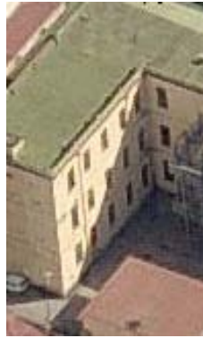
Figura 54: Vista satellitare Facciata 4 scuola G.Mazza
