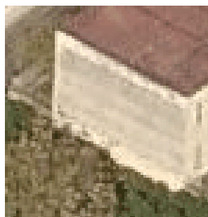
Figura 161: Vista satellitare Facciata 4 scuola G.Orsi
