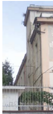
Figura 97: Vista satellitare Facciata 8 scuola N.Sauro
