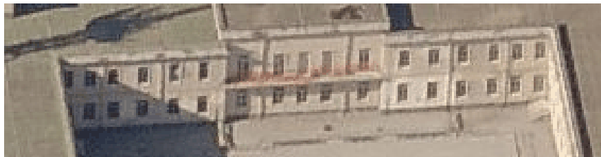
Figura 88: Vista satellitare Facciata 5 scuola N.Sauro
