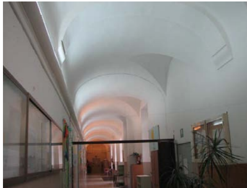
Figura 31: Particolare del corridoio con volte a crociera della scuola G.Mazza
