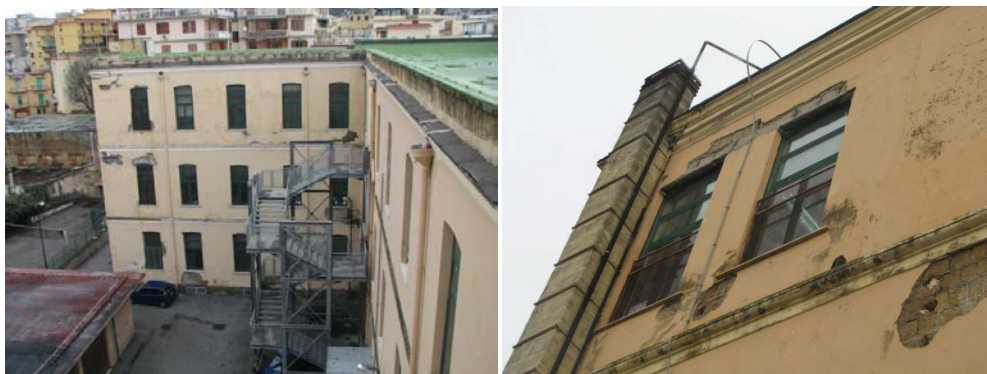
Figura 30: Particolari esterni scuola G.Mazza : canna fumaria e scala antincendio.
