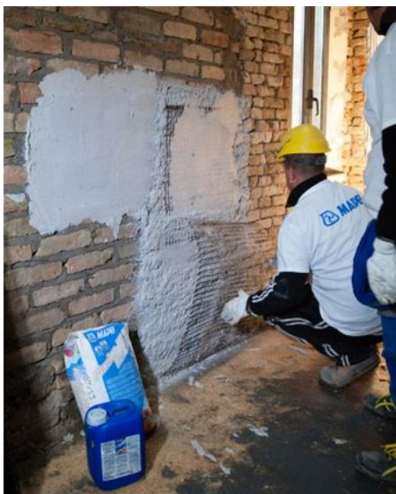
Figura 4.5 Intervento di adeguamento con fibra di vetro in località Villa Prospera.
