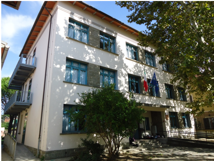
Figura 2 - Vista della facciata principale lato sud
