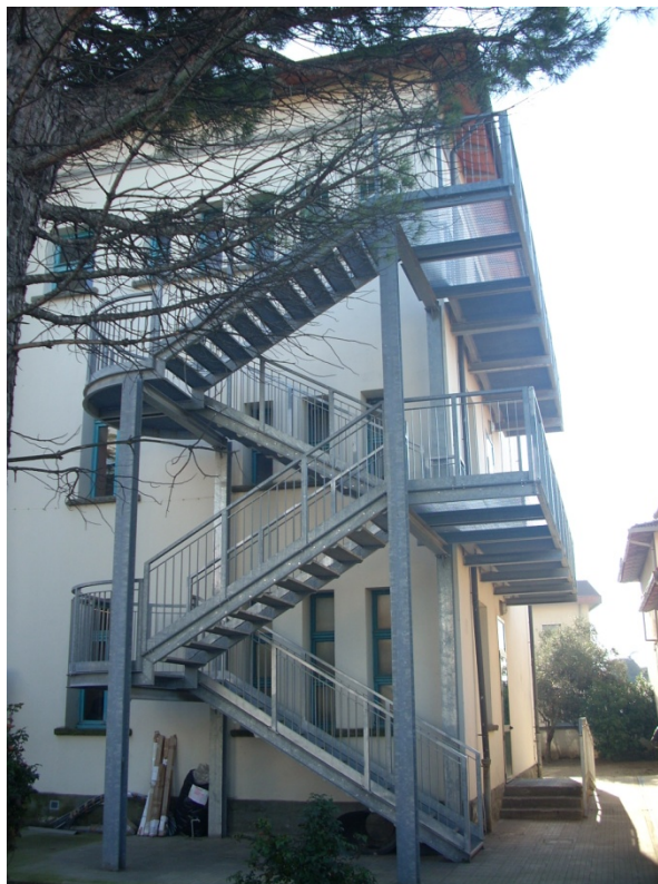
Figura 4 - Veduta della scala antincendio
