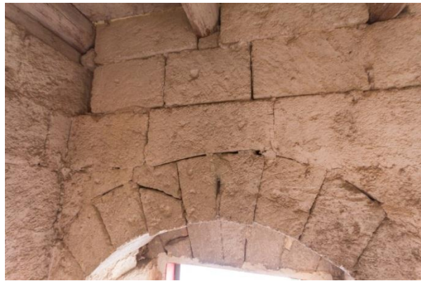
Figura 9.13 - Fessura al disopra della porta d'ingresso Figura 9.14 - Particolare della fessura dall'interno della torre.
