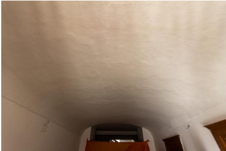
Figura 9.3 - Volta a Botte ribassata piano terra.
