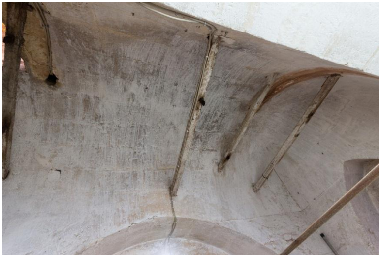
Figura 9.8 - Copertura con Volta a Stella della Torre
