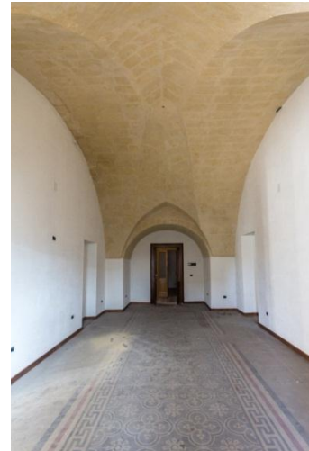
Figura 9.4 - Volta a Stella primo piano.
