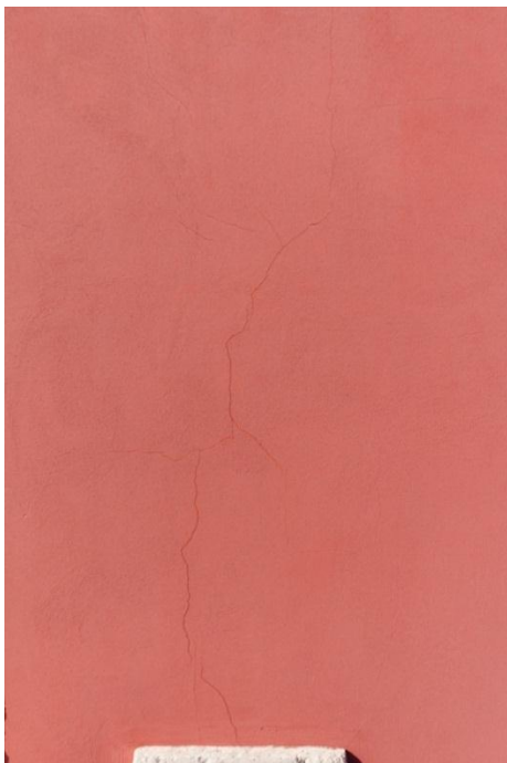
Figura 9.15 - Fessura lato est della torre.
