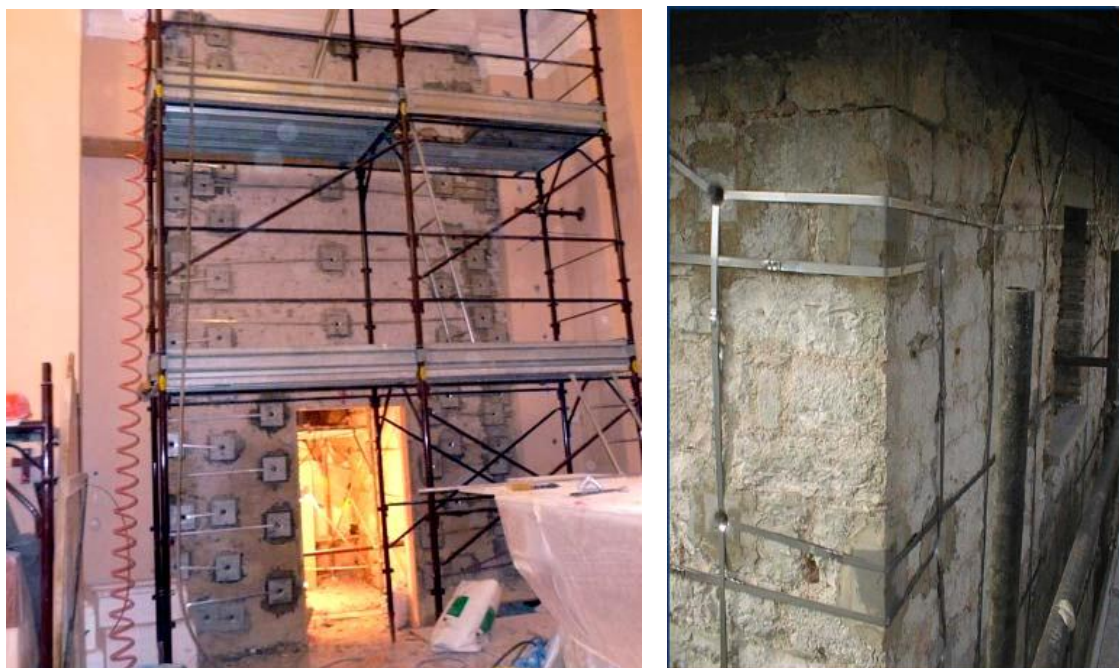
Figura 11.1 - Esempi applicativi del sistema CAM, a) S.Maria delle Grazie di Ururi, b) Civile abitazione, [17].
