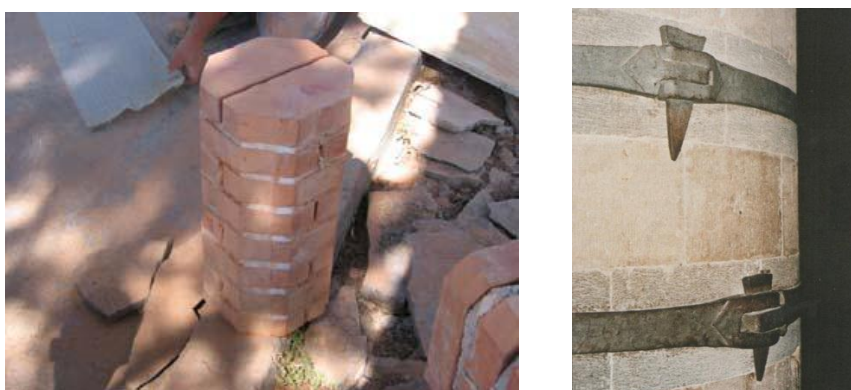
Figura 3.11 - Cerchiature in ferro forgiato di pilastri in muratura.
