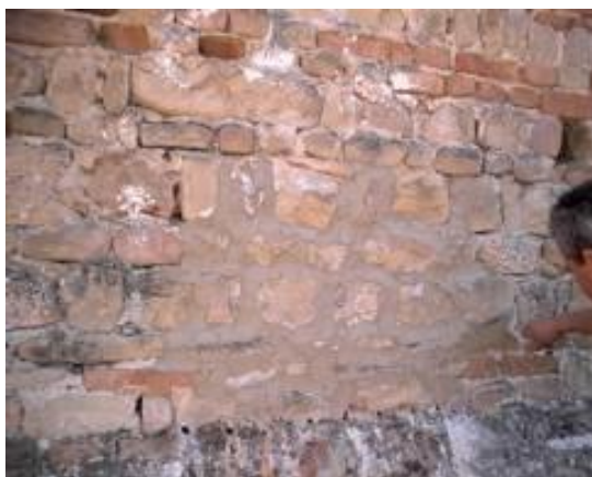
Figura 3.6 - Esempio di stilatura dei ricordi di malta ( www.umbertoalesi.it ).
