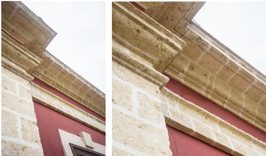
Figura 9.12 - Fessura lunga il prospetto principale
