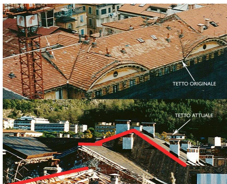
Figura 3.10 Realizzazione del nuovo tetto
