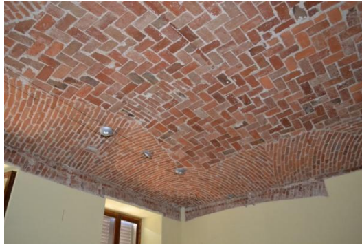
Figura 2.12 Volta rettangolare nella biblioteca adiacente alla sala Germinal
