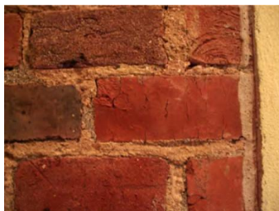
Figura 3.8 Lesioni da compressione nei pilastri al secondo piano
