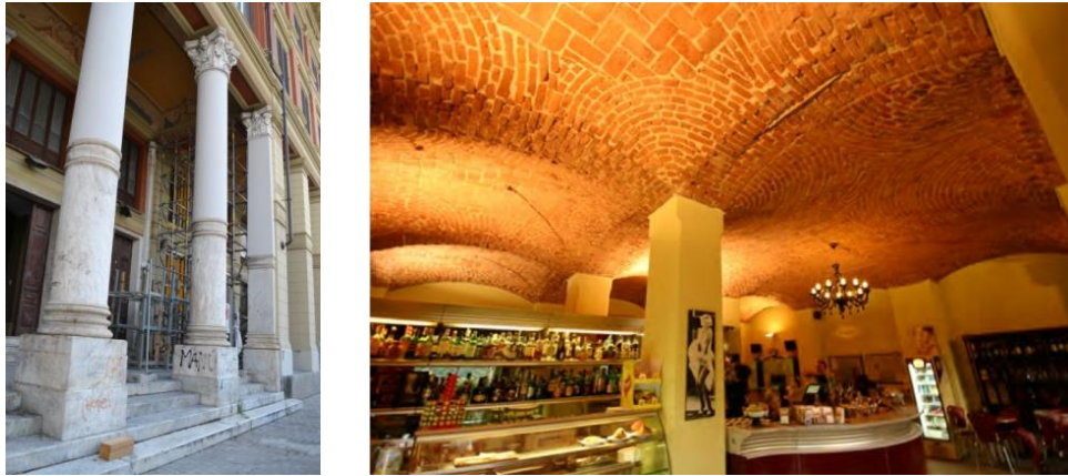
Figura 2.7 a) Pilastri del porticato b) pilastri del bar su cui insistono gli archi
