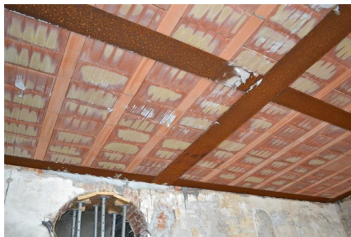
Figura 2.19 Solaio in laterocemento e travi REP
