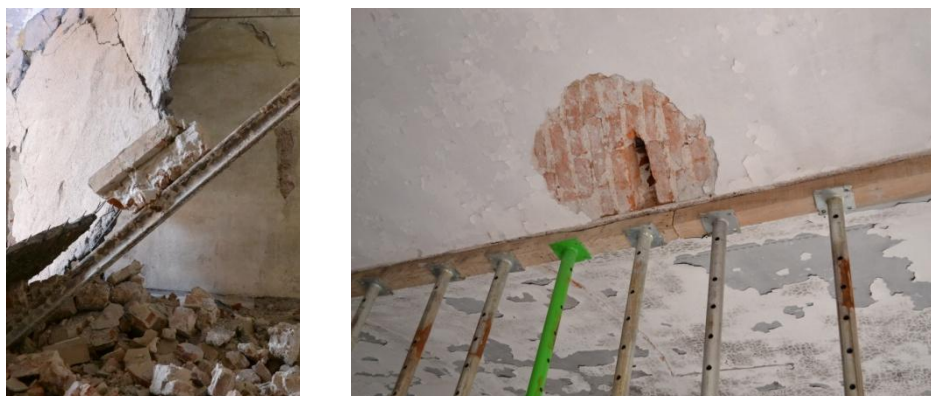
Figura 2.17 a) Attacco dei mattoni alla rotaia b) Tessitura dei mattoni
