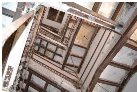
Figura 2.13 Scala di accesso all'ala sinistra
