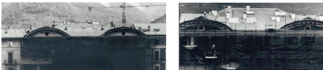
Figura 2.18 Parte centrale prima e dopo la sostituzione della copertura
