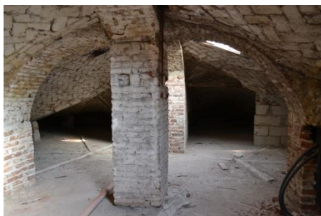
Figura 6.5 Telaio di spina formato da archi e pilastri in muratura
