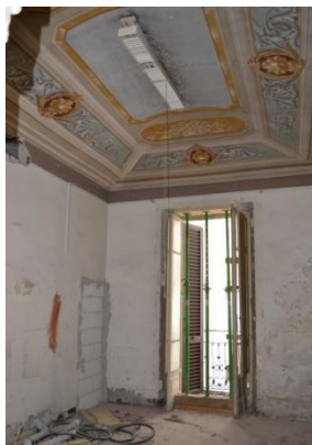
Figura 2.16 Volta a botte con teste di padiglione
