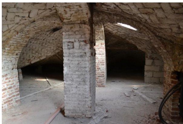
Figura 2.14 Copertura originale in laterizio
