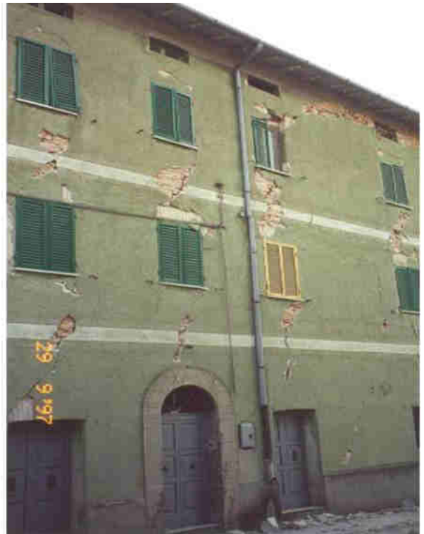
Figura n°22 – meccanismi nel piano – rottura a taglio delle fasce di piano
