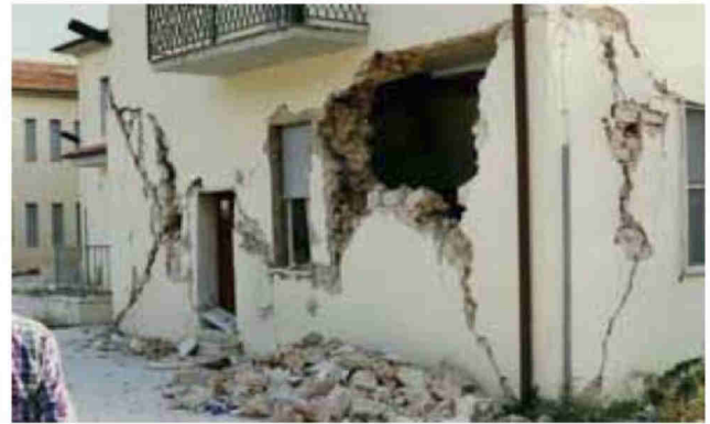
Figura n°21 – meccanismi nel piano – rottura a taglio dei maschi murari
