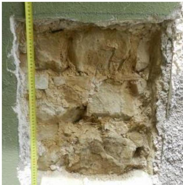
*Figura 3.24: Saggio S1 su muro perimetrale (PS)*
