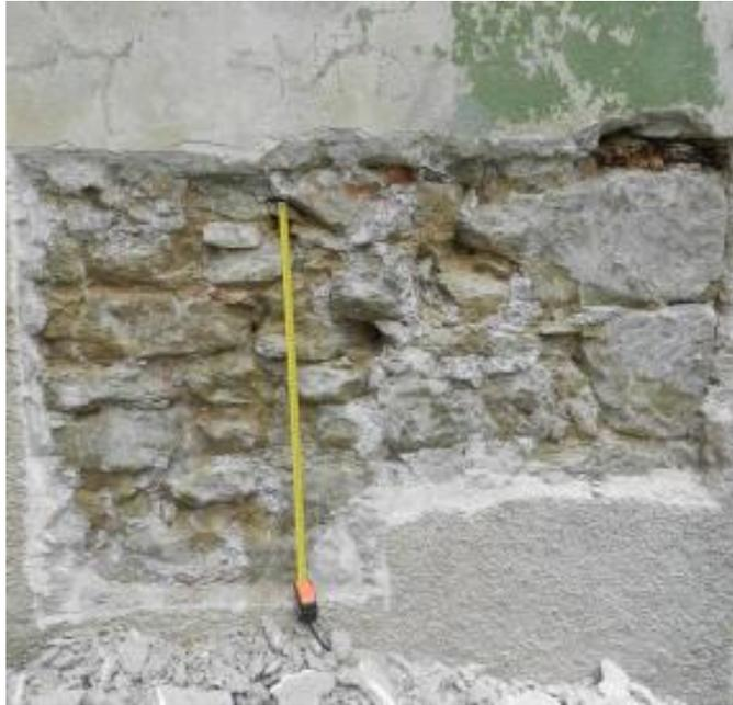
*Figura 3.23: Saggio MPD1 su muro perimetrale (PS)*
