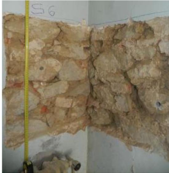
*Figura 3.29: Saggio S6 sul muro di spina (P1)*
