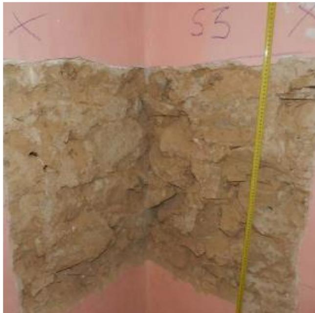
*Figura 3.26: Saggio S3 sul muro di spina (PT)*
