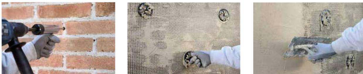
**Figura 4.23:** *Installazione delle barre elicoidali; avvitamento dei tasselli; applicazione seconda mano di malta [22]*
