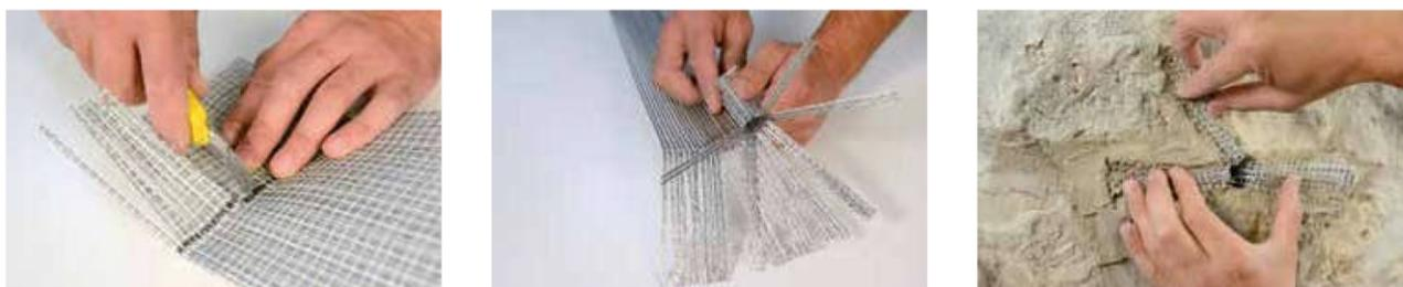
**Figura 4.7:** Sfiocchettatura del tessuto; arrotolamento per la realizzazione del diatono; installazione del connettore [22]
