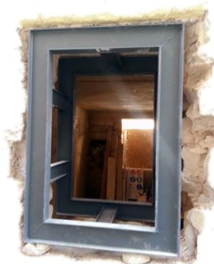
**Figura 4.38:** Esempio di cerchiatura in acciaio di un'apertura realizzata con due telai disposti sul lato esterno ed interno del paramento murario, resi solidali attraverso giunzioni saldate
