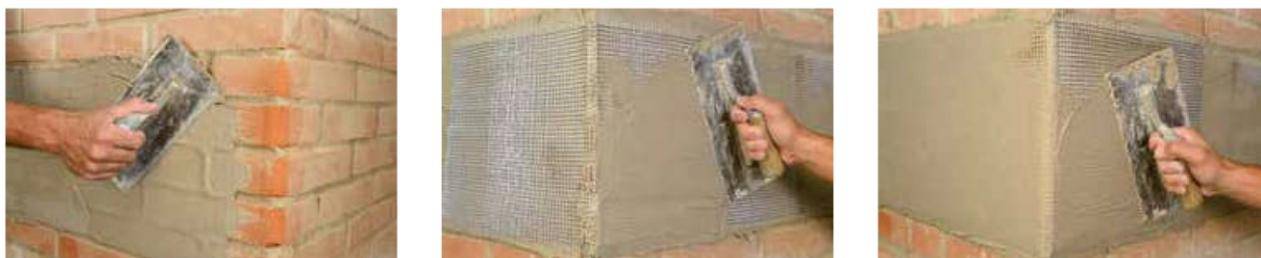
**Figura 4.6:** Applicazione prima mano di malta; installazione delle fasce di tessuto in fibra d'acciaio; applicazione seconda mano di malta [22]
