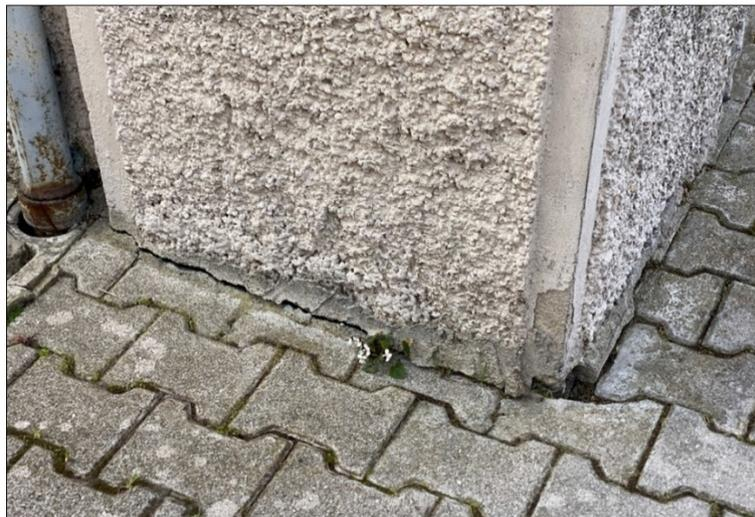
**Figura 2.12:** Cedimento terminale dello spigolo a Sud-Ovest
