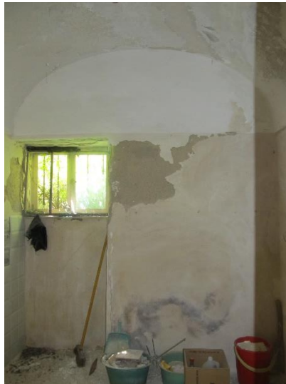
Figura 18: volta a botte presente nel primo piano dell'edificio caso studio
