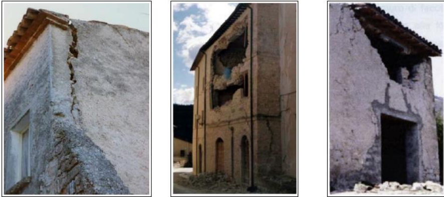
Figura 121 : varie tipologie di collasso, per meccanismo di facciata, per meccanismo di parete per flessione, e per rottura del timpano
