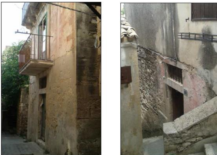
Figura 12: prospetto est su via Leni e ingresso sul prospetto Nord
