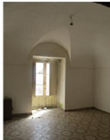
Figura 17: primo piano dell'edificio caso studio, con presenza di volta a padiglione
