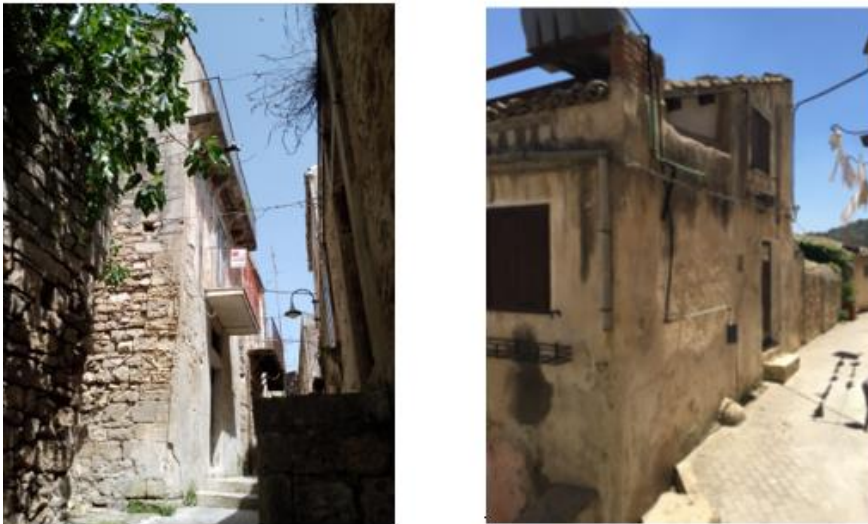
Figura 15: prospetto est dell'edificio, su via Leni ed ovest dell'edificio, su via Cartellone
