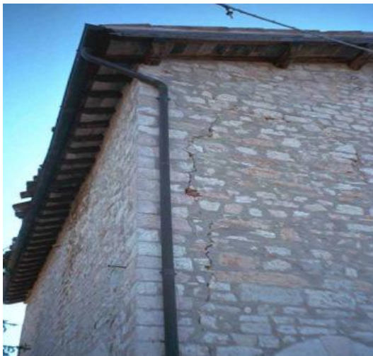
Fig. 2.4 Muratura di buona qualità; Muratura di qualità scadente
