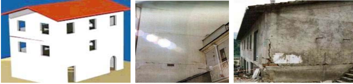
Fig. 2.17 Lesioni orizzontali lungo lo sviluppo dei solai
