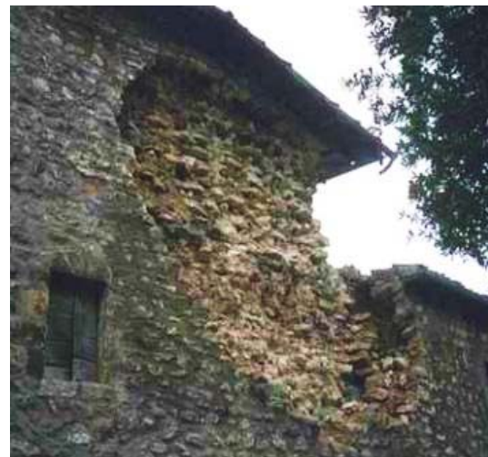
Fig. 2.4 Muratura di buona qualità; Muratura di qualità scadente
