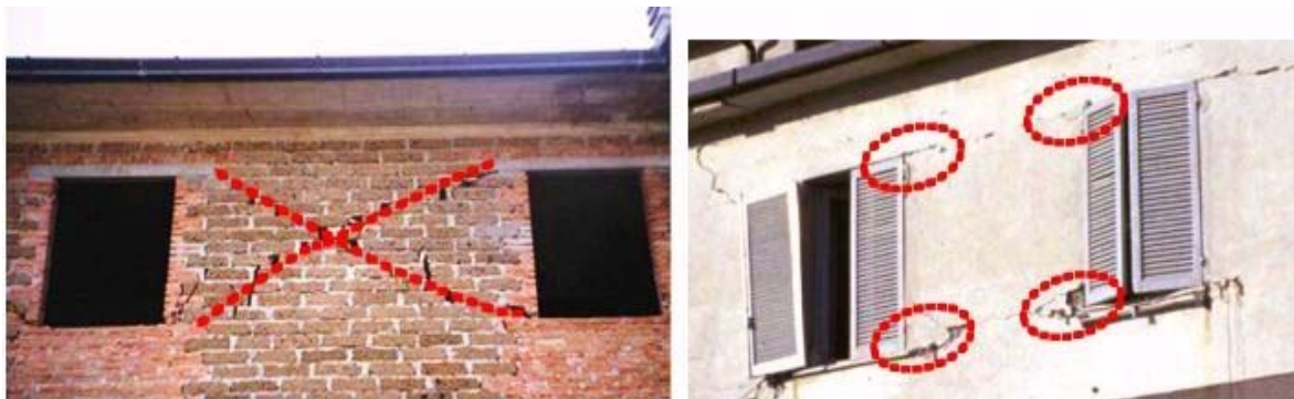
Fig. 3.3 Meccanismo di rottura per taglio e meccanismo di rottura per pressoflessione e schiacciamento negli spigoli
