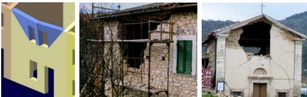
Fig. 2.10 Meccanismo di flessione orizzontale di parete
