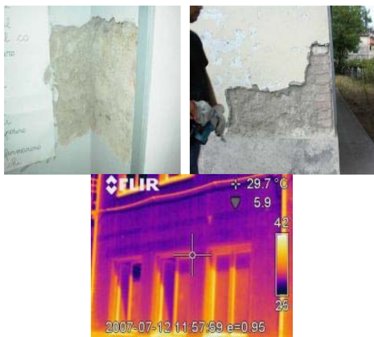
Fig. 4.7 Indagini visive e termografiche
