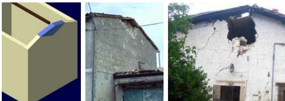
Fig. 2.11 Meccanismo di sfondamento della parete del timpano
