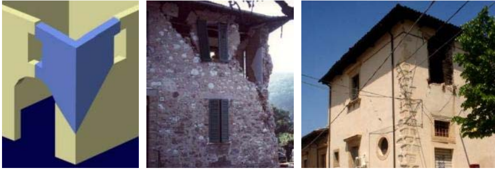
Fig. 2.8 Meccanismo di ribaltamento del cantonale
