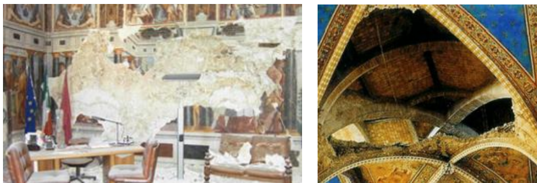
Fig. 6.9 Affreschi distrutti nel Palazzo Branconio-Farinosi e crollo delle volte affrescate nella Basilica Superiore di San Francesco ad Assisi
