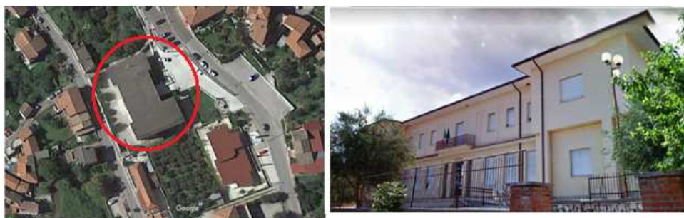
Figura 4.1 Edificio analizzato, vista dall'alto e vista frontale.
