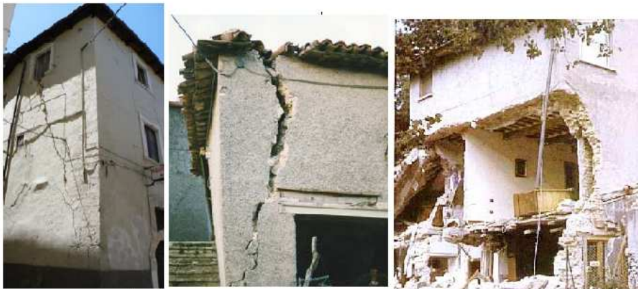
Figura 1.7 Pareti murarie interessate da meccanismo di ribaltamento composto.
