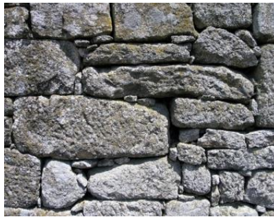
Fig. 1-2 Esempio di muratura a secco.
