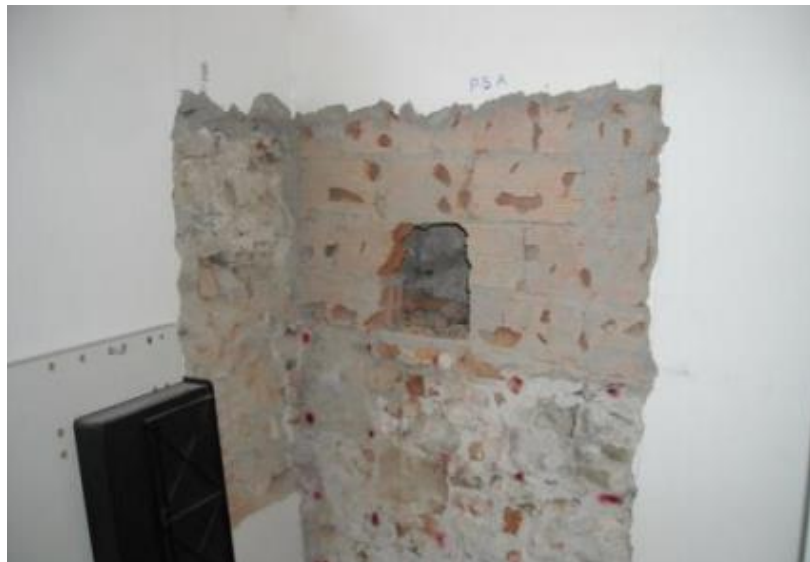
Figura 2-5. Rimozione strato di intonaco per il riconoscimento visivo
