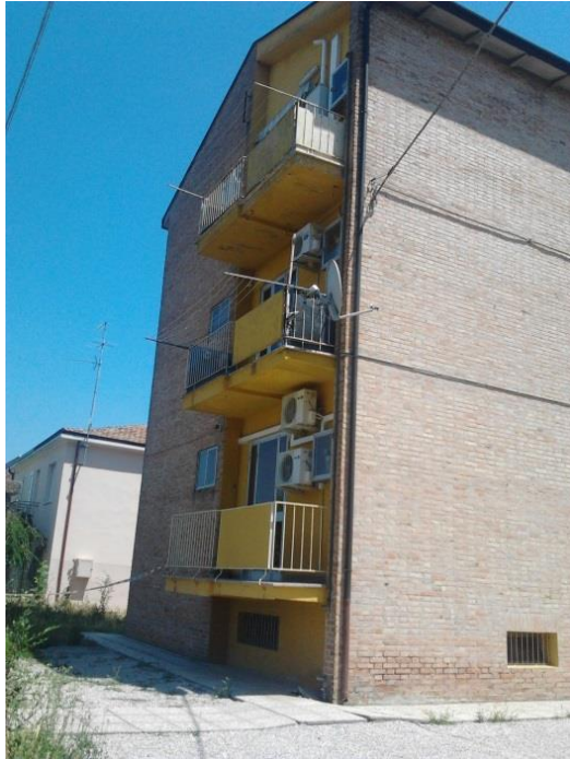
Figura 4-2. Immagine edificio lato nord-ovest
