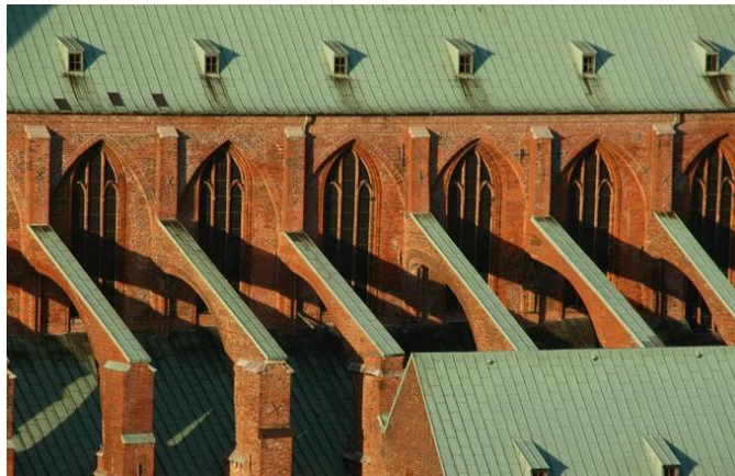
Fig. 1-13 Esempi di contrafforti della cattedrale di Lubeca.
