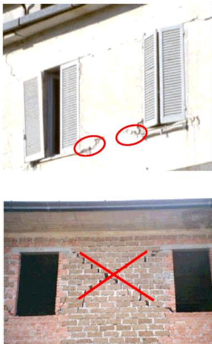
Figura 3-19. Principali danni causati da eventi sismici
