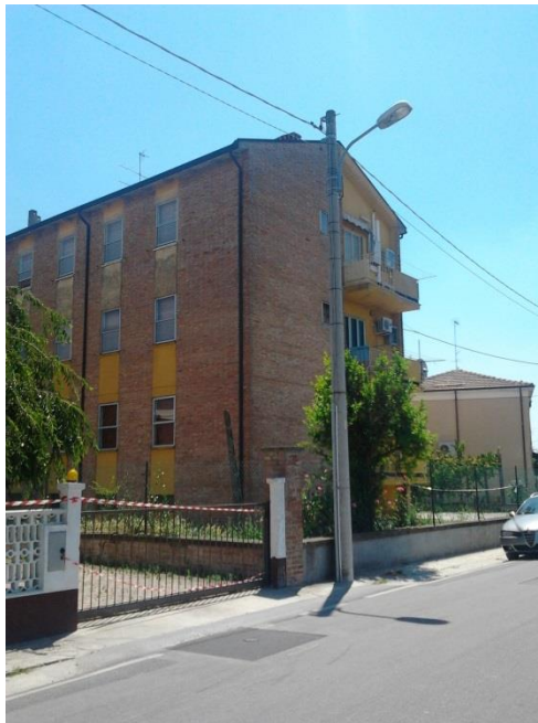
Figura 4-1. Immagine edificio lato nord
