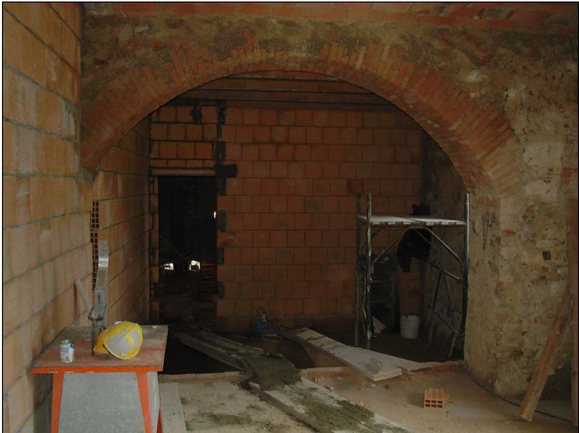
Foto A-20: Nuove tamponature al piano terra
