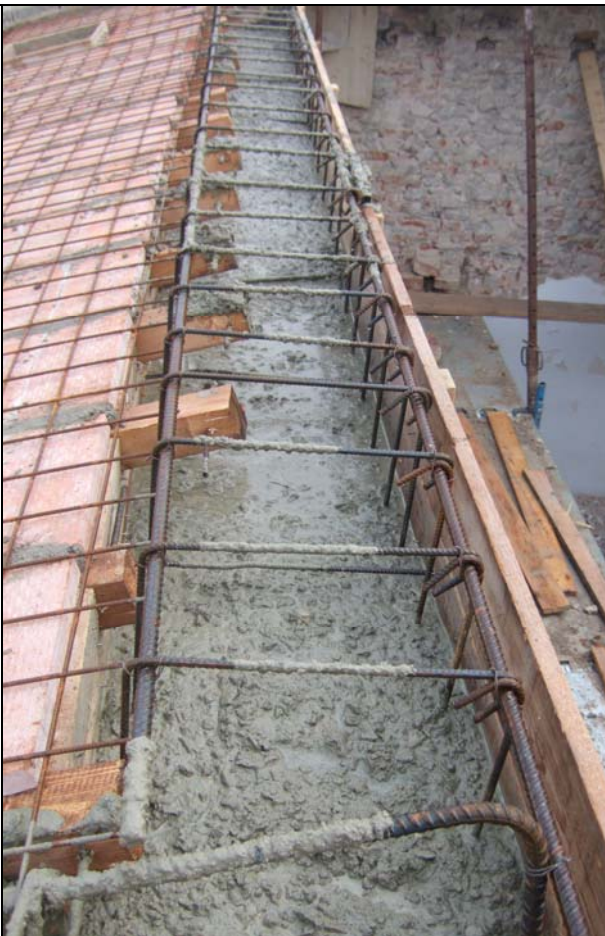
Foto A-10: Getto del cordolo di copertura e particolare ammorsamento trave
