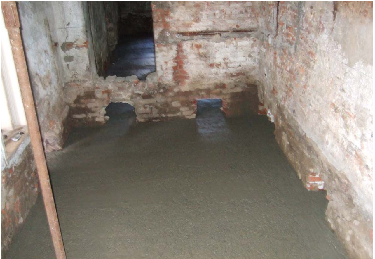
Foto A-1: Magrone solaio piano terra
