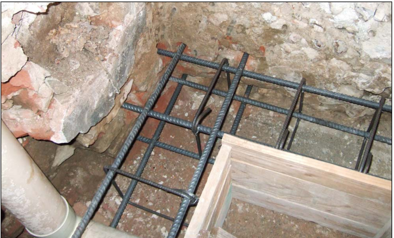
Foto A-2: Armatura cordoli di fondazione
