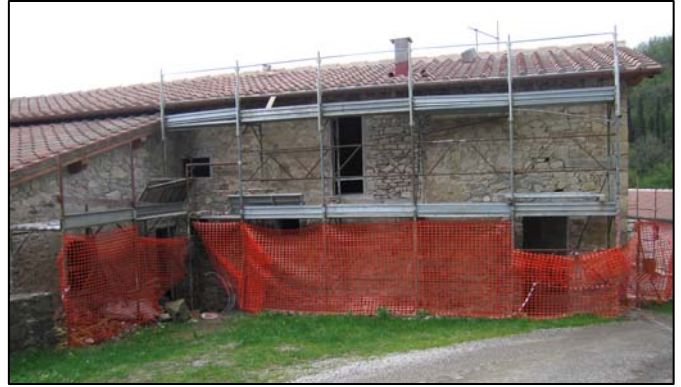
Foto A-16: Lato nord durante la fase di cantiere
