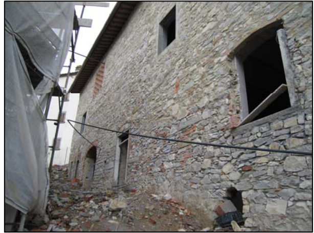
Foto 17: Lato sud durante la fase di cantiere
