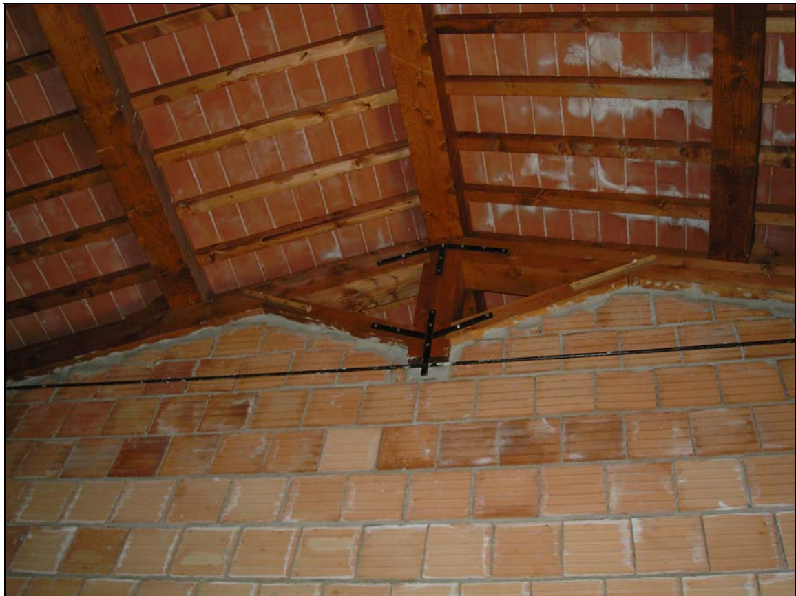
Foto A-18: Nuova copertura
