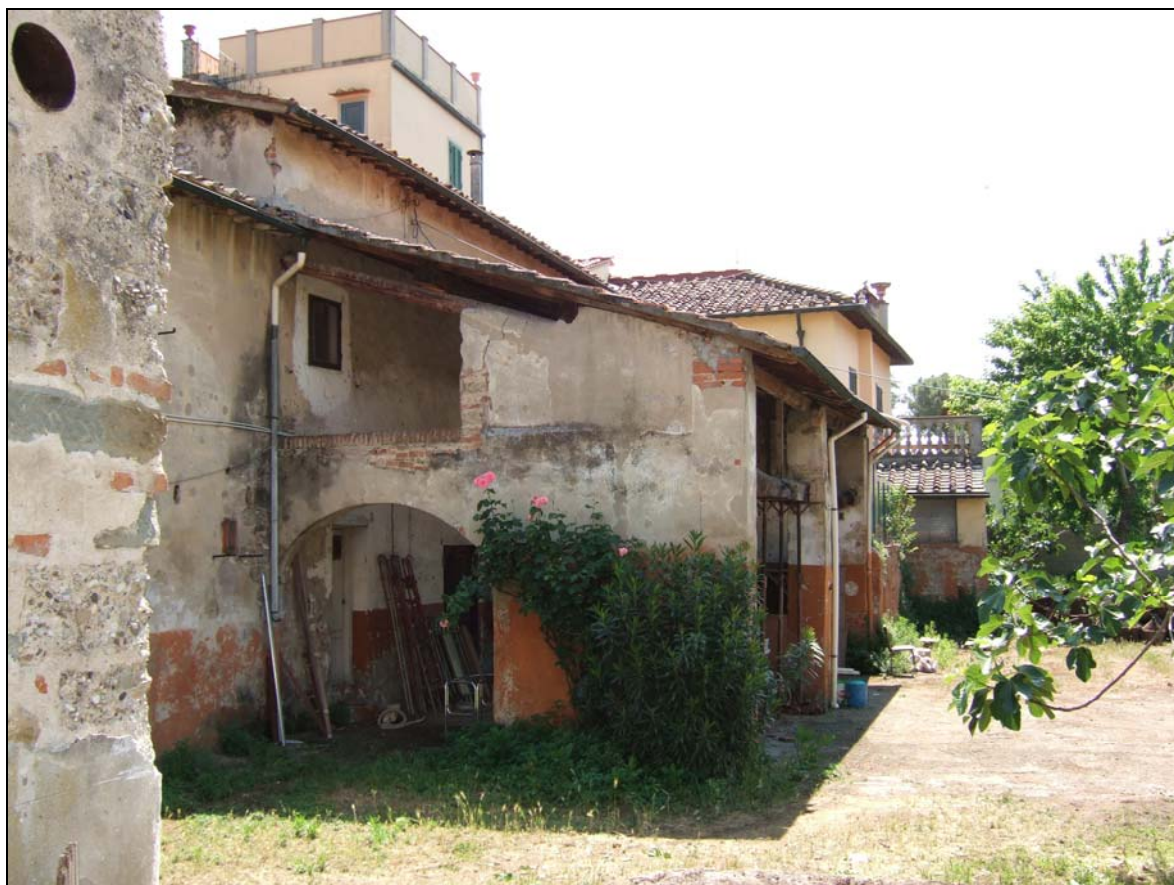
Foto I-3: Loggiato lato Nord-Ovest
