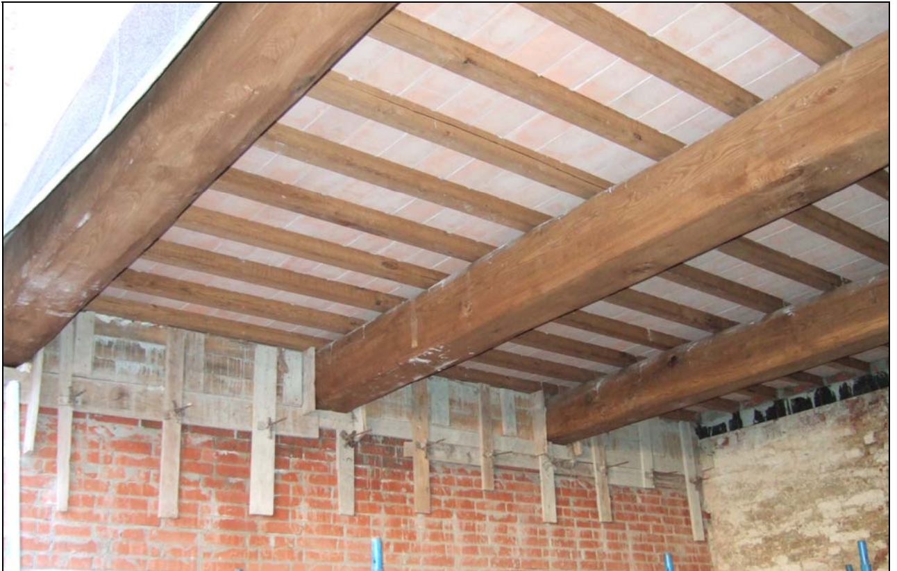
Foto A-7: Nuovo solaio
