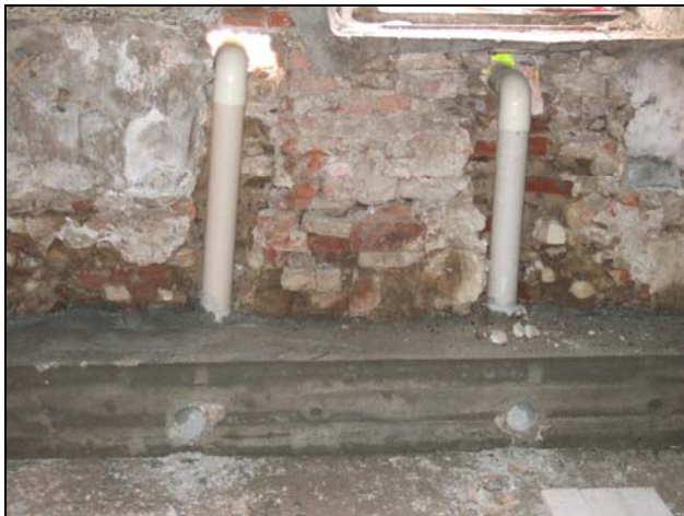
Foto A-3: Cordolo di fondazione e bocche di areazione del solaio ventilato
