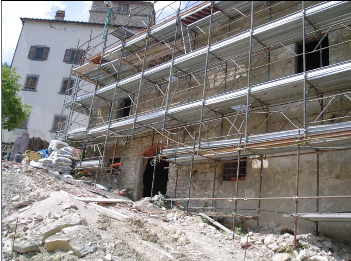
Foto A-14: Lato sud durante la fase di cantiere
