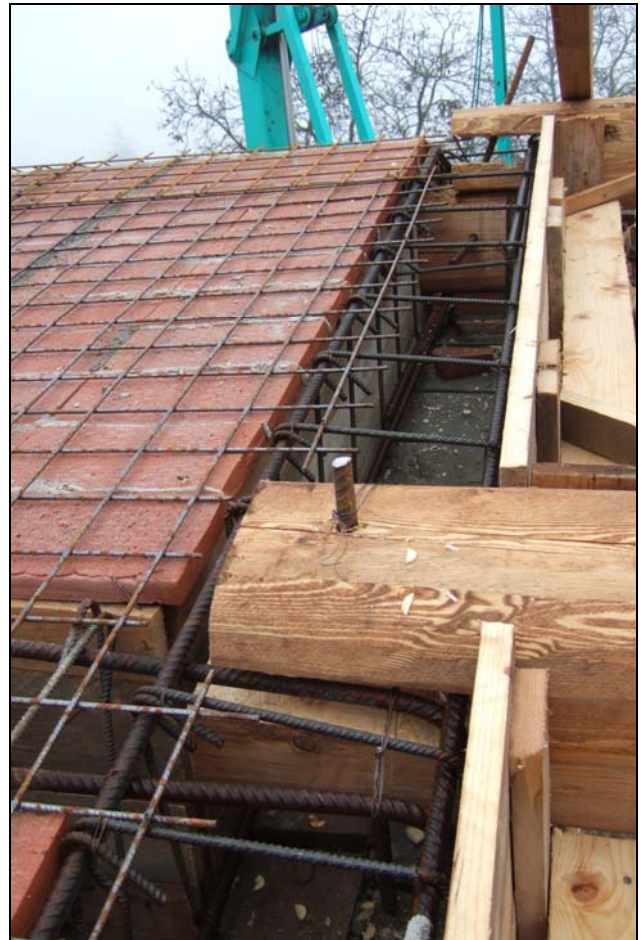
Foto A-10: Getto del cordolo di copertura e particolare ammorsamento trave
