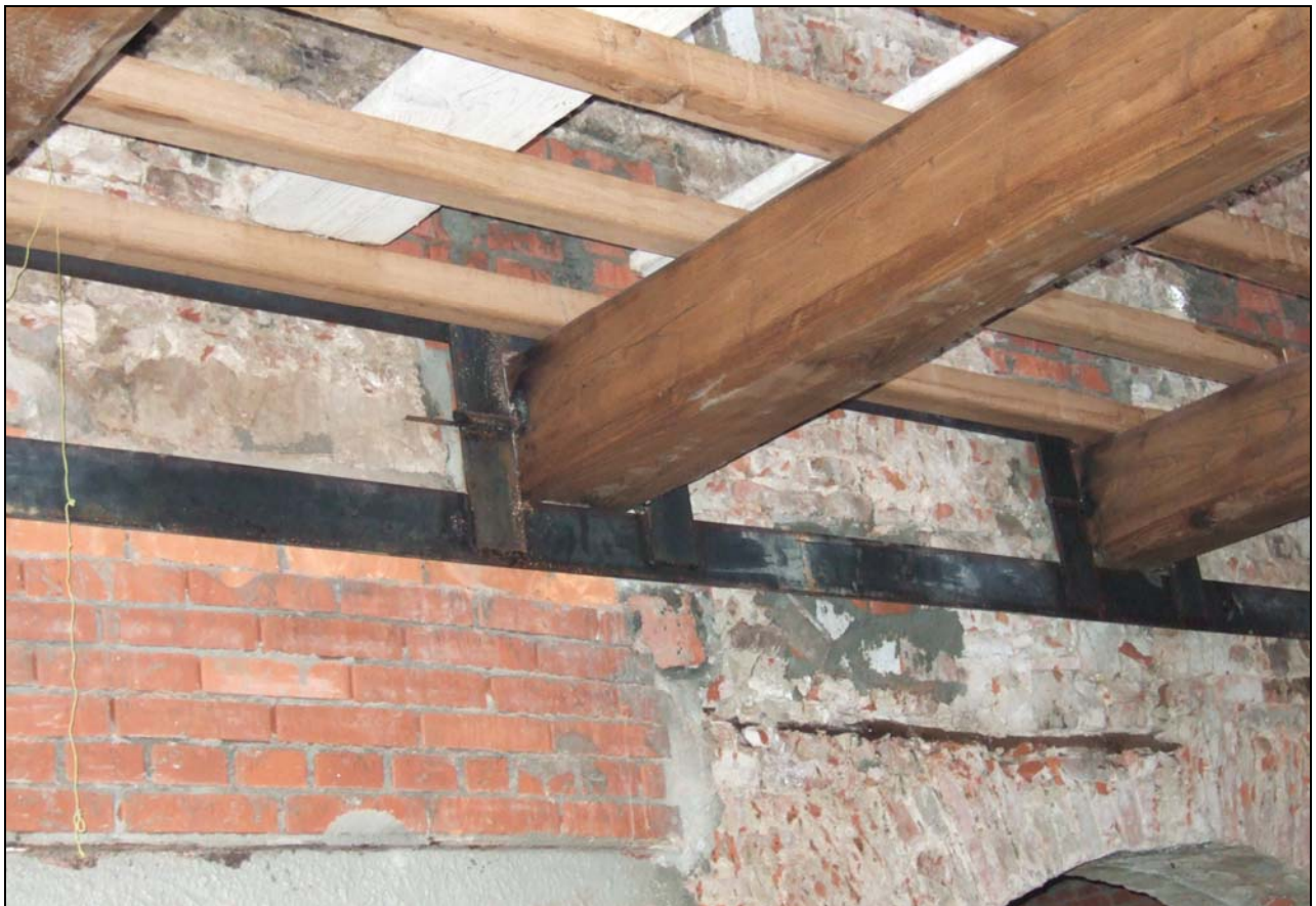
Foto A-6: Particolare ammorsamento trave in legno
