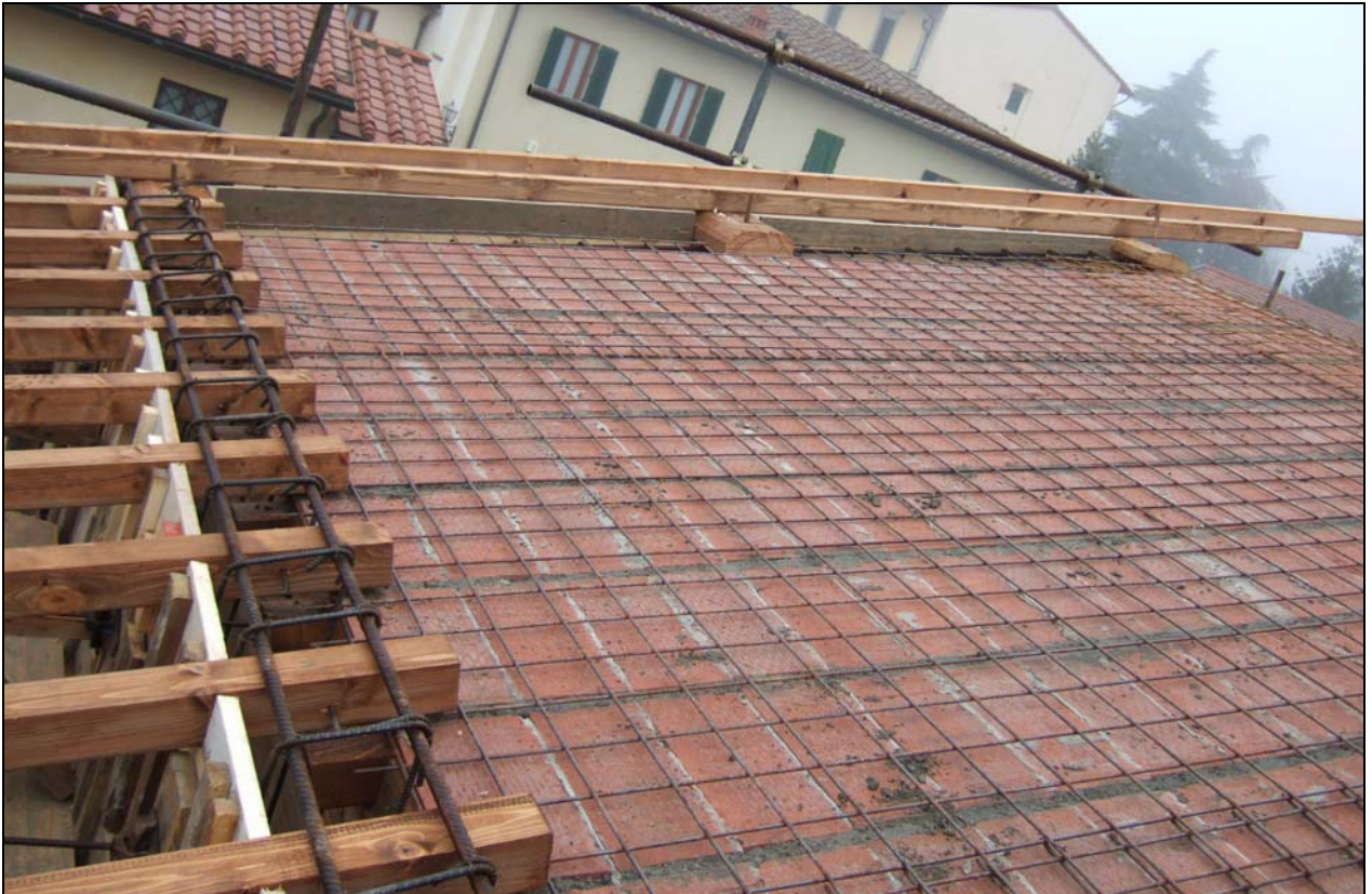
Foto A-9: Armatura della soletta di copertura
