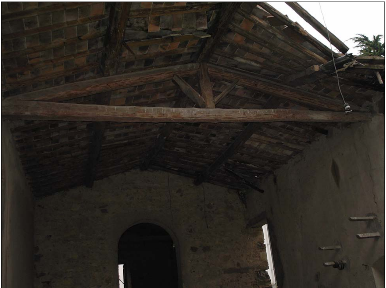
Foto A-12: Copertura originaria
