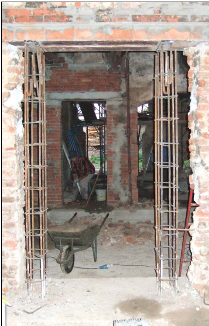
Foto A-4: Cerchiatura e particolare attacco architrave
