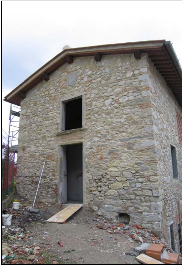
Foto A-15: Lato ovest durante la fase di cantiere
