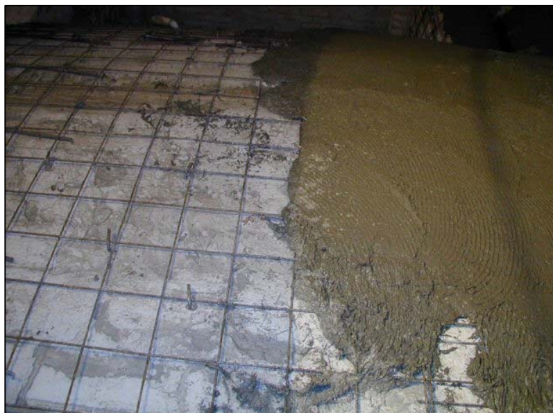
Foto V-1: Esempio di applicazione del betoncino armato
