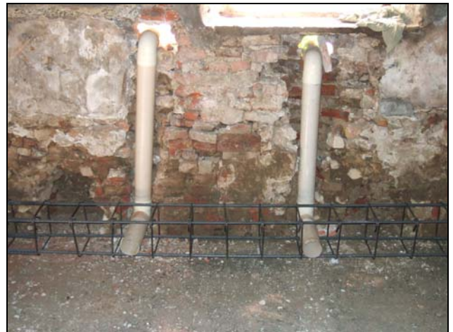
Foto A-3: Cordolo di fondazione e bocche di areazione del solaio ventilato
