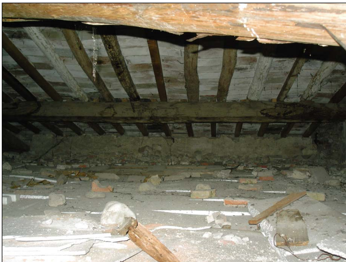
Foto I-6: Solaio di copertura
