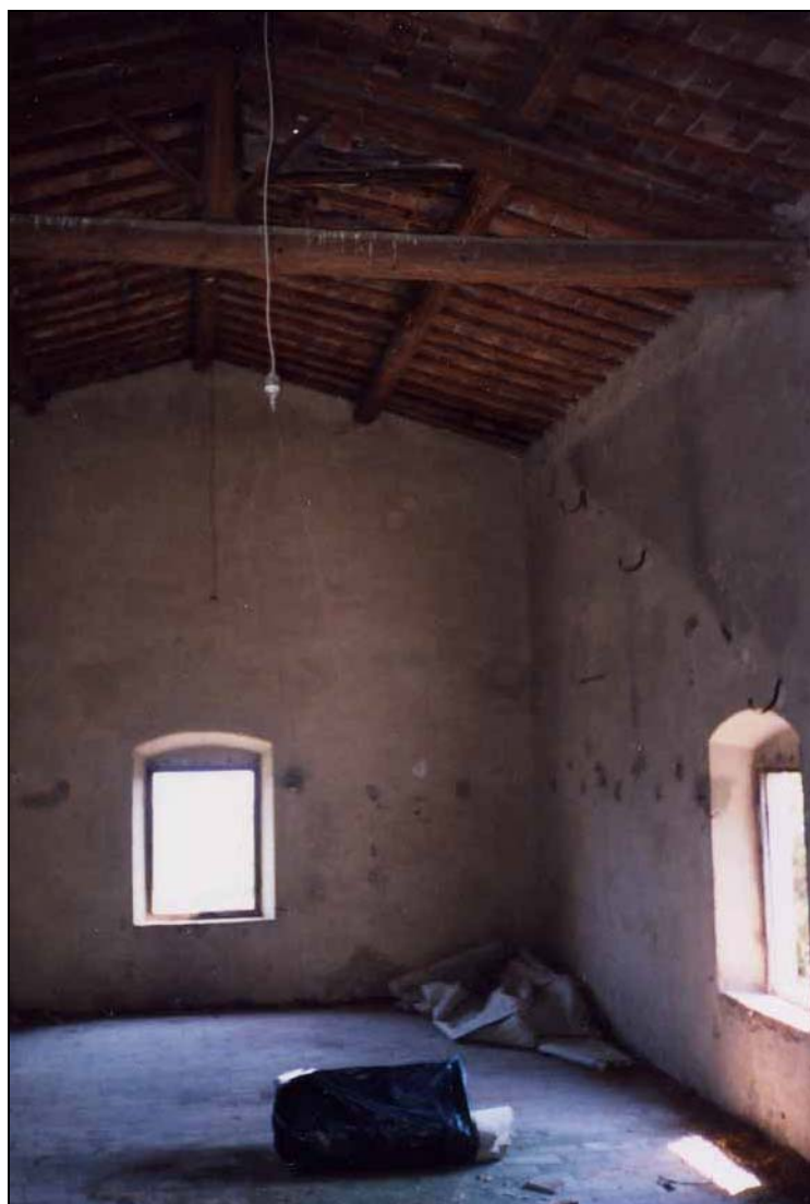
Foto I-13: Copertura in legno
