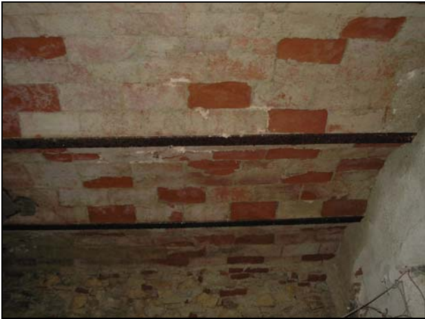
Foto A-11: Solaio in voltine originario
