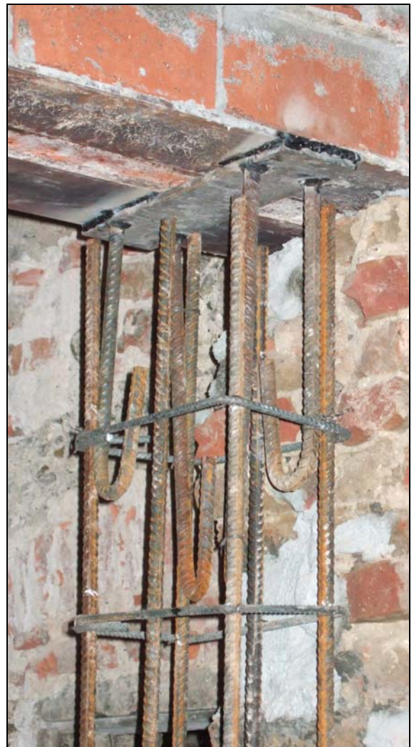
Foto A-4: Cerchiatura e particolare attacco architrave
