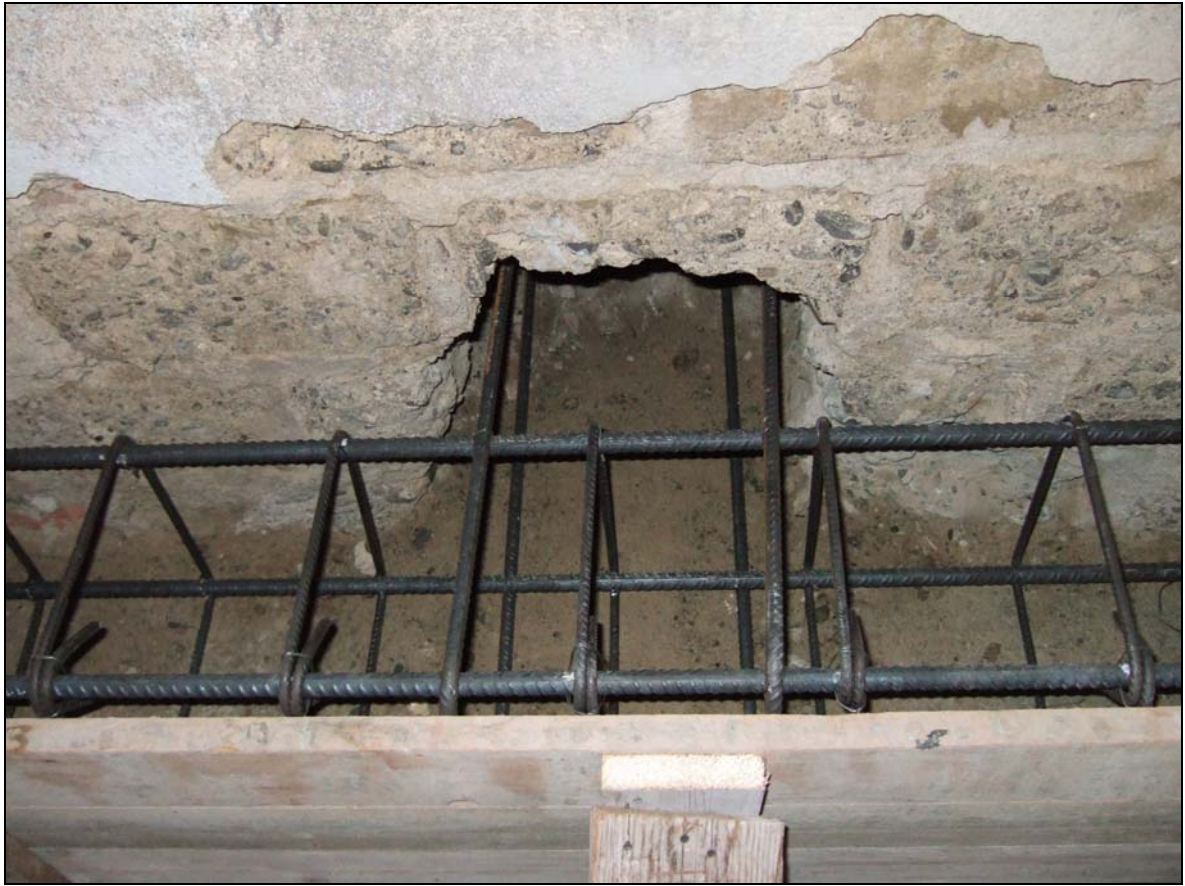
Foto A-13: Armatura cordoli di fondazione
