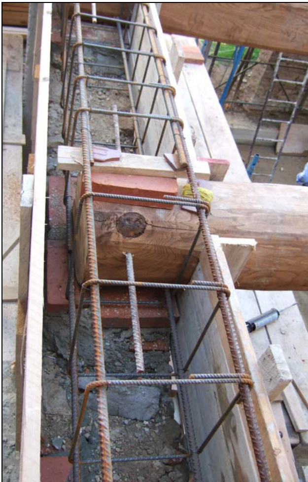
Foto A-8: Armatura dei cordoli della copertura
