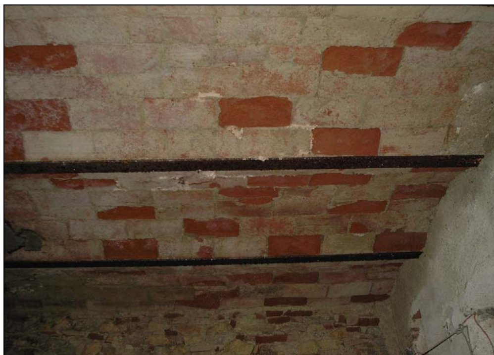
Foto I-14: Solai in voltine
