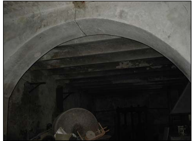
Foto A-11: Solaio in voltine originario
