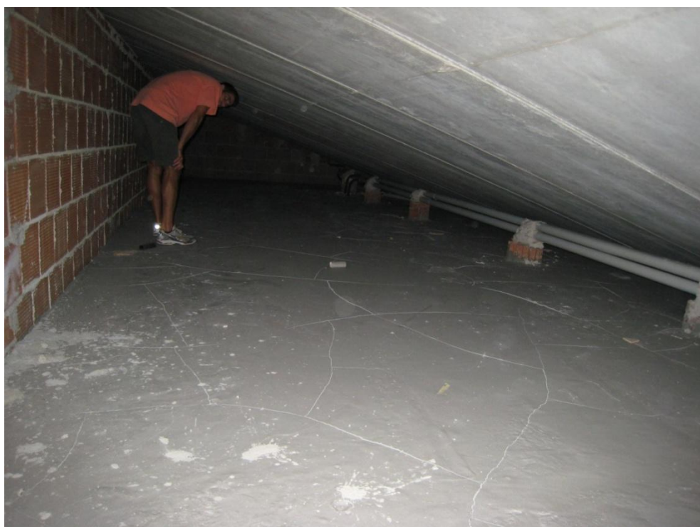
Figura 109 – foto interna sottotetto
