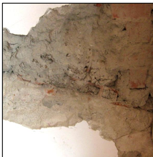
Figura 75 – dettaglio nuova muratura
