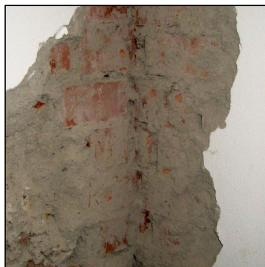
Figura 76 – dettaglio ammorsamento
