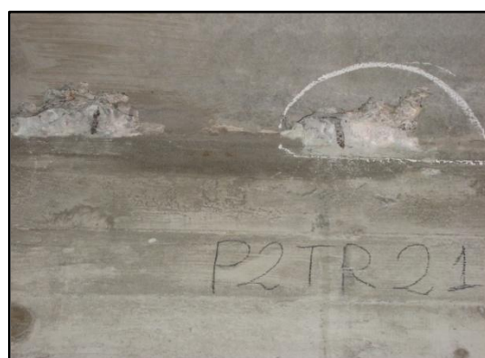
Figura 122 – P2-TR21 – collegamento predal
