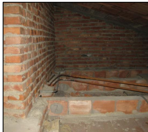
Figura 88 – solaio P1 parte vecchia
