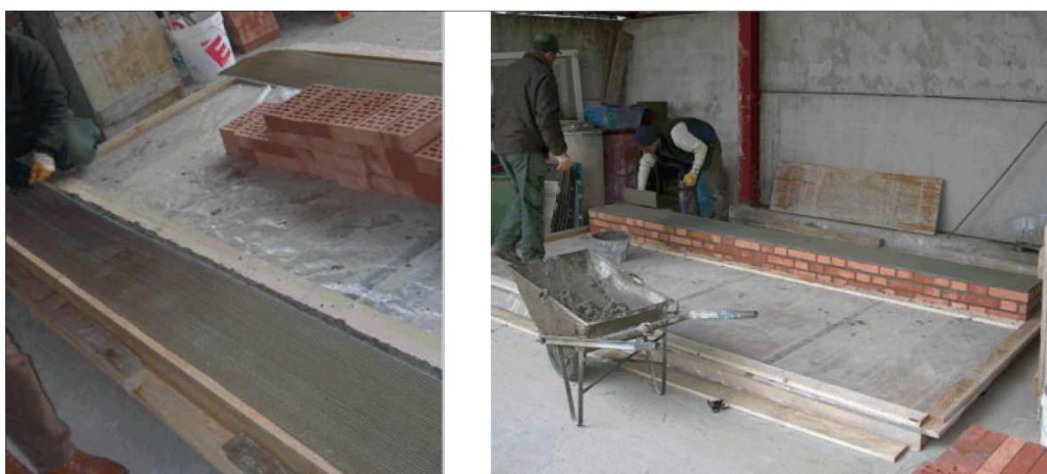
Figura 5.8: A sinistra la posa in opera del nostro SRG, a destra la trave cordolo ultimata (fonte www.Mastrodicasa.com )
