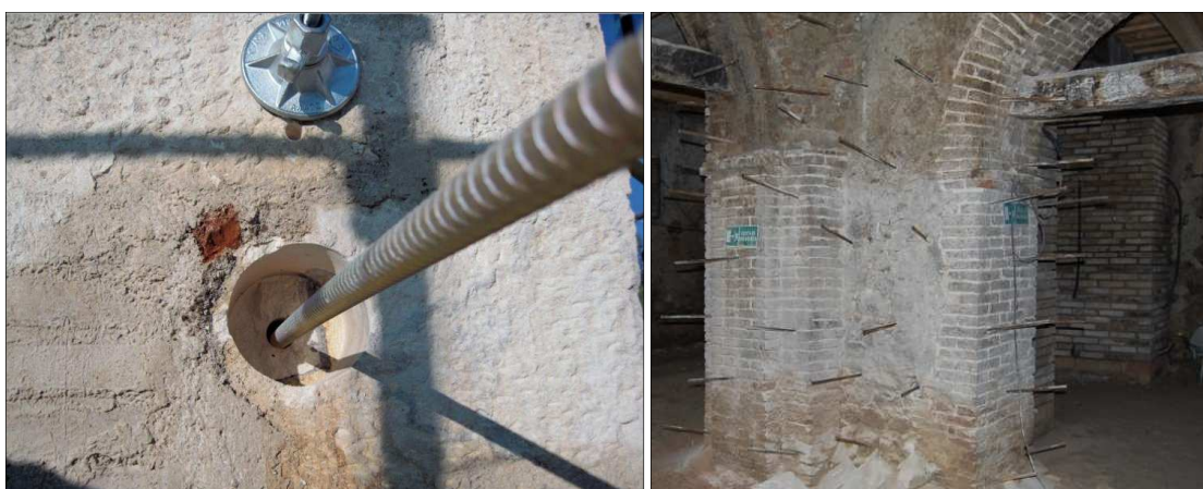
Figura 5.5: Esecuzione di perforazioni armate in paramenti murari
