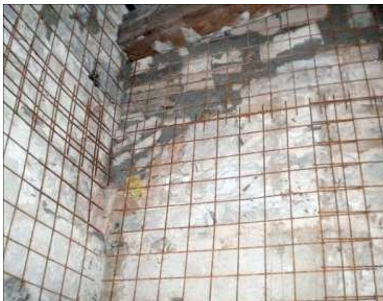
Figura 5.23: Placcaggio muratura con intonaco armato
