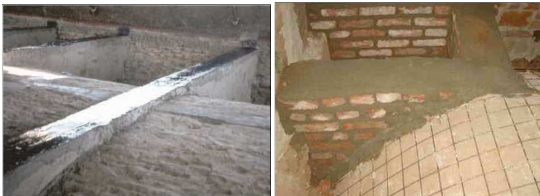
Figura 5.14: Alleggerimento volta con l'ausilio di frenelli
