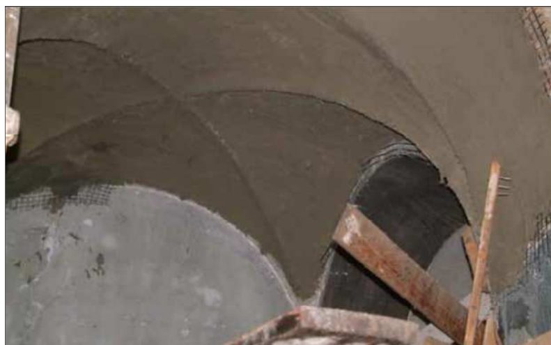
Figura 5.13: Placcaggio volta a crociera a intradosso
