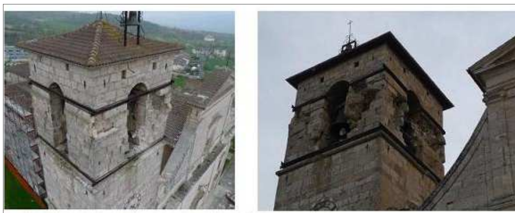
Figura 5.3: Esempio di cerchiatura con elementi metallici (Abruzzo 2009)
