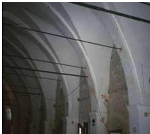
Figura 5.10: Catene per la riduzione delle spinte di archi e volte
