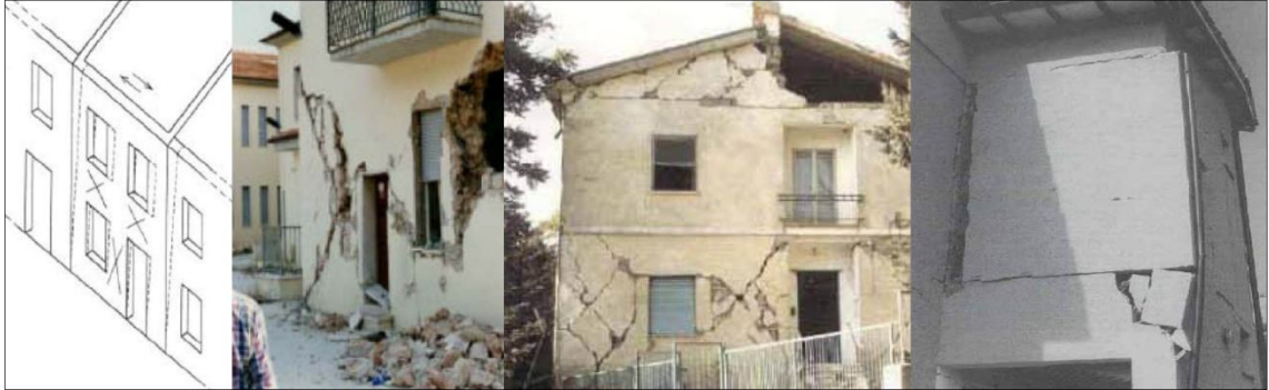
Figura 4.7: Casi reali di meccanismi di secondo modo.
