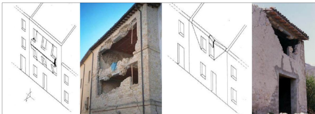
Figura 4.6: Casi reali di rottura per flessione ad arco verticale ed orizzontale.
