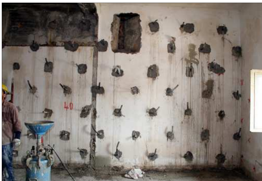
Figura 5.18: Rinforzo muratura attraverso iniezione di miscele leganti
