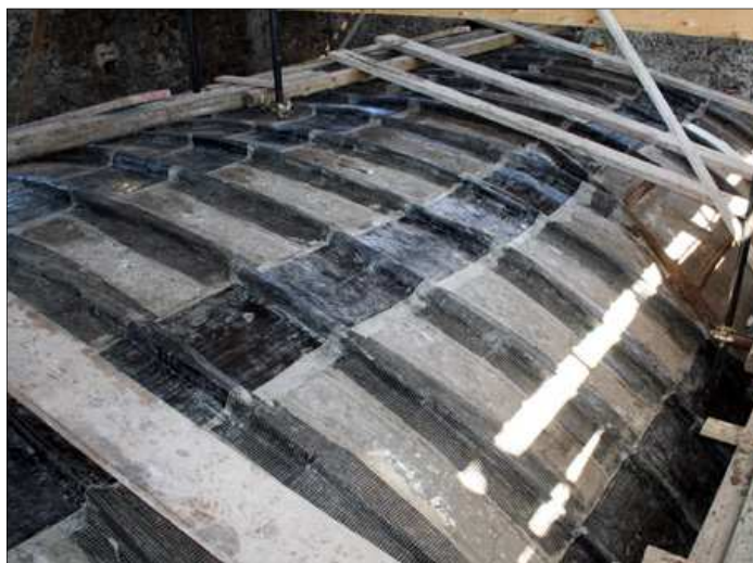
Figura 5.12: Placcaggio volta a stella con materiale composito (FRP)
