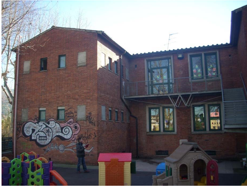
Figura 4 - Veduta del giardino interno
