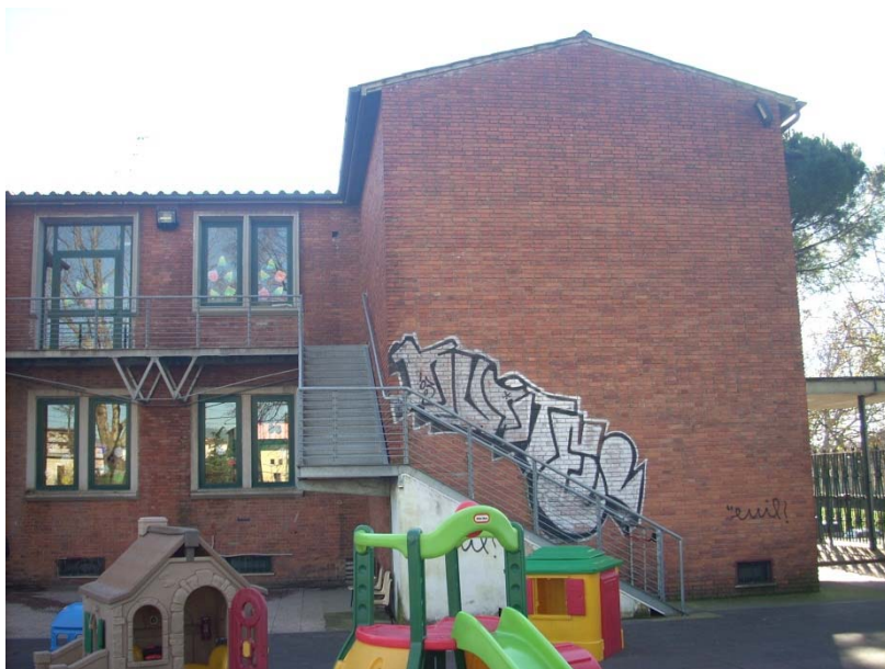
Figura 5 - Veduta della scala antincendio
