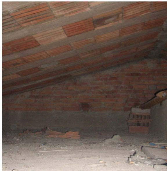
Figura 22 - Solaio di copertura e di sottotetto
