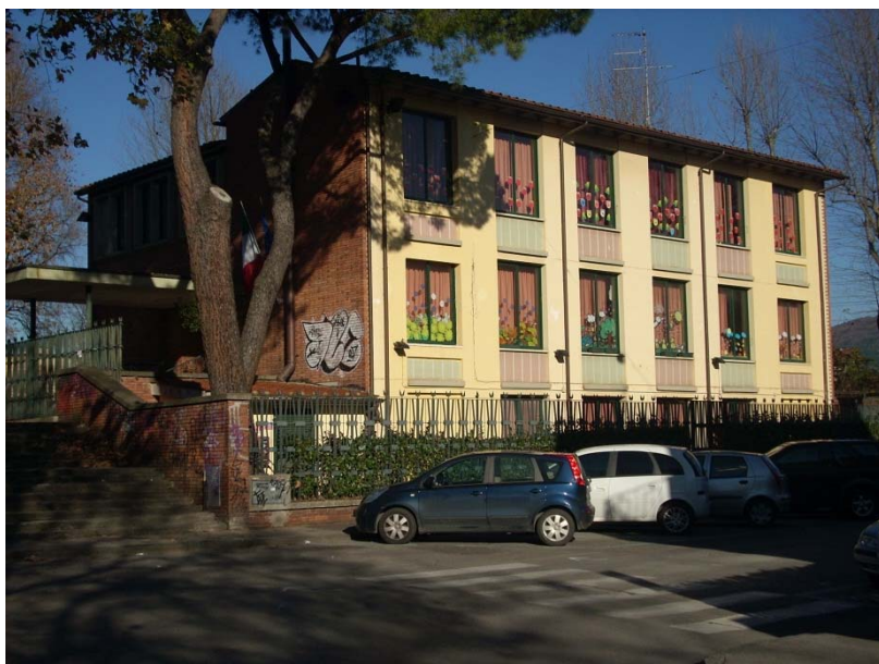
Figura 2 - Veduta da via Giovanni Amendola
