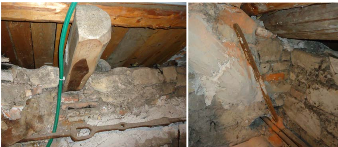
Figura 4.4-12: Tirante numero 5, posizionato all'interno del sottotetto, e relativo capochiave addossato al muro trasversale interno.
