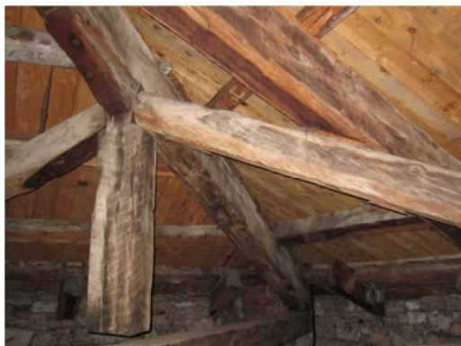
Figura 4.1-8: Copertura, soluzione d'angolo e vista di parte della capriata.
