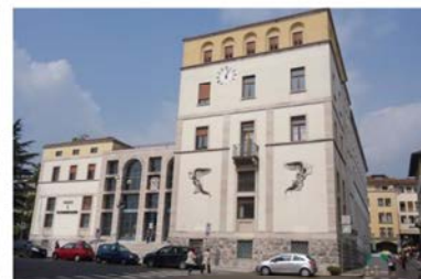
4 Palazzo delle Poste
