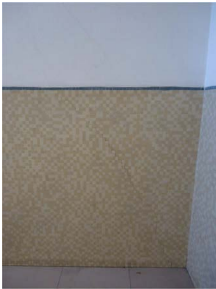
Figura 4.2-10: Fessure nel pianerottolo.
