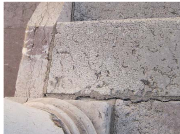
Figura 4.2-5: Fessurazione dei gradini di ingresso.
