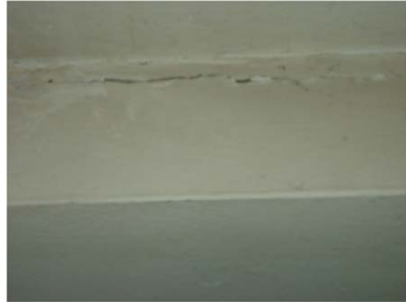
Figura 4.2-3: Fessurazione di un architrave.
