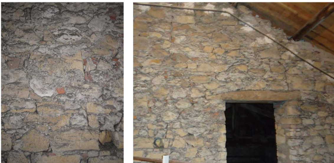
Figura 4.1-2: Parete non intonacata nel sottotetto.
