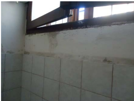
Figura 4.2-4: Esempio di degrado causato dall'umidità.
