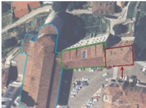
Figura 5.5-53: Individuazione del contesto urbano in cui è inserito Palazzo Rosso (in rosso), affiancato da Palazzo ex Tribunale (in verde) e vicino alla chiesa (in azzurro).
