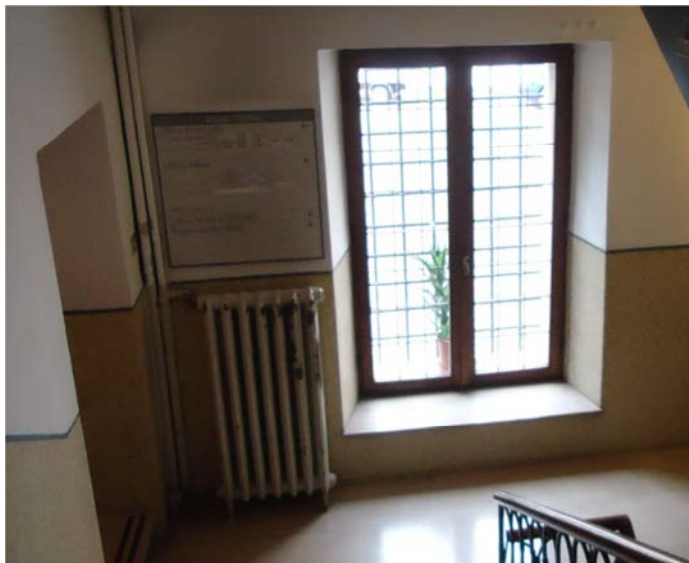
Figura 4.3-1: Esempio di posizionamento dei corpi riscaldanti.
