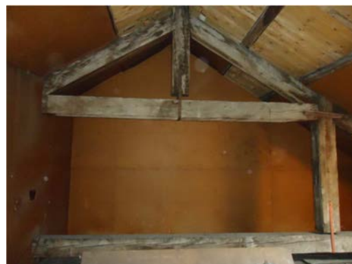
Figura 4.1-8: Copertura, soluzione d'angolo e vista di parte della capriata.
