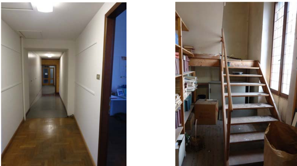
Figura 2.2-10: Interno dell'edificio, collegamento tra gli edifici adiacenti, al secondo piano e scala alla marinara di accesso alla soffitta.
