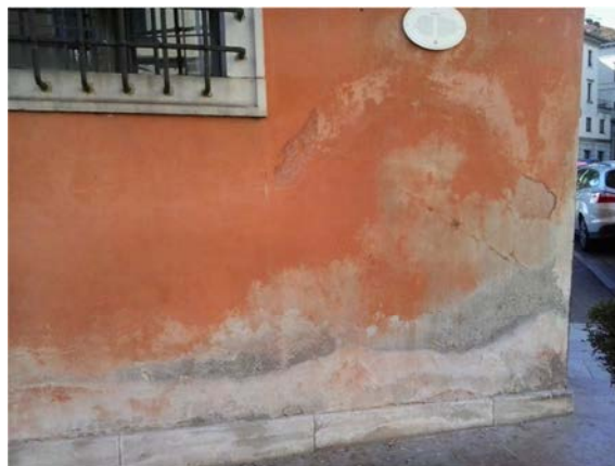
Figura 4.2-21: Distacco dell'intonaco.
