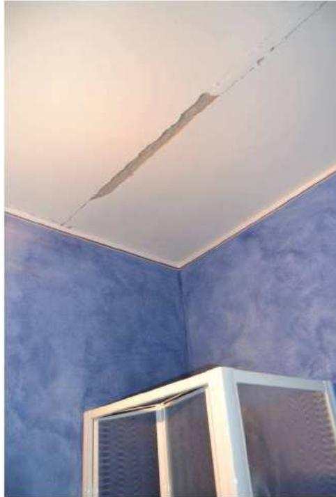
Foto n° 87 – Lesioni longitudinale su solaio con distacco di intonaco.
