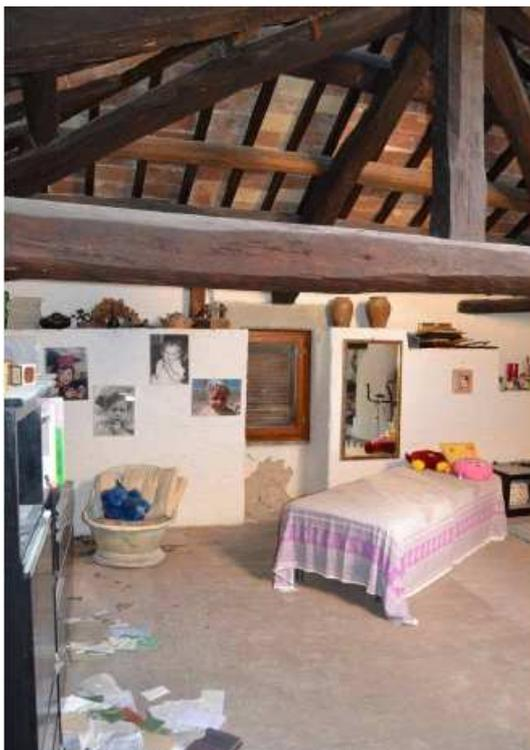
Foto n° 160 – Lesione sottofinestra con distacco di materiale.
