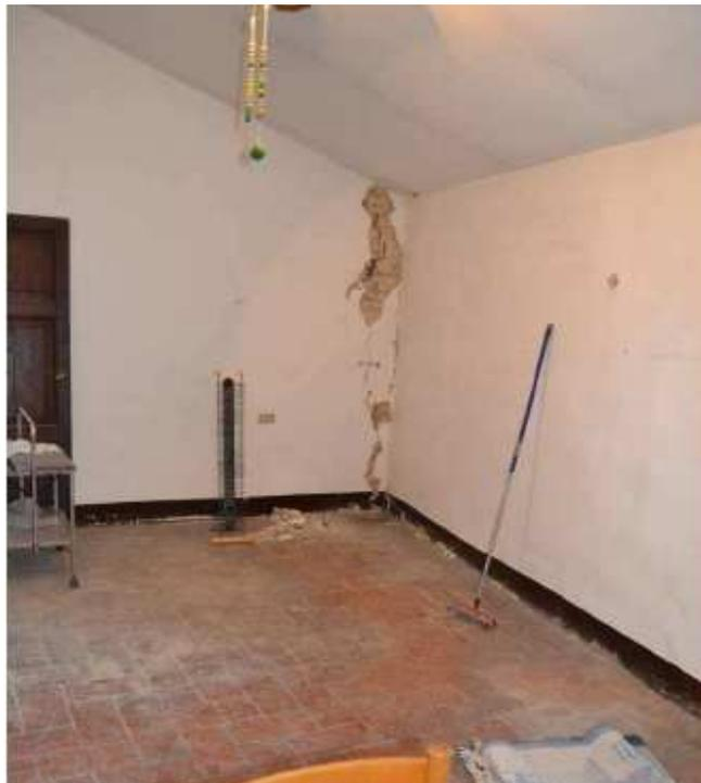
Foto n° 144 – Lesione verticale in prossimità dell'incrocio murario con distacco di materiale e lesione di distacco sul pavimento per allontanamento della parete.
