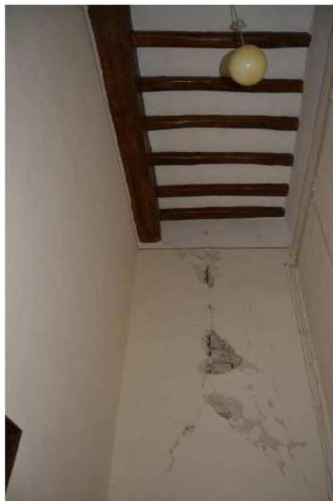
Foto n° 78 – Lesioni verticali e sub-verticali sopra l'apertura.
