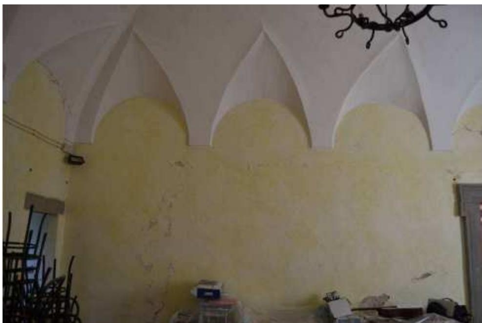
Foto n° 39 – Lesioni su soffitto voltato, su muratura e su muratura sopra l'apertura.
