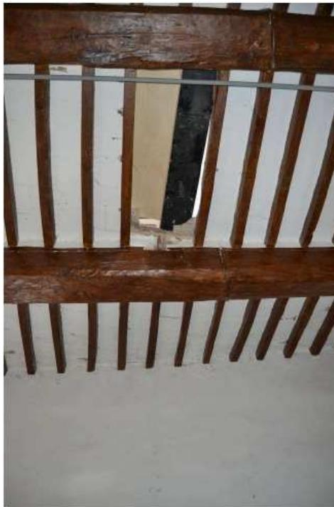
Foto n° 69 – Soffitto lesionato dal crollo del solaio di sottotetto.
