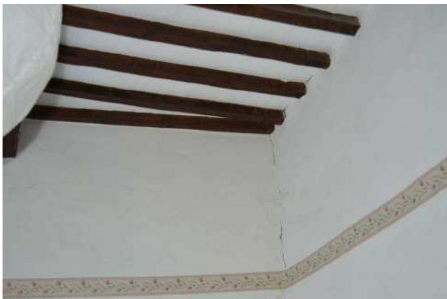
Foto n° 134 – Lesione verticale all'incrocio murario che prosegue all'attacco dei travetti del solaio sulla muratura.
