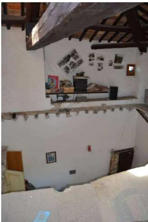
Foto n° 159– Solaio sottotetto porzione crollata.
