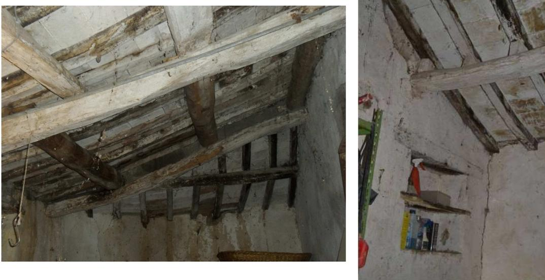
**Figura 7.2.1** – Copertura esistente – stato di danneggiamento.
