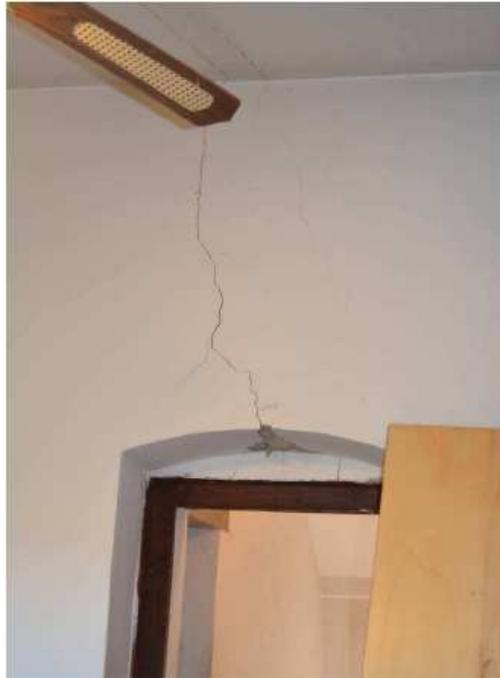
Foto n° 139 – Lesione verticale sopra apertura che prosegue nel soffitto.
