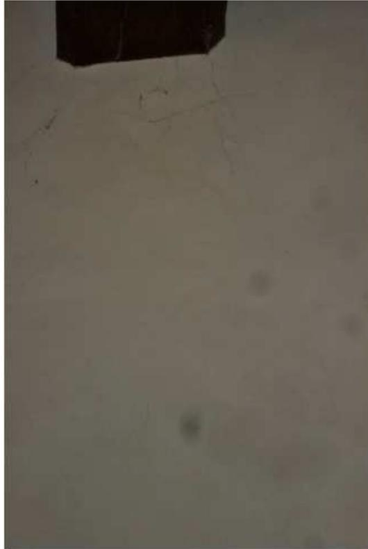
Foto n° 9 – Fessurazione diffusa dell'intonaco sotto la trave principale del solaio.
