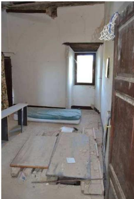
Foto n° 121 – Solaio lesionato dal crollo del solaio di sottotetto.
