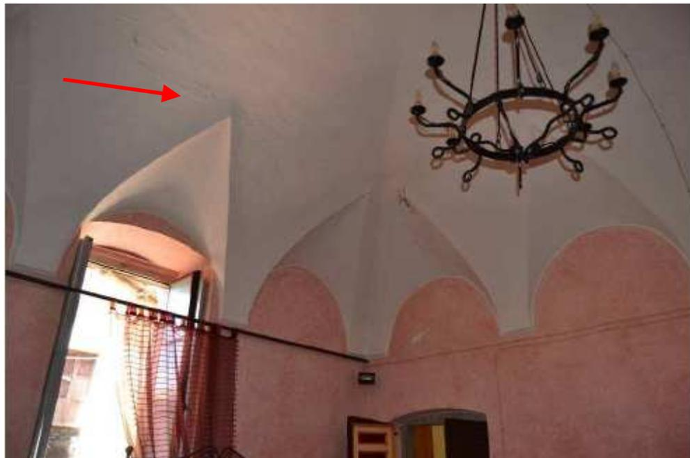
**Figura 7.6.1.6** –Volte a padiglione: lesioni parallele alle pareti.
