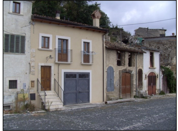
Prospetto frontale (Via San Giovanni)
