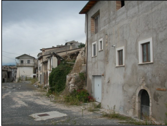
Prospetto frontale (Via San Giovanni)
