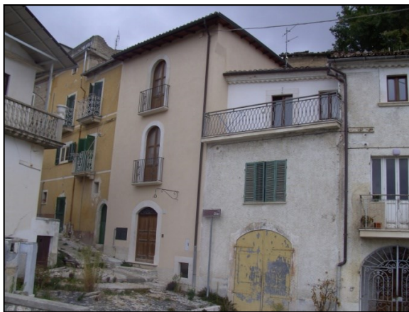
Prospetto frontale (Via Diaz)
