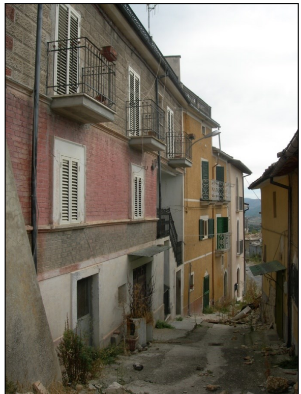
Prospetto frontale (Via Diaz)
