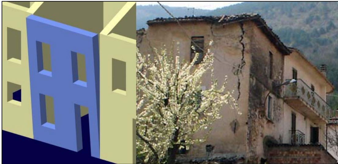
Fig. 6.1-2. Ribaltamento semplice di piano terra e 1° piano (MEDEA, Papa e Zuccaro, 2001)
