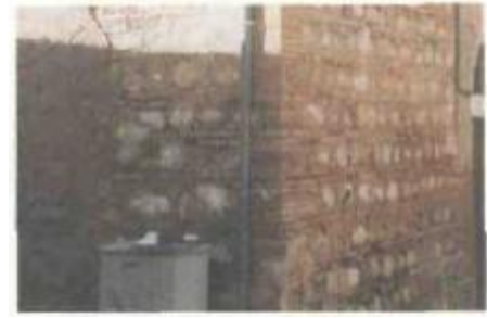
Figura I.6 : Medea (Zuccaro – Papa): muratura di pietrame con ricorsi laterizi (Cast. Dei Sauri, FG)
