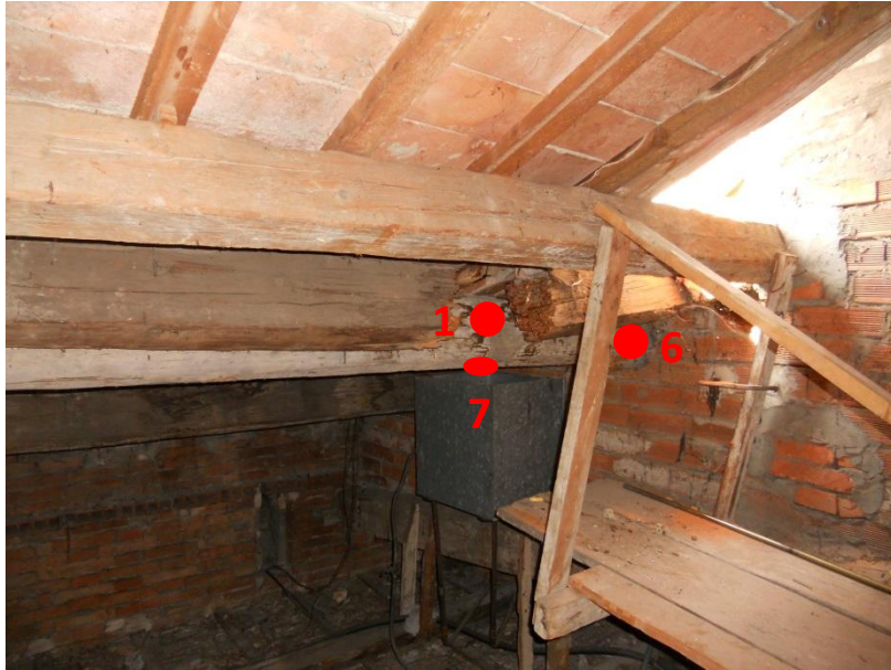
Figura III.32 : Travi sottotetto - Fori 1,6,7
