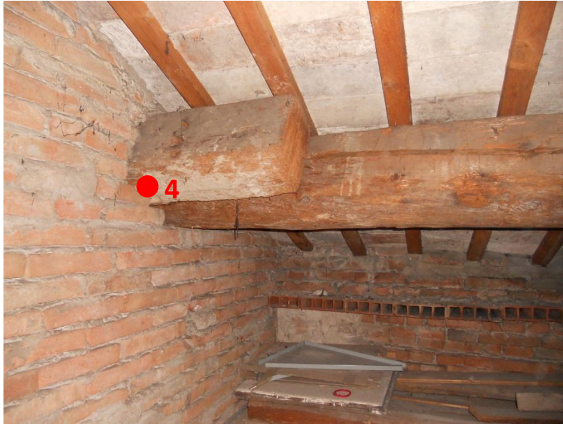
Figura III.36 Travi sottotetto - Foro 4
