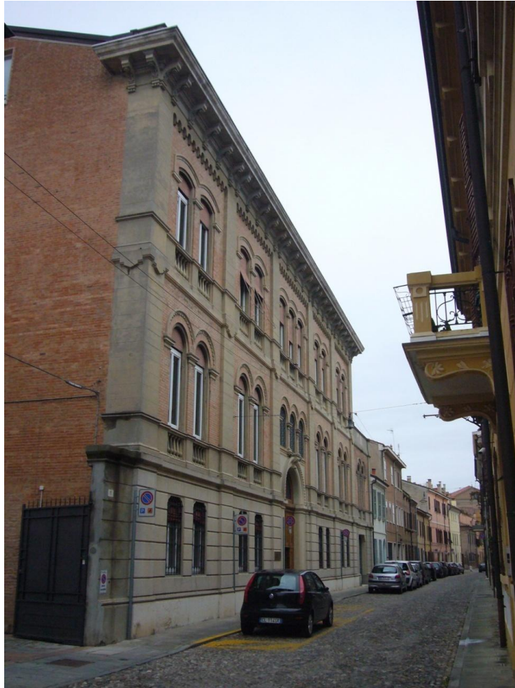
Figura IV.4 : Foto del prospetto dell'edificio
