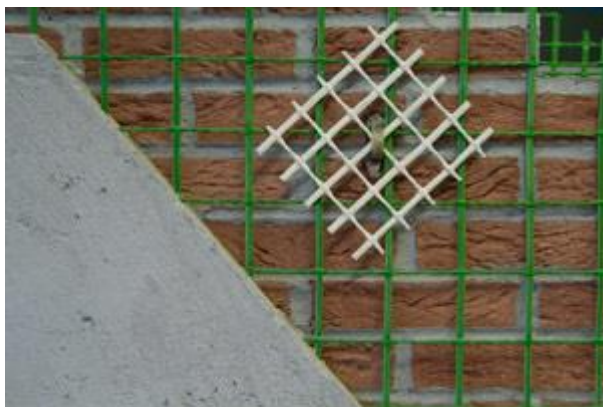
Figura III.79 : Intonaco armato realizzato con connettori e armatura in FRP
