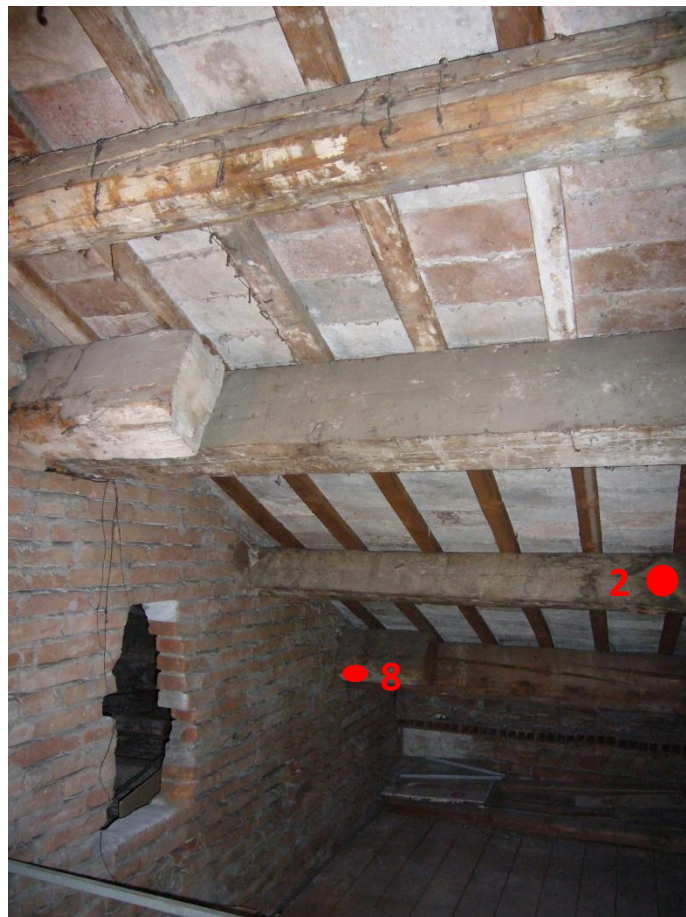
Figura III.33 : Travi sottotetto - Fori 2,8
