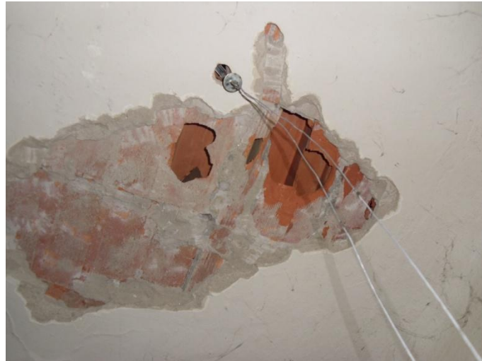
Figura III.12: Foto del sondaggio effettuato sul solaio del primo impalcato
