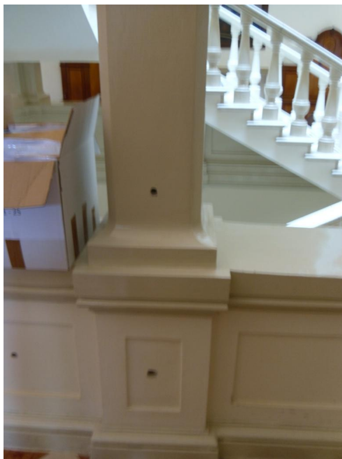
Figura IV.22 : Foto del pilastro su cui sono stati eseguiti i fori per la verifica del materiale
