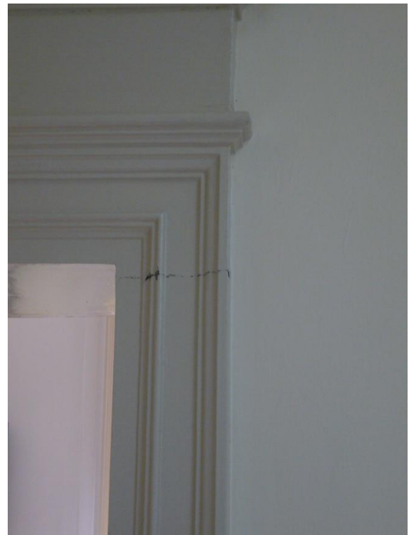
Figura IV.15 : Foto del quadro fessurativo in atto
