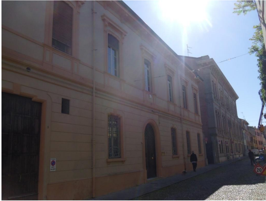
Figura III.3 : Foto del prospetto di via Mentana 3
