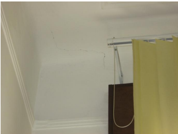
Figura III.11 : Foto relative al quadro fessurativo in atto
