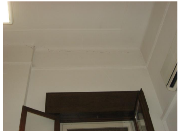
Figura III.11 : Foto relative al quadro fessurativo in atto
