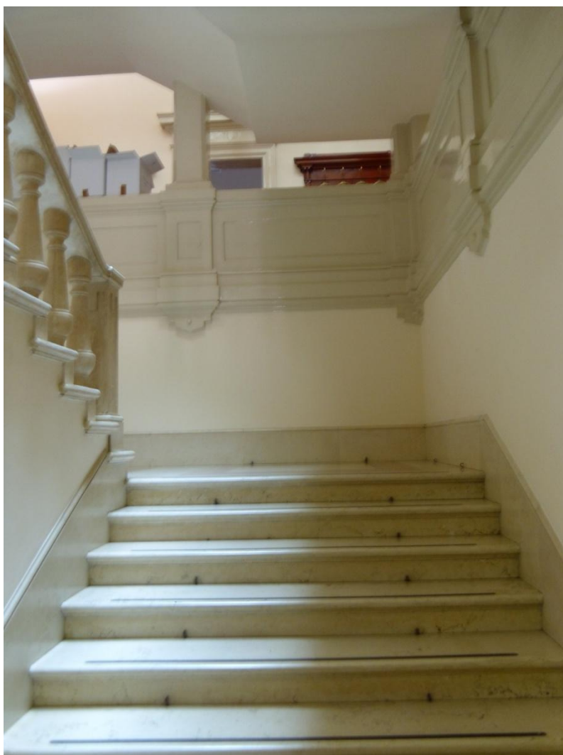
Figura IV.100 : Prima rampa di scale piano terra
