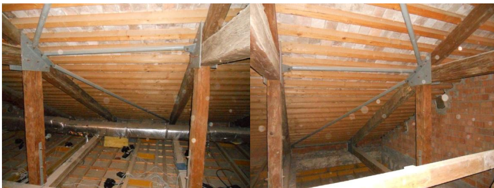
Figura III.71 : Irrigidimento falda con elementi in acciaio
