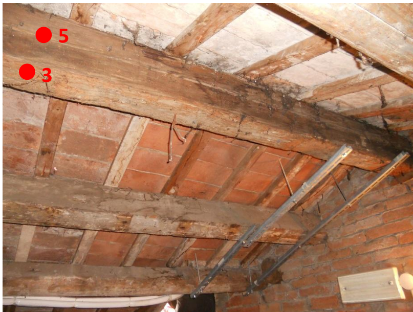
Figura III.35 : Travi sottotetto - Fori 3,5
