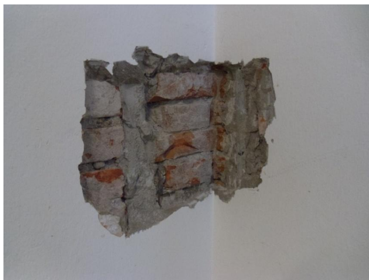
Figura III.15 : Foto delle pareti su cui è stato rimosso l'intonaco per verificare la presenza di ammorsamento
