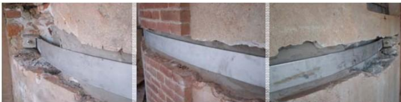
Figura III.80 : Esempio di installazione cordolo metallico sotto intonaco
