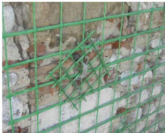
Figura III.79 : Intonaco armato realizzato con connettori e armatura in FRP
