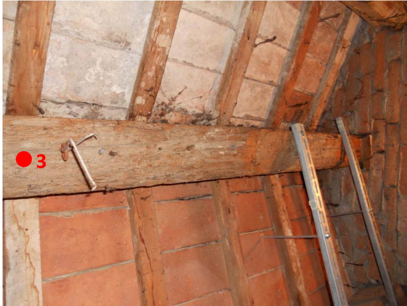
Figura III.34 : Travi sottotetto - Foro 3
