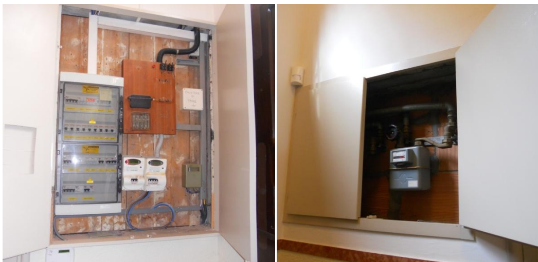
Figura III.20 : Foto delle nicchie al piano terra
