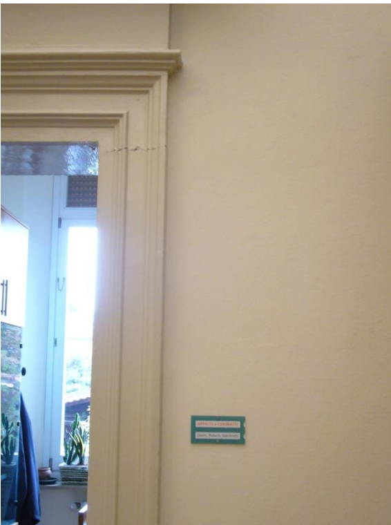
Figura IV.15 : Foto del quadro fessurativo in atto
