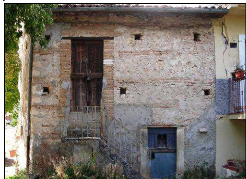
Figure: esempi di ricorsi in mattoni su murature in pietrame
