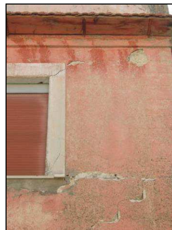
Figure: Particolari delle lesioni dovute a rottura per pressoflessione dei maschi murari della parete 1
