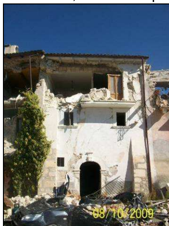
Figure: Parete su cui si è attivato il meccanismo di ribaltamento all'ultimo piano dell'US
