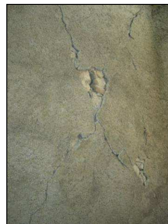
Figure: Particolari delle lesioni ad andamento diagonale della parete 4 e 1
