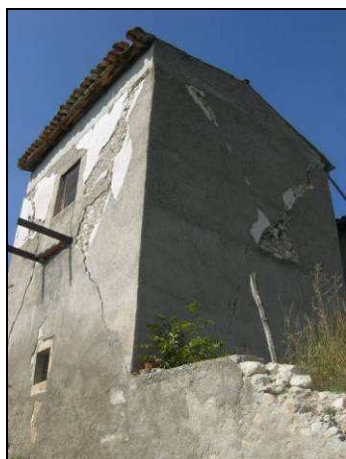
Figura: Meccanismo nel piano della parete 4
