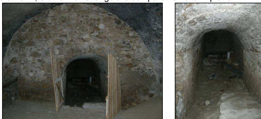
Figure: Parte iniziale di una cavità con pareti e volte rivestite in pietra
