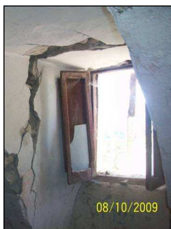
Figure: Particolari del distacco dalla parete del solaio del piano primo
