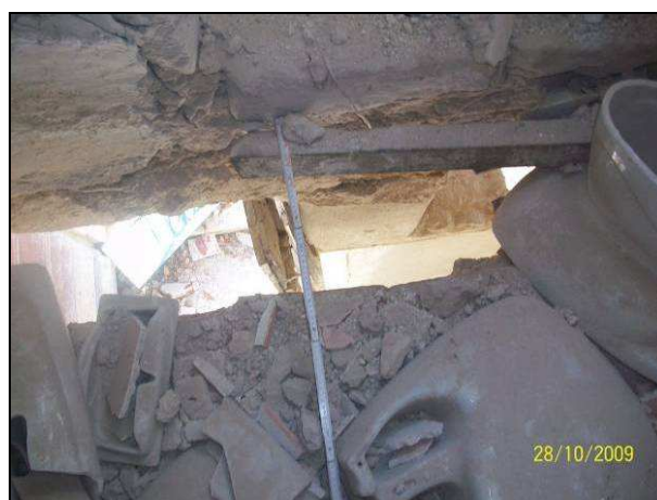
Figure: Particolari del distacco dalla parete del solaio del piano primo
