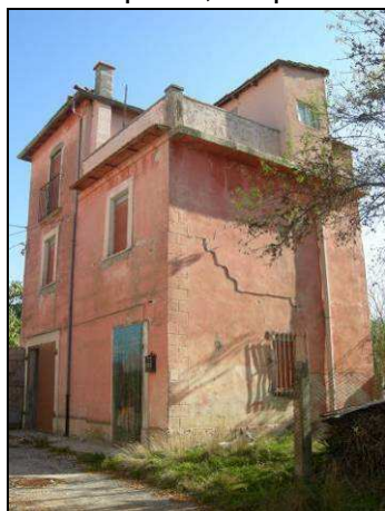
Figura: US interessata da meccanismi nel piano
