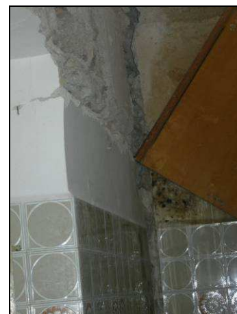
Figure: Due particolari della lesione verticale rilevata all'interno dell'US al primo piano
