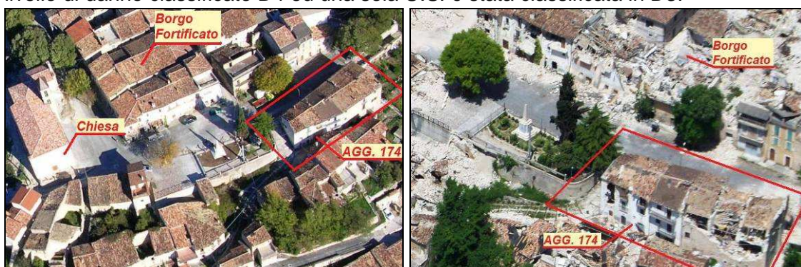
Figura: immagini pre-sisma dell'aggregato edilizio 174
