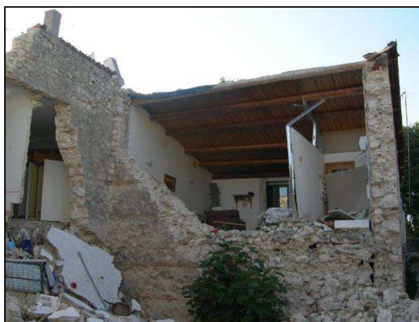
Figura: Meccanismo di ribaltamento semplice della parete 1
