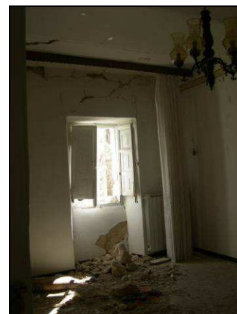
Figure: Particolari interni delle rotture delle fasce della parete 1
