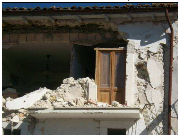
Figure: Parete su cui si è attivato il meccanismo di ribaltamento all'ultimo piano dell'US
