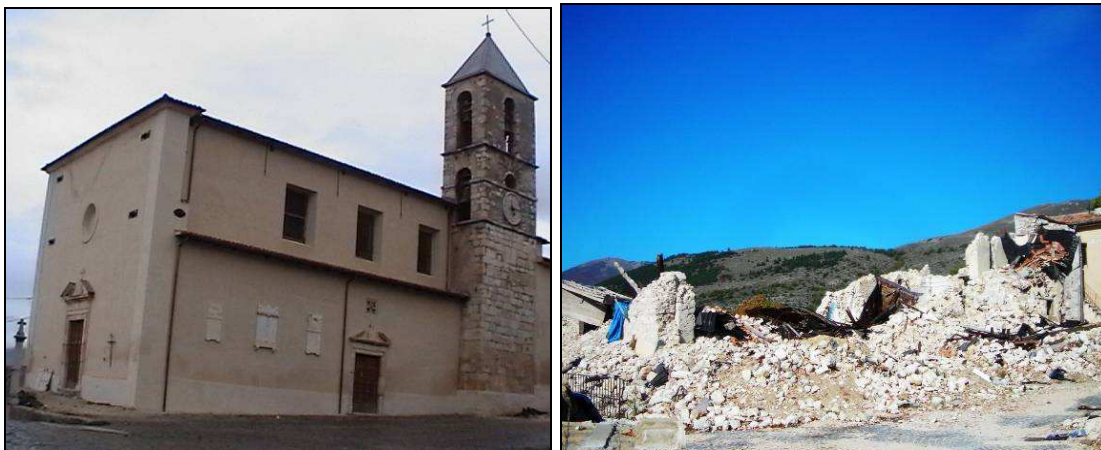
Figura: vista pre e post sisma della Chiesa Parrocchiale vicino al Borgo Fortificato
