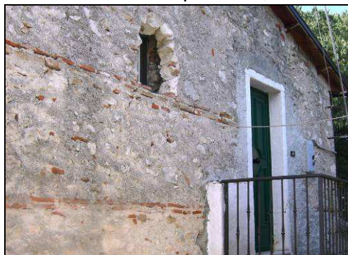
Figure: esempi di ricorsi in mattoni su murature in pietrame
