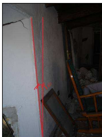
Figure: Particolari dell'inclinazione della parete e del distacco dell'orizzontamento dalla parete stessa
