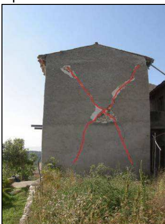
Figure: Particolari delle lesioni ad andamento diagonale della parete 4 e 1
