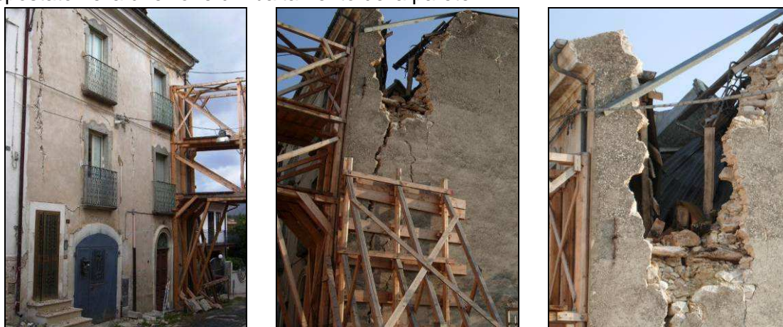
Figure: Parete su cui si è attivato il meccanismo di ribaltamento e particolari delle lesioni verticali visibili sulla parete laterale 2
