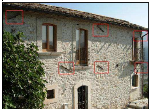
Figure: esempi di catene posizionate in maniera corretta
