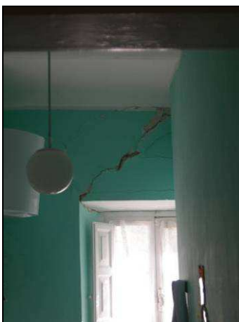
Figure: Particolari interni delle rotture delle fasce della parete 1
