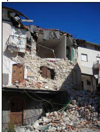
Figure: Ribaltamento della parete 1 dell'US
