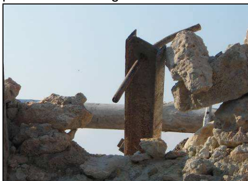
Figure: collegamenti delle travi alle murature mediante bolzoni metallici
