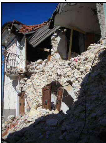
Figure: Ribaltamento della parete 1 dell'US
