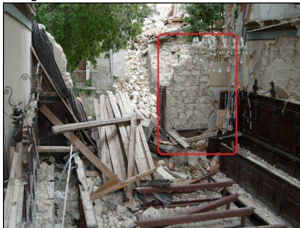
Figure: Ribaltamento della parete 1 dell'US vista sia dall'esterno che dall'interno; nei riquadri è indicata la porzione della facciata in cui il crollo ha interessato solo la cortina esterna
