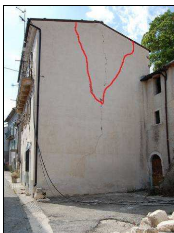
Figure: Particolari delle lesioni e della geometria del cuneo di distacco
