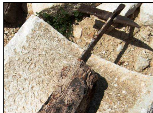
Figure: collegamenti delle travi alle murature mediante bolzoni metallici
