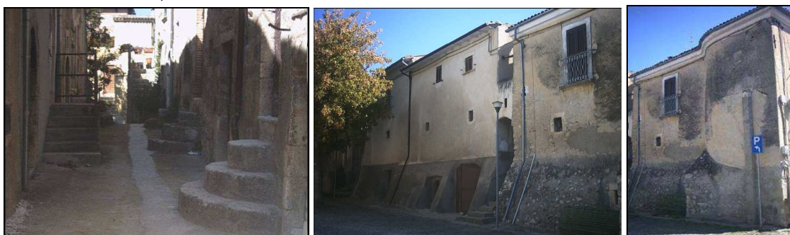
Figura: Le case mura del Borgo Fortificato e i gradoni di accesso alle unità abitative
