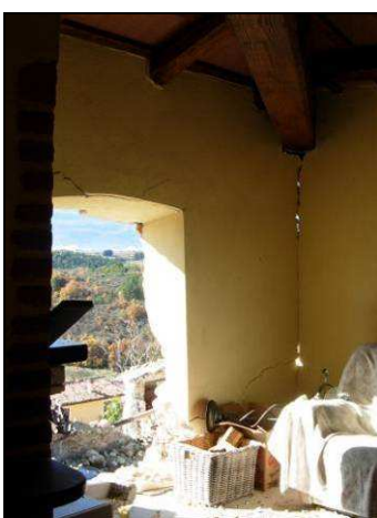
Figure: Particolari dei collegamenti alla parete del solaio di copertura e del piano secondo
