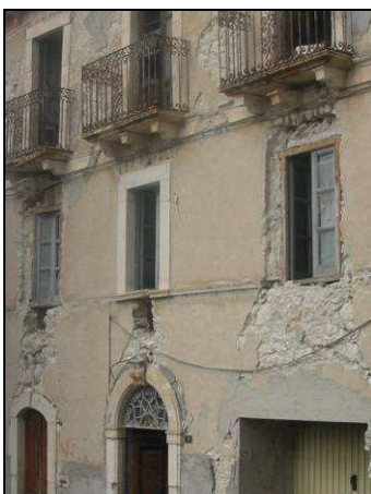
Figure: Particolari delle rotture per flessione delle fasce di piano della parete 1
