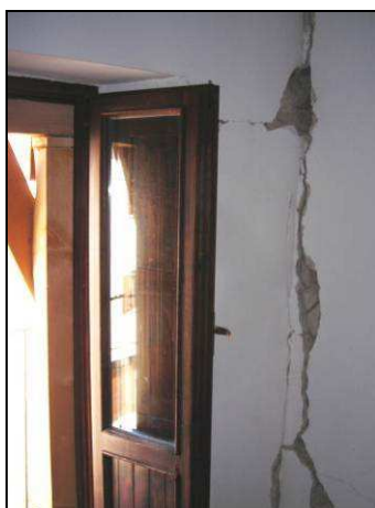
Figure: Lesioni verticali rilevate all'interno dell'US all'ultimo piano
