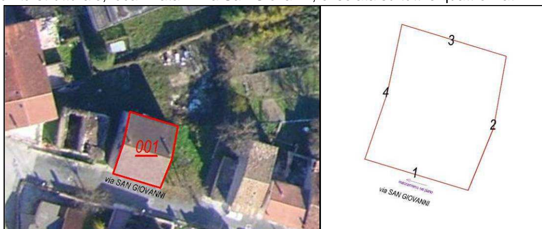
Figure: Foto aerea con l'inquadratura dell'US e planimetria della tipologia dei danni rilevati
