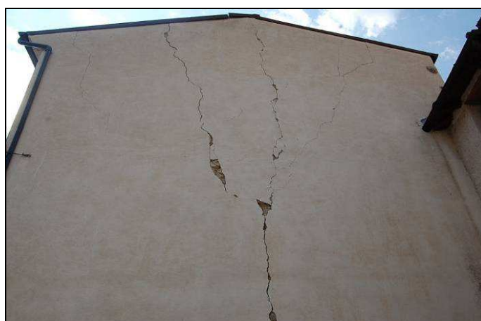
Figure: Particolari delle lesioni e della geometria del cuneo di distacco
