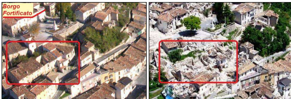
Figura: vista aerea pre e post-sisma dell'aggregato edilizio 051-236
