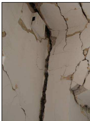
Figure: Lesione orizzontale passante in corrispondenza dell'orizzontamento del secondo piano e lesione verticale rilevate all'interno dell'US al primo piano
