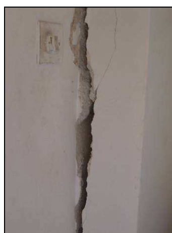
Figure: Lesione orizzontale passante in corrispondenza dell'orizzontamento del secondo piano e lesione verticale rilevate all'interno dell'US al primo piano
