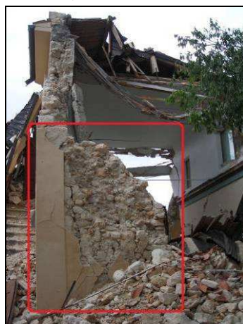
Figure: Ribaltamento della parete 1 dell'US vista sia dall'esterno che dall'interno; nei riquadri è indicata la porzione della facciata in cui il crollo ha interessato solo la cortina esterna
