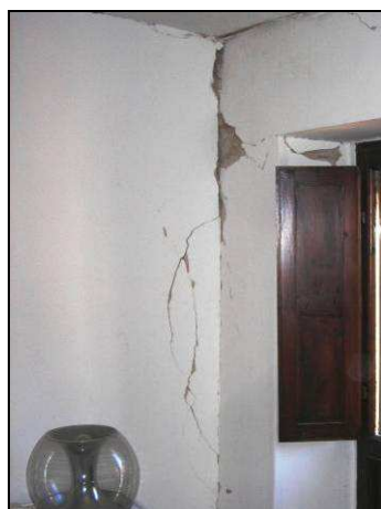
Figure: Lesioni verticali rilevate all'interno dell'US all'ultimo piano
