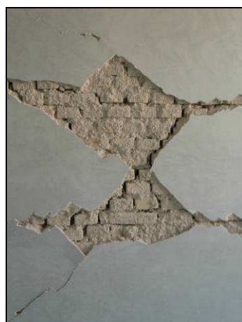
Figure: Particolari della rottura di un maschio con indicazione dell'andamento delle lesioni diagonali
