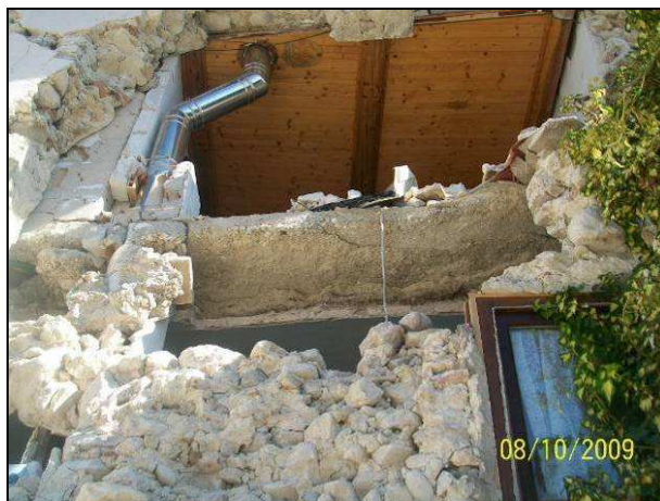
Figure: Particolari dei collegamenti alla parete del solaio di copertura e del piano secondo
