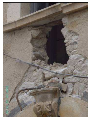
Figure: Particolari delle rotture per flessione delle fasce di piano della parete 1
