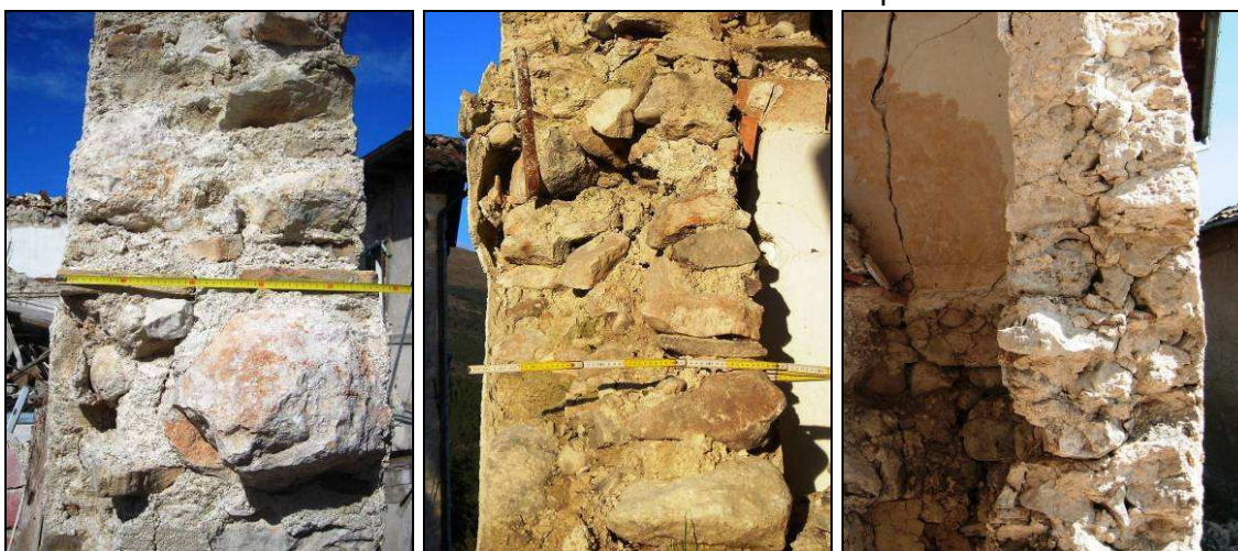
Figura: sezioni di tre pannelli di muratura "tipici" osservati
