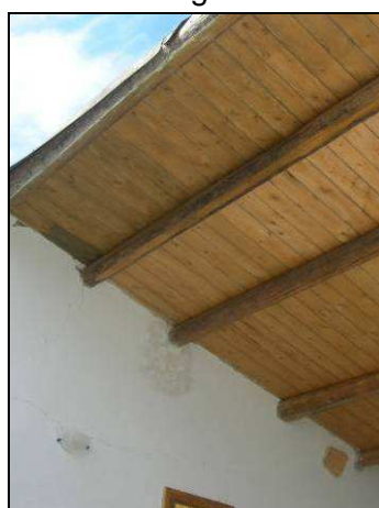
Figura: Particolare dell'orditura della copertura
