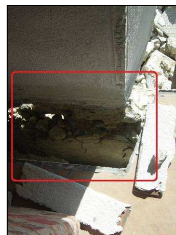
Figure: Particolari dell'inclinazione della parete e del distacco dell'orizzontamento dalla parete stessa
