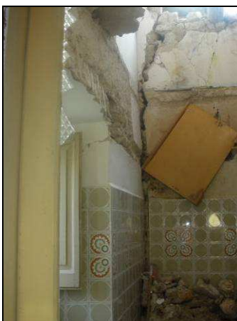
Figure: Due particolari della lesione verticale rilevata all'interno dell'US al primo piano
