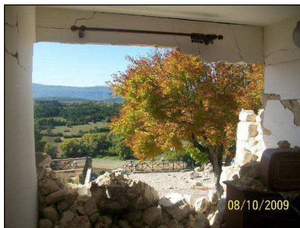
Figure: Particolare del collegamento del solaio di copertura alla parete e vista interna del piano in cui è avvenuto il cinematico
