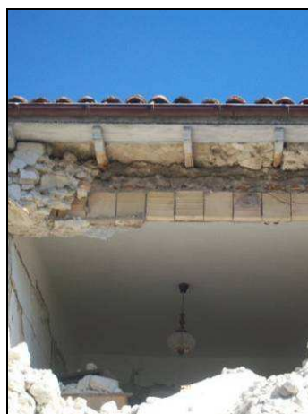
Figure: Particolare del collegamento del solaio di copertura alla parete e vista interna del piano in cui è avvenuto il cinematico
