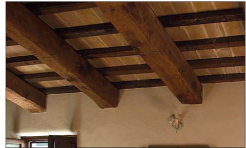
Solaio in legno con mezzane
