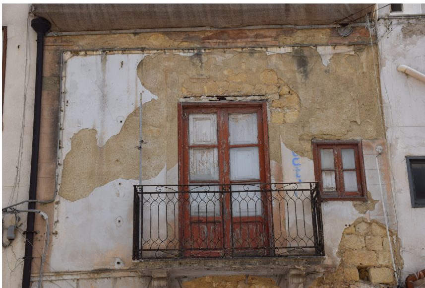
Foto 2.2.5_4 - Tessitura muraria composta da conci di calcarenite disposti in modo pseudo regolare
