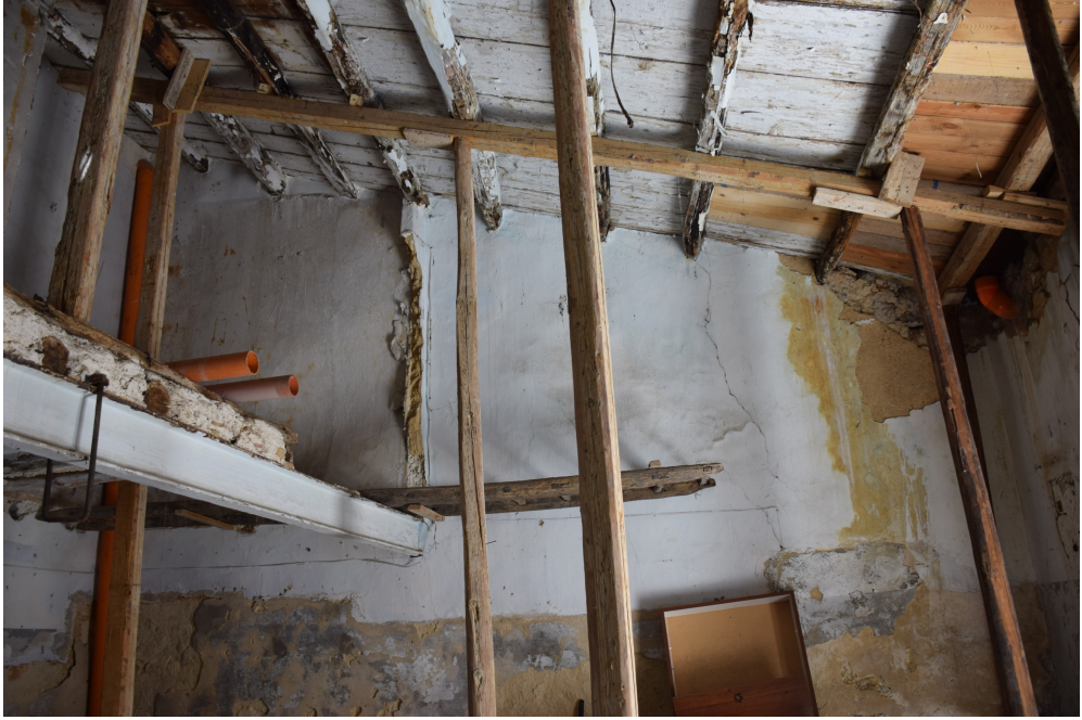
Foto 2.2.5_7 - Collegamento travi della copertura alla muratura del primo livello
