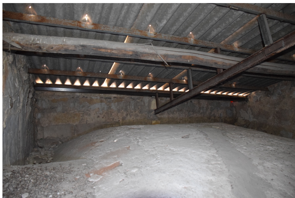
Foto 2.2.5_12 - Particolare della copertura al terzo livello caratterizzata da una struttura di acciaio con lastre poggiate sopra
