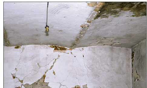
Solaio con travi di ferro a voltine.
