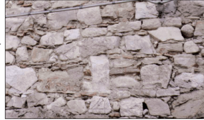
Figura 1.2.1_10 - Abaco delle murature A1 (pietra arrotondata), Manuale Scheda CARTIS
