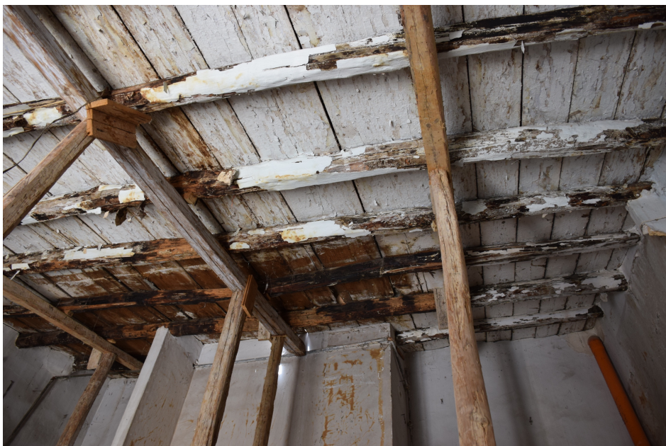
Foto 2.2.5_6 - Copertura costituita da travi uso fiume con assito in legno.
