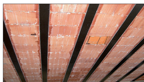
Solaio in ferro e tavelloni.
