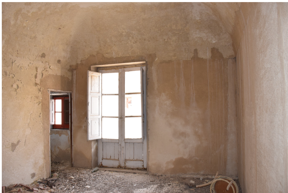
Foto 2.2.5_11 - Presenza della volta a padiglione al secondo livello
