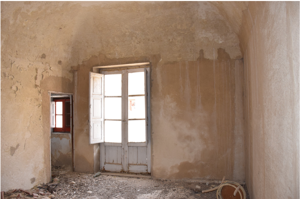
Foto 2.2.3_4 - Vano interno al secondo livello
