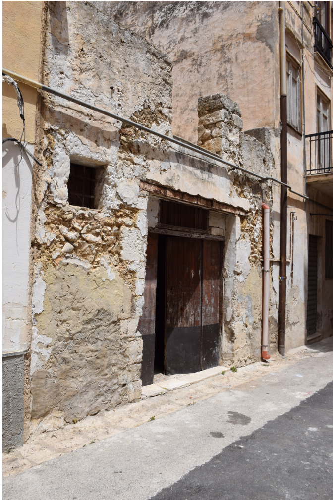
Foto 2.2.3_2 - Prospetto posteriore, Via Crapis, Alcamo (TP)
