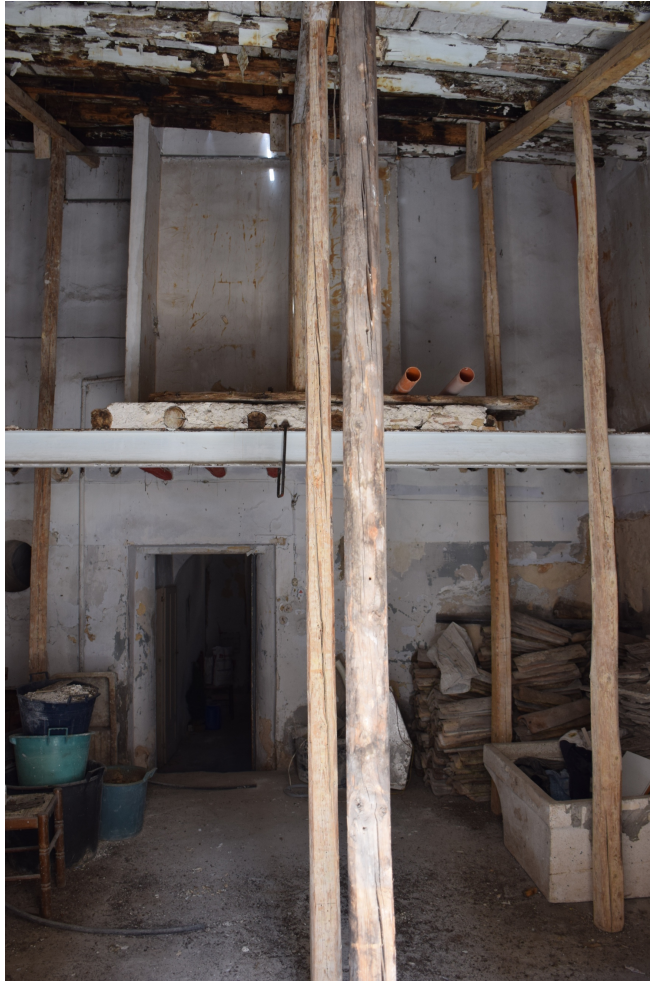
Foto 2.2.5_5 - Vano primo al primo livello con la presenza del soppalco sorretto dalla trave IPE180
