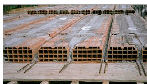
Solaio in laterocemento gettato in opera.
