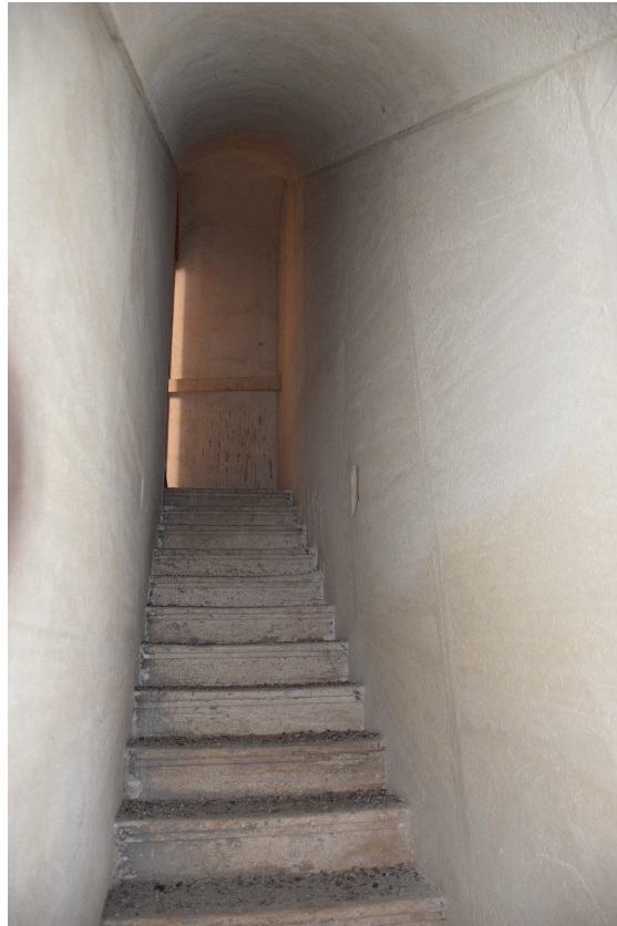
Foto 2.2.5_9 - Scala di collegamento tra il primo e il secondo livello caratterizzato da lastre di pietra che penetrano nella muratura
