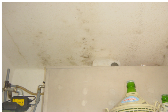
Le foto a sinistra riportano dettagli del intradosso del solaio di copertura dei seminterrati del palazzo A, a destra si notano i fenomeni di umidità a intradosso
