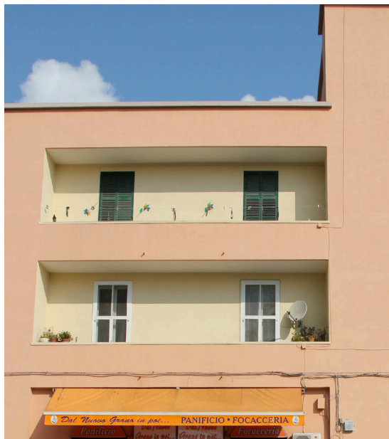
Dettaglio fotografico delle logge | prospetto A1
