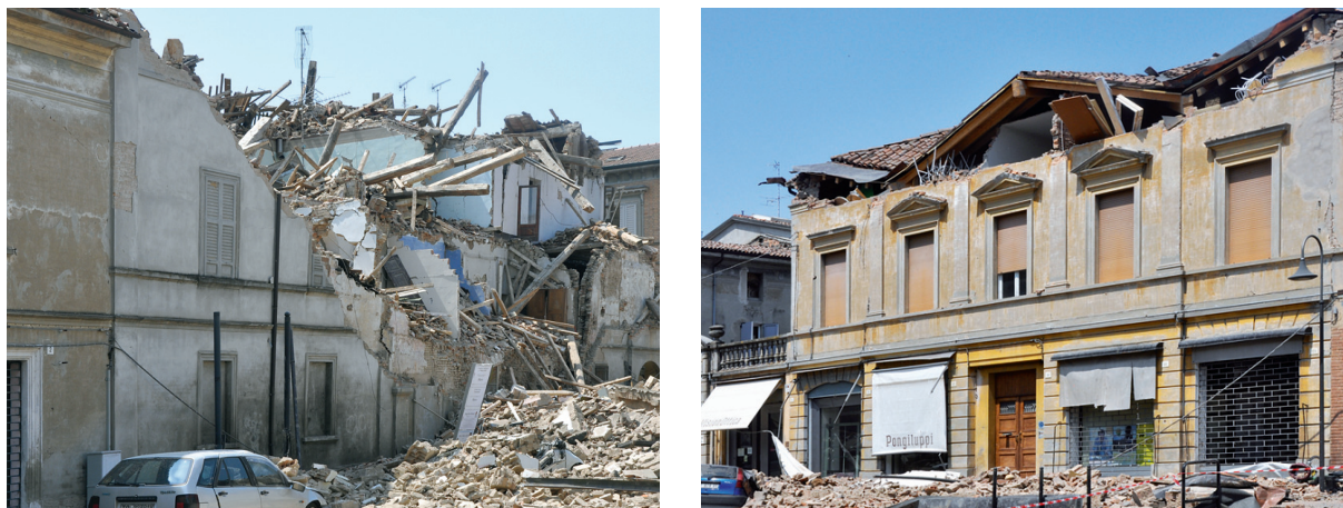
Fig. 4.5 e 4.6 Collapsi parziali fuori piano di facciate in muratura causati da coperture in legno spingenti, nei centri storici di Concordia sulla Secchia in occasione del sisma del 2012 in Emilia
