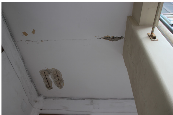
Fig. 7.12 e fig .7.13 Degrado sui pilastri dei telai di sostegno ai ballatoi e fessurazioni per discontinuità materiche nei giunti di connessione tra i diversi elementi strutturali
