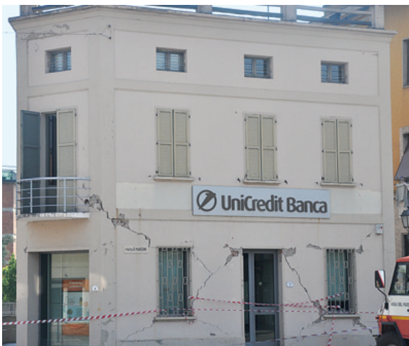
Fig. 4.9 e 4.10 Edifici in cui il danno nel piano è concentrato nei maschi murari o in maschi e fasce murarie a Rovereto sulla Secchia (sisma Emilia 2012)
