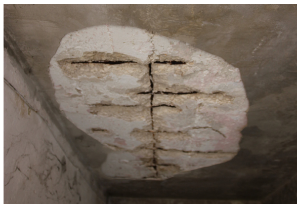
Fig. 7.6 e fig.7.7 Umidità di risalita nel seminterrato della palazzina A e fenomeni di distacco di coriferro e ossidazione delle armature nelle solette a intradosso nel seminterrato della palazzina B
