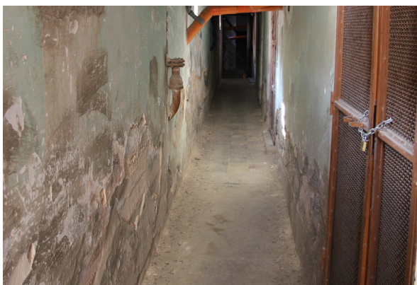
Fig. 7.6 e fig.7.7 Umidità di risalita nel seminterrato della palazzina A e fenomeni di distacco di coriferro e ossidazione delle armature nelle solette a intradosso nel seminterrato della palazzina B
