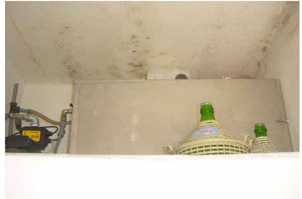
Fig. 7.10 e fig. 7.11 Fenomeni di condensa da ponte termico all'interno dei locali residenziali
