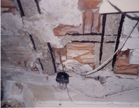
Fig 2.11 e 2.12 Distacchi di copriferro nei primi solai in laterocemento
