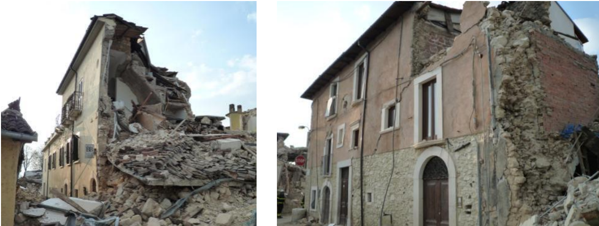
Fig. 4.1 e 4.2 Collapsi per disgregazione della qualità muraria ad Onna in occasione del sisma del 2009 in Abruzzo
