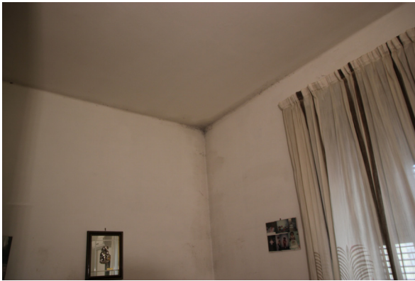
Fig. 7.10 e fig. 7.11 Fenomeni di condensa da ponte termico all'interno dei locali residenziali
