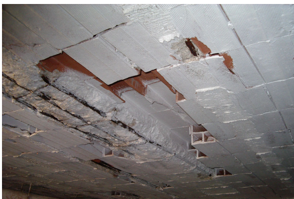
Fig. 7.8 e fig.7.9 Sfondellamento delle pignatte e distacchi di copriferro a intradosso nel seminterrato della palazzina A e sui pilastri del ricovero della palazzina A
