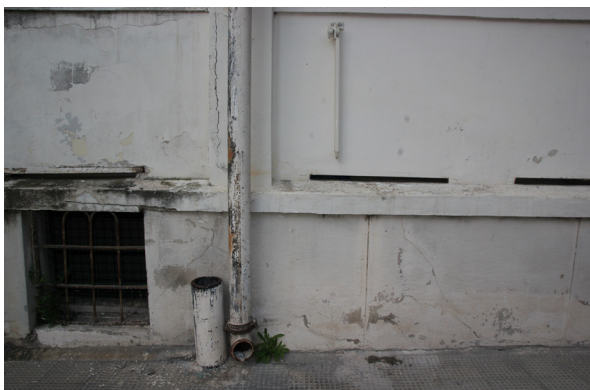
Fig. 7.12 e fig .7.13 Degrado sui pilastri dei telai di sostegno ai ballatoi e fessurazioni per discontinuità materiche nei giunti di connessione tra i diversi elementi strutturali
