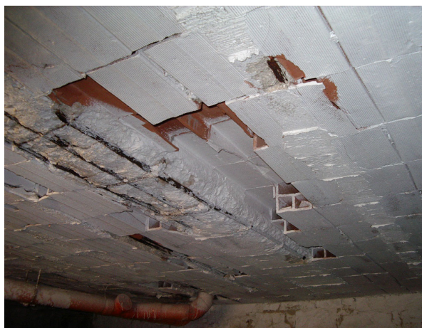
Fig 2.15 e 2.16 Sfondellamento nei solai in laterocemento e distacchi di copriferrì
