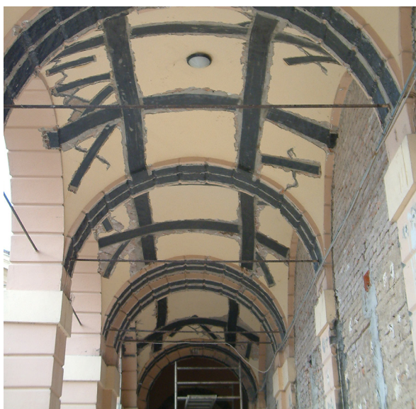
Fig. 6.1 e 6.2 Fasciature con FRP su volte e pilastri
