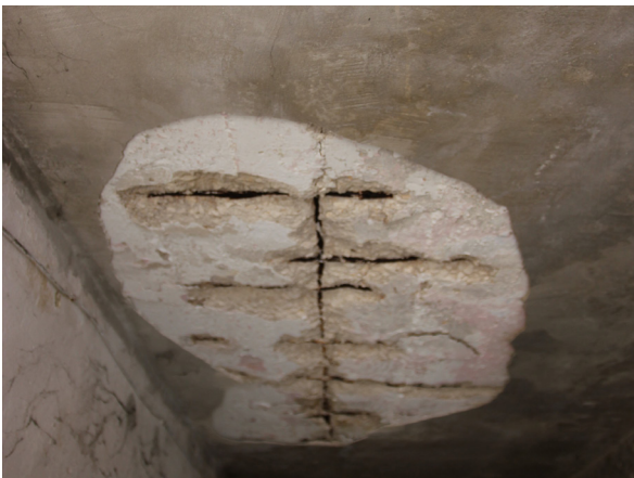
Fig 2.13 e 2.14 Distacchi di copriferro nei primi solai in calcestruzzo e fessurazioni per discontinuità materiche nei giunti
