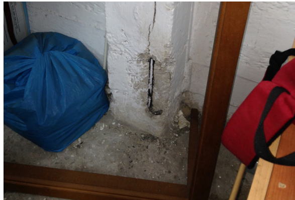
Fig. 7.8 e fig.7.9 Sfondellamento delle pignatte e distacchi di copriferro a intradosso nel seminterrato della palazzina A e sui pilastri del ricovero della palazzina A
