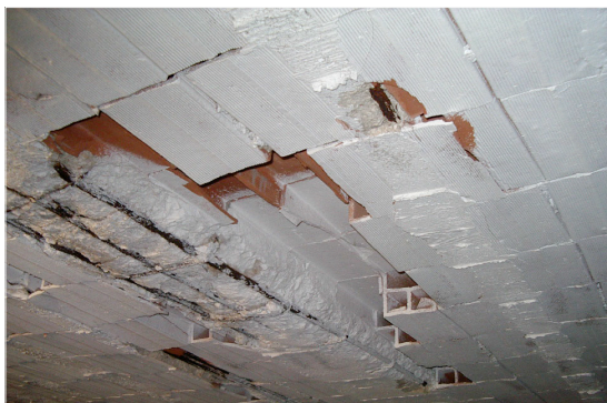
Le foto a sinistra riportano dettagli del intradosso del solaio di copertura dei seminterrati del palazzo A, a destra si notano i fenomeni di umidità a intradosso
