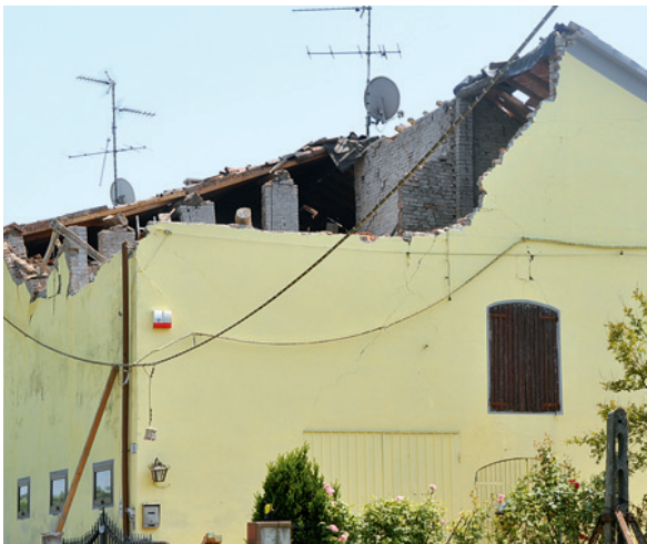
Fig. 4.20 e 4.21 Edifici in cui il danno nel piano è concentrato nei maschi murari o in maschi e fasce murarie a Rovereto sulla Secchia (sisma Emilia 2012)
