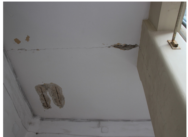
Fig 2.13 e 2.14 Distacchi di copriferro nei primi solai in calcestruzzo e fessurazioni per discontinuità materiche nei giunti
