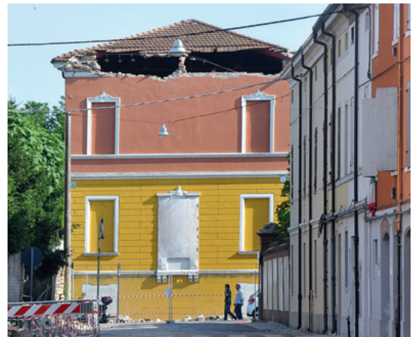
Fig. 4.20 e 4.21 Edifici in cui il danno nel piano è concentrato nei maschi murari o in maschi e fasce murarie a Rovereto sulla Secchia (sisma Emilia 2012)
