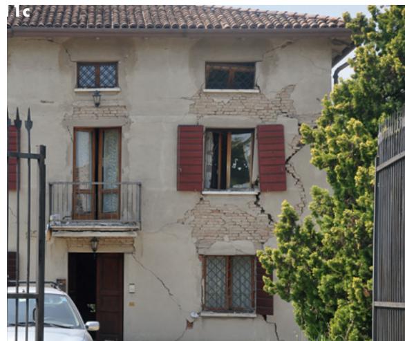
Fig. 4.9 e 4.10 Edifici in cui il danno nel piano è concentrato nei maschi murari o in maschi e fasce murarie a Rovereto sulla Secchia (sisma Emilia 2012)
