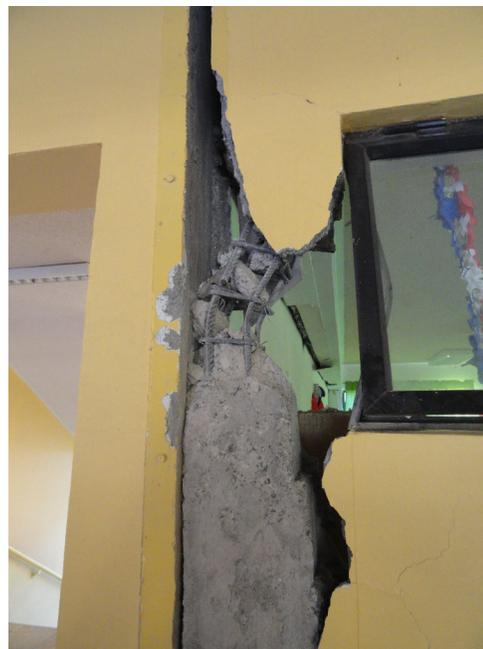
**Figura 11:** Pandeo del refuerzo en columnas. Fuente: elaboración propia.
