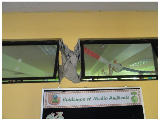
**Figura 12:** Pandeo del refuerzo en columnas. Fuente: elaboración propia.
