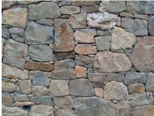
**Figura 1.1** – Muratura a secco in elementi lapidei.
