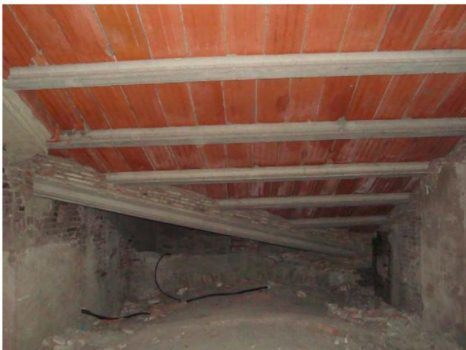
**Figura 4.28** – Intradosso della copertura in laterrocemento nella nuova falda.
