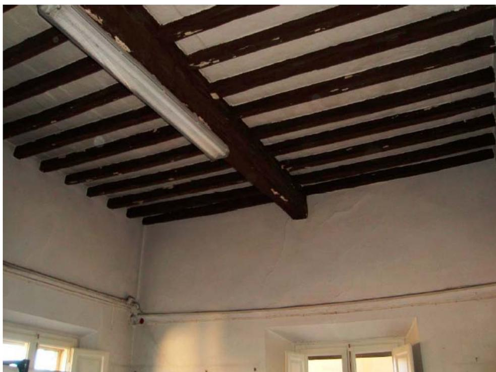
**Figura 4.22** – Intradosso di un solaio ligneo al secondo piano dell'ex porzione Del Torto.
