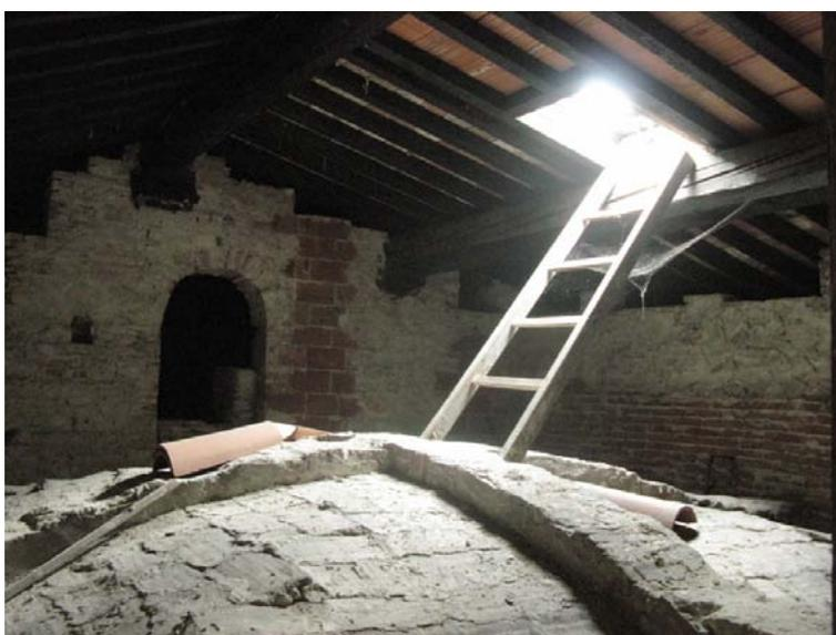
**Figura 4.30** – Intradosso della copertura dell'ala est e vista dell'estradosso della volta sottostante.
