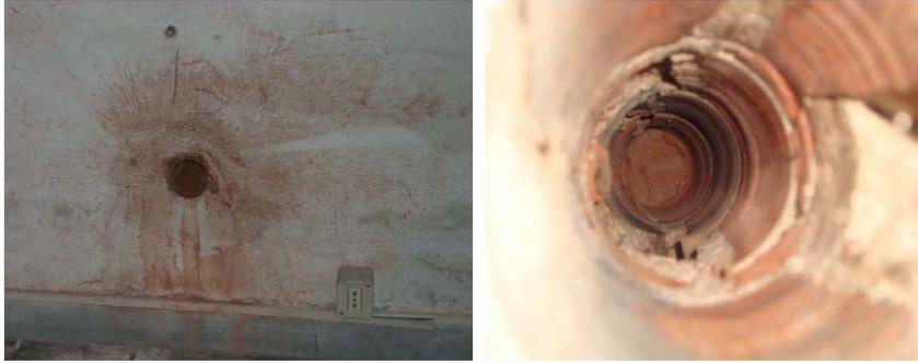
**Figura 4.40** – Carotaggio n°13 realizzato in prossimità di un cantonale a piano terra: muratura piena in laterizio.
