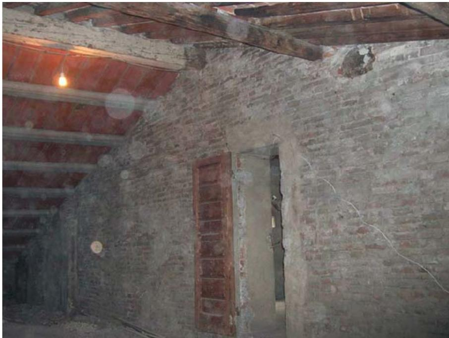
**Figura 4.27** – Intradosso della copertura nella zona del colmo in cui si evidenziano le due tipologie utilizzate.
