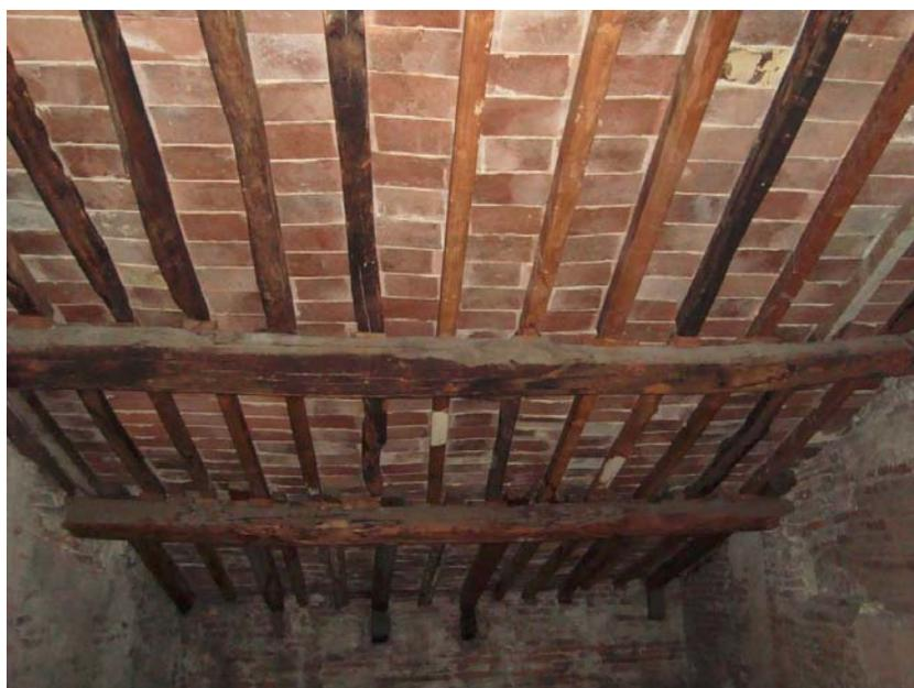
**Figura 4.26** – Intradosso di una copertura lignea con travi, travetti e mezzane.
