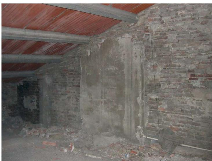
**Figura 4.18** – Particolare tessitura della muratura in mattoni pieni nel sottotetto: parete interna, ortogonale via S.Martino.
