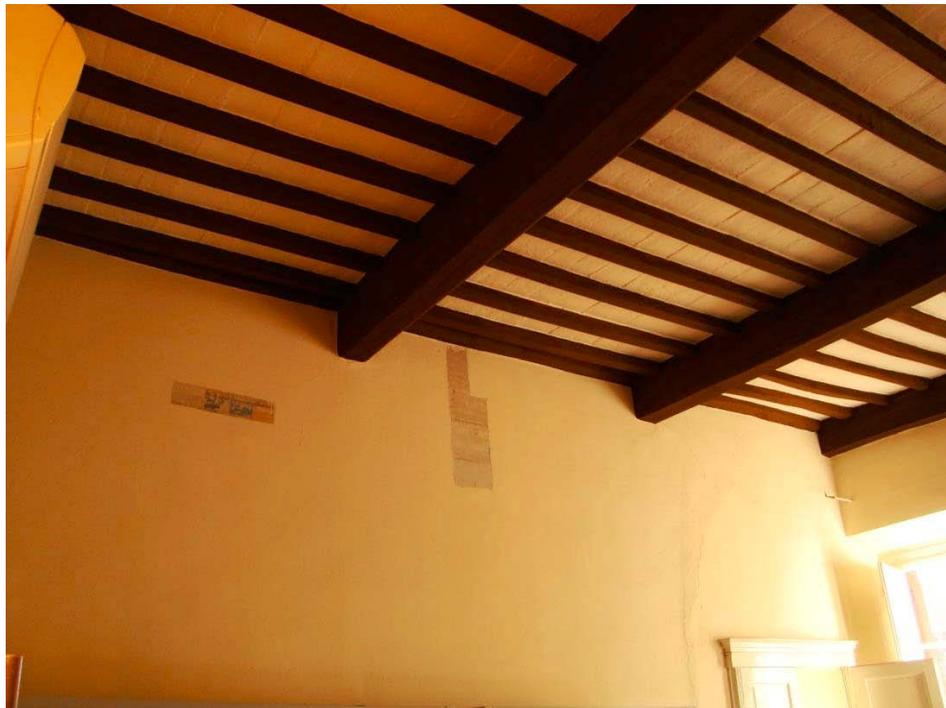
**Figura 4.21** – Intradosso di un solaio ligneo al secondo piano dell'ex porzione Del Torto.
