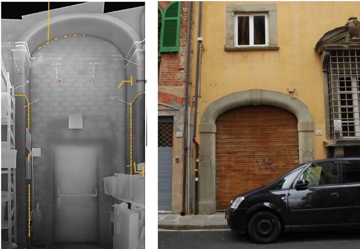
**Figura 3.67** - Apertura alla base della parete con la merlatura e portale cinquecentesco creato alla chiusura del vicolo a ovest. Da notare la somiglianza tra gli stilemi delle due aperture.
