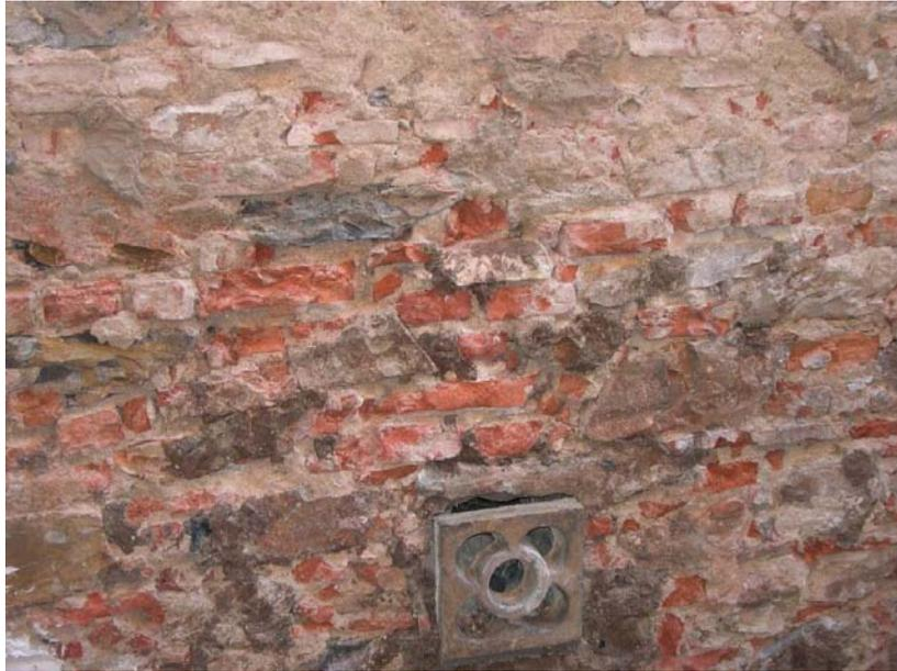
**Figura 4.15** – Particolare tessitura in mattoni pieni e inserti lapidei della muratura esterna a piano terra della parete 2 su via San Martino.
