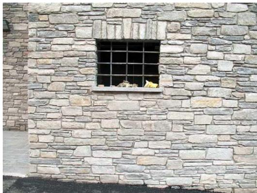
**Figura 1.2** – Muratura di blocchi di pietra con connessioni in malta.
