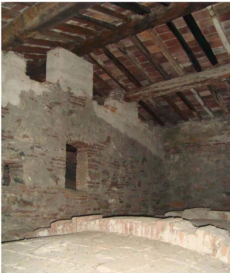
**Figura 4.29** – Intradosso della copertura dell'ala ovest e vista dell'estradosso della volta sottostante.
