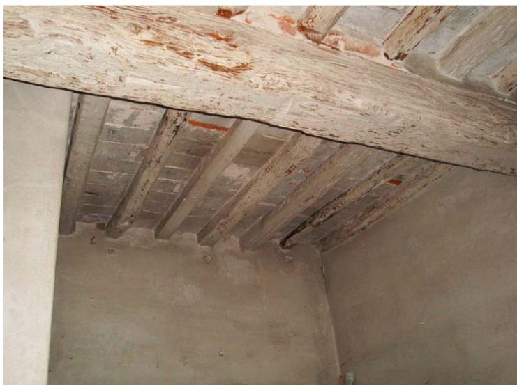
**Figura 4.23** – Intradosso di un solaio ligneo al secondo mezzanino dell'ex porzione Del Torto.
