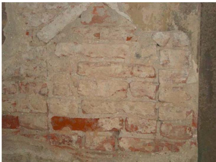
**Figura 4.17** –Particolare tessitura muratura a piano terra in mattoni pieni: parete interna, ortogonale via S. Martino.
