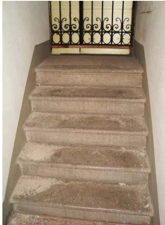
**Figura 4.31** – Prima rampa dello scalone principale nella porzione ovest del corpo centrale, con copertura in volta rampante affrescata e gradini in pietra serena. Gradini prefabbricati della scala nella porzione est del corpo centrale.
