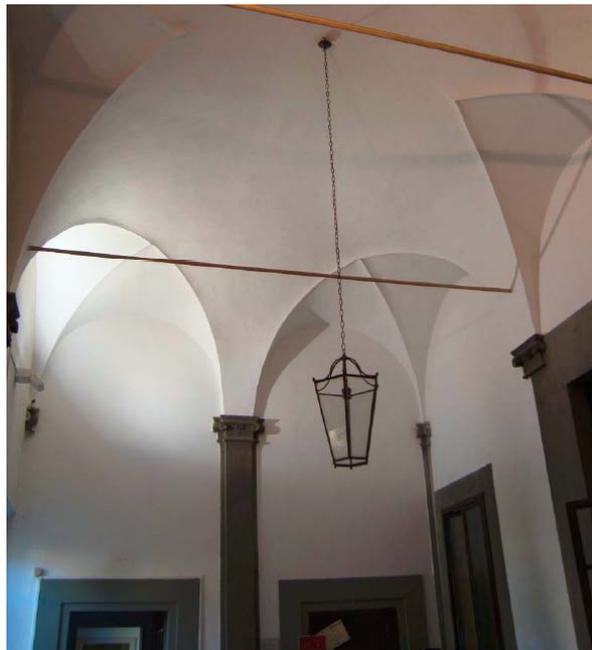
**Figura 4.19** – Volta a padiglione unghiata sopra al vestibolo al primo piano.
