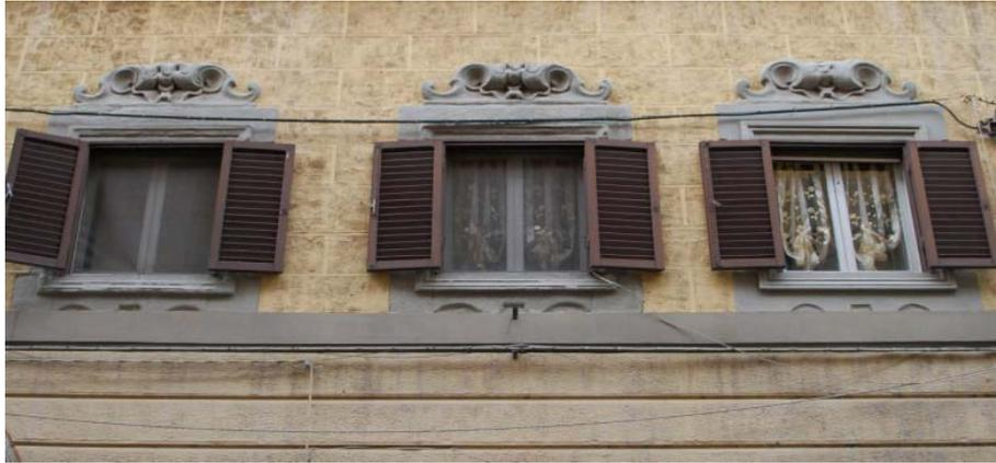
**Figura 3.15** – Finestre con cornici in arenaria del primo mezzanino della ex porzione Del Torto.
