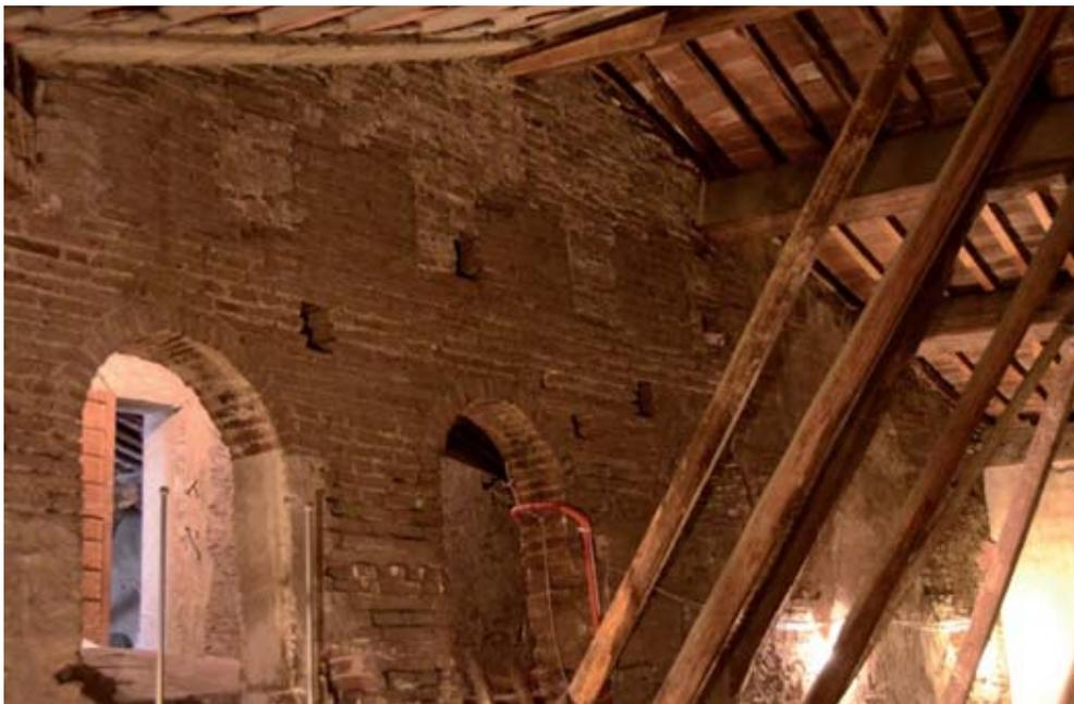
**Figura 3.63** – Individuazione sulla pianta del piano terra della parete con merlature nel sottotetto e foto delle stesse.
