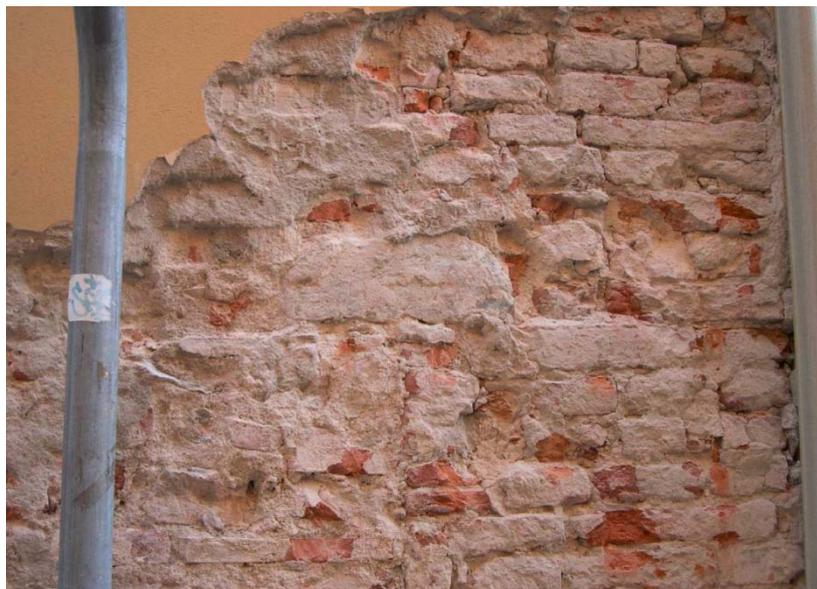
**Figura 4.14** – Particolare tessitura in mattoni pieni della muratura esterna a piano terra della parete 2 su via San Martino.
