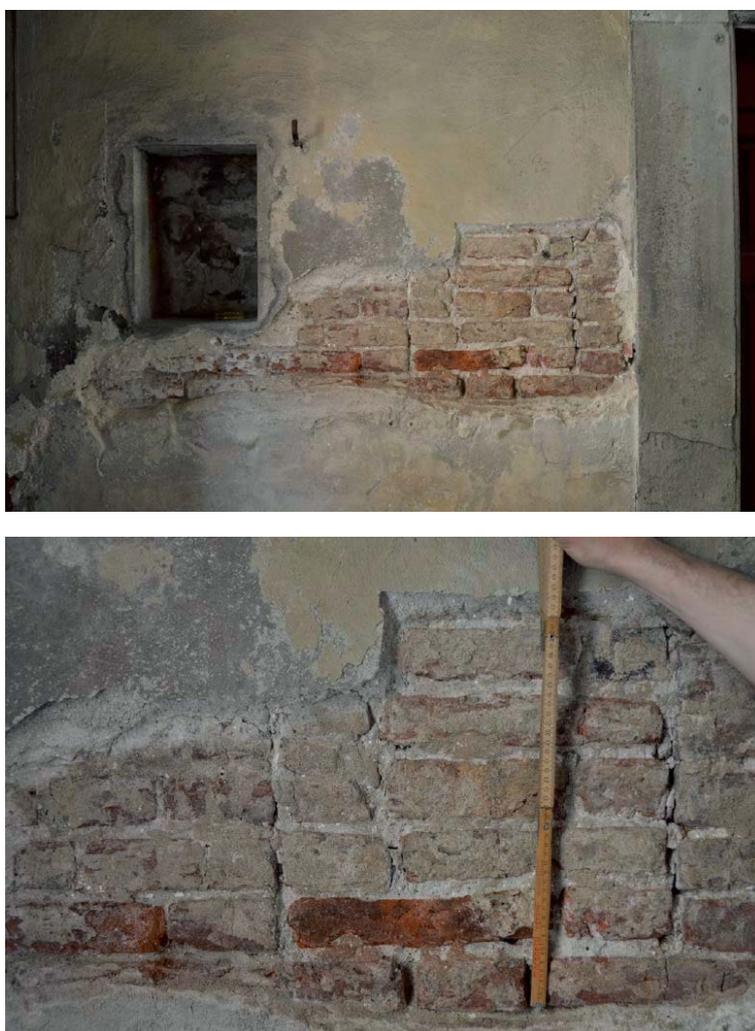
**Figura 4.43** – Paramento murario al piano terra della ex porzione Lanfranchi, in cui è ben leggibile la tessitura.
