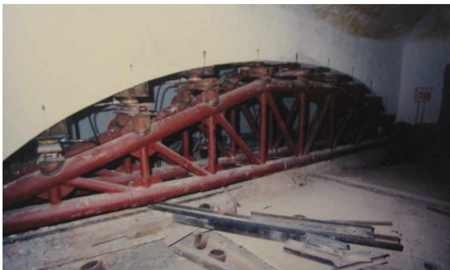
Figura 7.11: Realizzazione di una doppia trave reticolare posta sotto un arco al piano primo (fonte: Archivio Fotografico dell'Università di Bologna).
