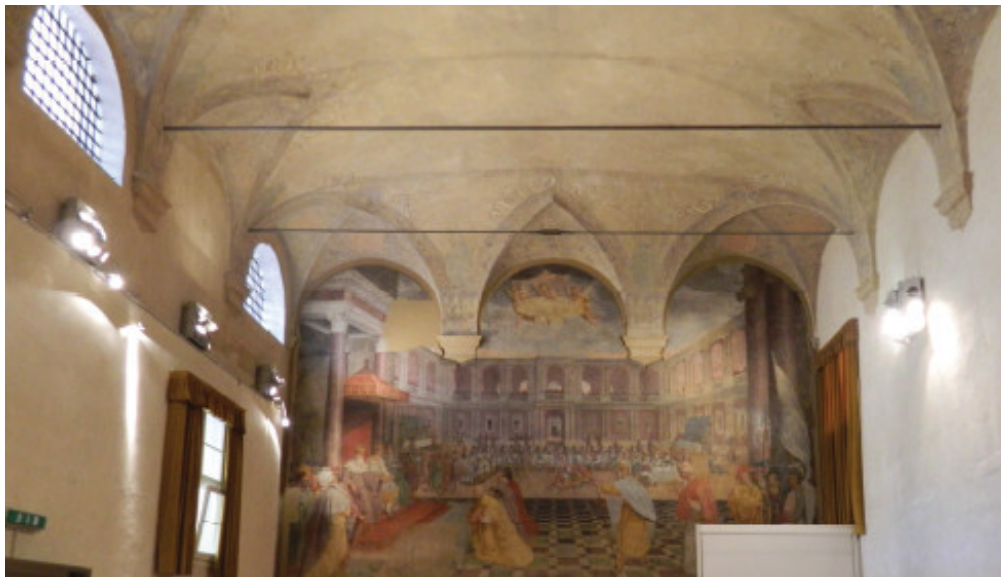
Figura 6.18: Aula Prodi. La volta a botte con teste di padiglione, lunettata (fonte: [16, pag.63]).
