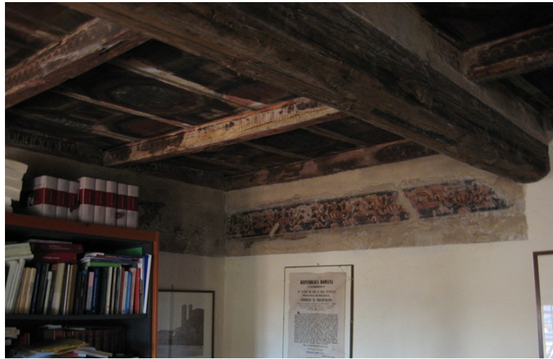
Figura 6.15: Solaio in legno al terzo piano, torretta sopra l'aula Prodi.
