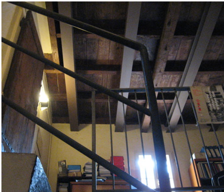
Figura 6.14: Solaio con travi in acciaio e in legno al secondo piano, studi docenti sopra l'aula Prodi.
