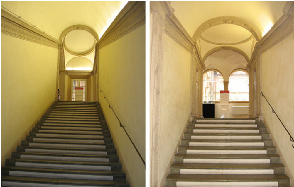
Figura 6.17: Strutture voltate dello scalone monumentale, tra il piano terra e il piano primo.
