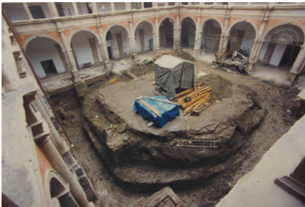
Figura 5.18: Lavori di scavo nel chiostro grande (fonte: Archivio Fotografico dell'Università di Bologna).
