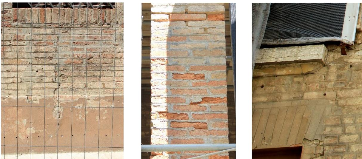
Figura 27: Particolare delle parti più ammalorate che lasciano intravedere la tessitura muraria al di sotto dello strato di intonaco. (a sinistra a destra) sotto finestra e zoccolatura del prospetto su via Curtatone, colonna del loggiato su piazza Mazzini e architrave e sotto finestra del prospetto su vicolo del Palazzo (fotografia scattata da Bertolino Elisa il 28 maggio 2014)
