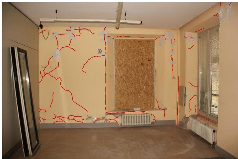
Figura 84 : Parete ortogonale alla direzione del sisma
