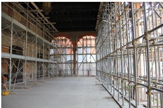
Figura 95 : Ponteggio di sostegno nel loggiato su Piazza Costituente
