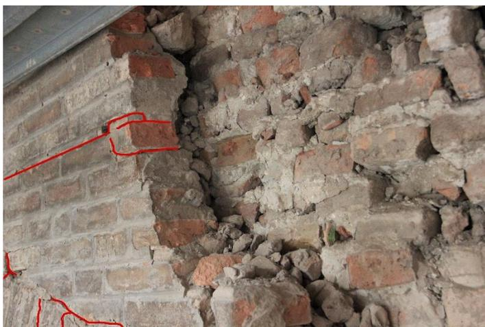
Figura 78 : Cedimento del primo strato del paramento murario al piano terra su Piazza Costituente
