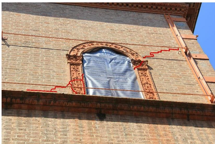
Figura 81 : Rottura della muratura a presso-flessione in Via Curtatone con possibile cinematisma fuori dal piano della facciata di Piazza Costituente
