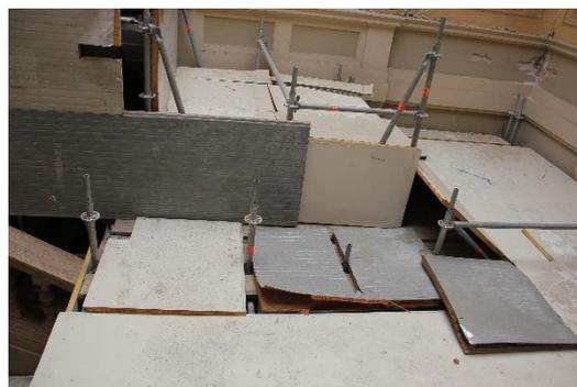
Figura 93 : Ponteggio protettivo nello scalone interno
