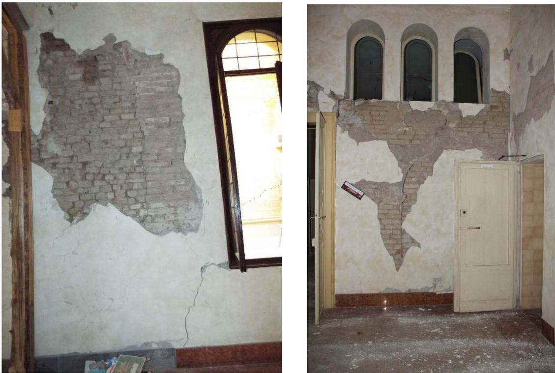
Figura 53: Fotografie della discontinuità muraria in due punti distinti del disimpegno al piano primo.
