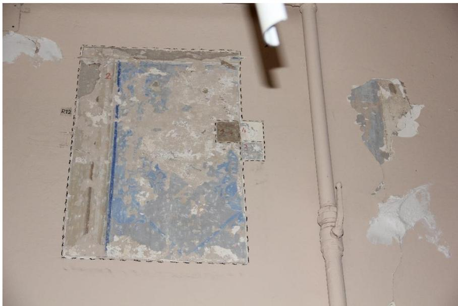
Figura 50: Tecnica del Descialbo nell'ufficio Protocollo al primo piano
