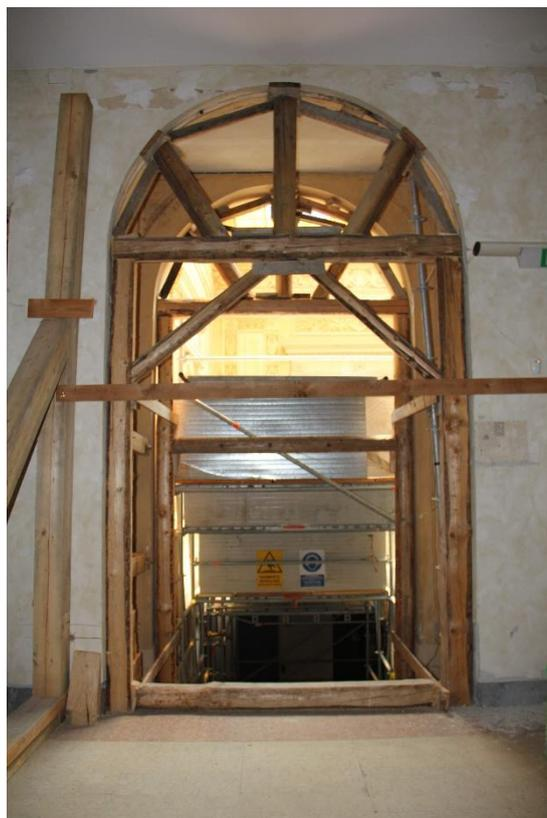
Figura 97 : Un esempio di centina montata al piano primo
