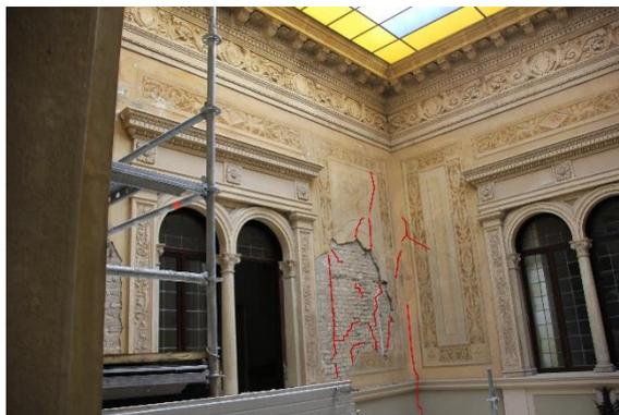
Figura 88 : Distacco dell'intonaco decorato dello scalone interno
