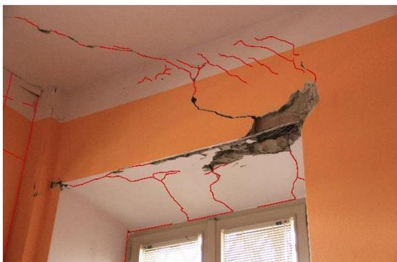
Figura 83 : Tipiche fessurazioni sulle finestre al piano terreno nei locali URP su Via Curtatone
