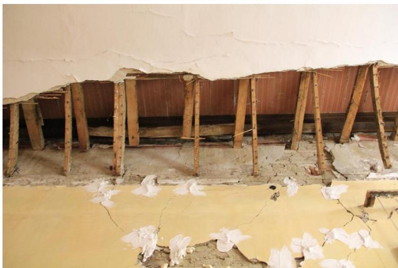
Figura 90 : Crollo del solaio cannicciato nella Sala Gialla
